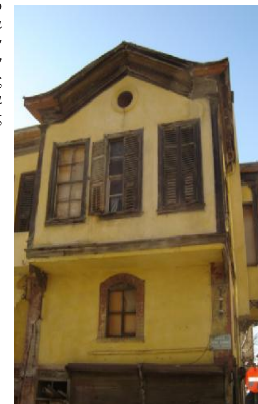
9. Δίριχτη στέγη επί της οδού Αγίας Σοφίας
