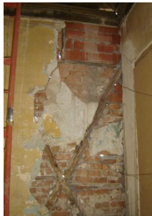
6. Τοίχος με τσατμά και οπτόπλινθους
