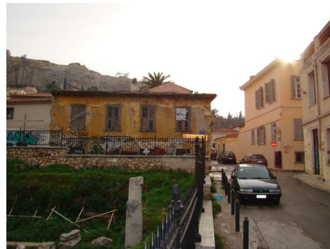
Εικ.121 Δημόσιο κτήριο επί της οδού Διοσκουρών και Πολυγνώτου απέναντι από το κτήριο μελέτης.
