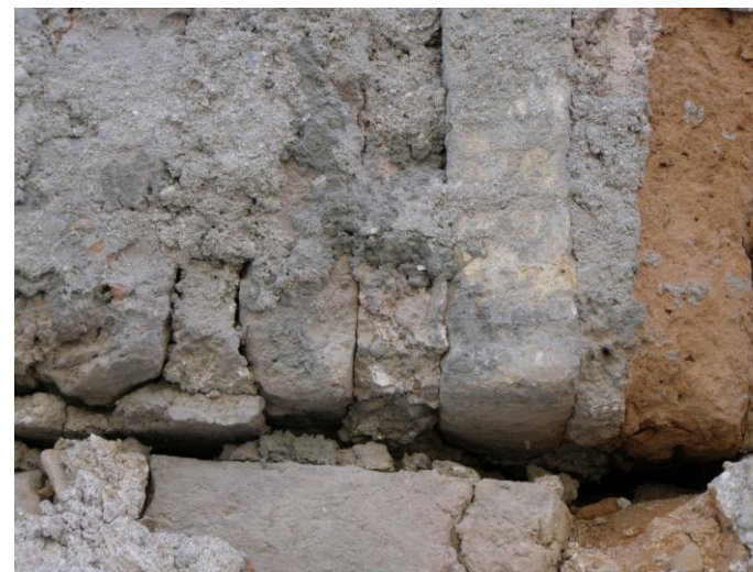
Λεπτομέρεια εξωτερικής τοιχοποιίας.
