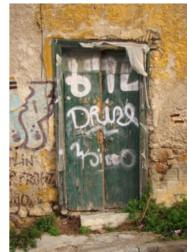
Εικ.123 Δίφυλλη πόρτα στην δυτική πλευρά του κτηρίου επί της οδού Διοσκούρων. (κεντρική είσοδος του κτηρίου)
