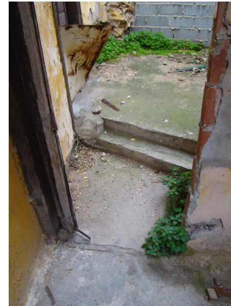
Εικ.133 Δάπεδο χώρου III καλυμμένο με σκυρόδεμα.
