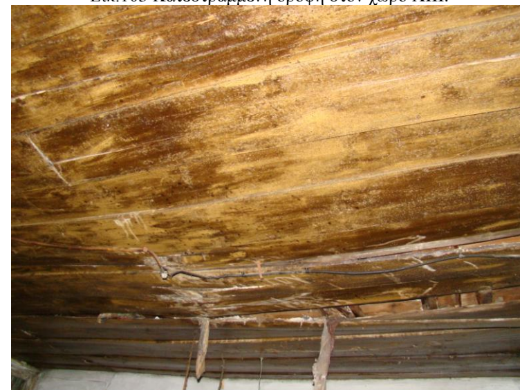
Εικ.104 Σανίδες σε κάμψη της οροφής του χώρου XIV.
