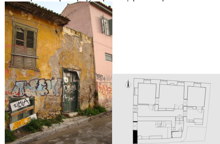
Εικ.24 Δεύτερη είσοδος επί της οδού Διοσκούρων με πρόσβαση στο υπόγειο και η θέση της στην κάτοψη του υπογείου.
