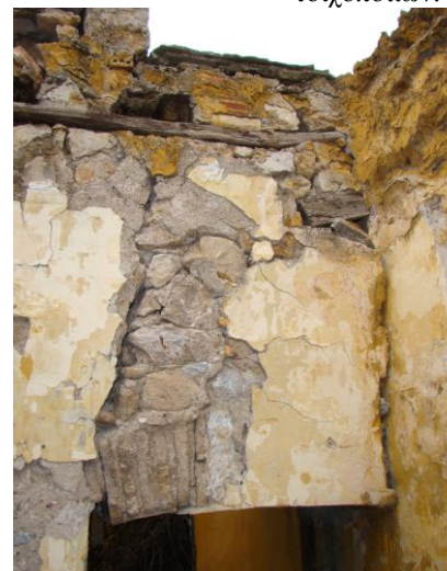
Εικ.143 Αποκόλληση τμήματος της τοιχοποιίας και του τόξου στον χώρο II πάνω από το άνοιγμα 04.
