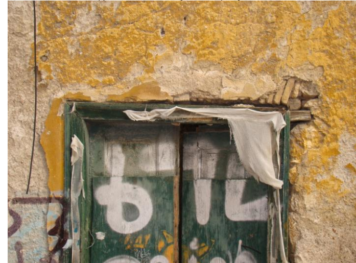
Εικ.64 Τάβλες τοποθετημένες στην εξωτερική πλευρά του ανοίγματος I στην δυτική πλευρά του κτηρίου.
