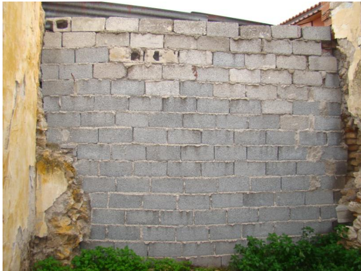
Εικ.69 Τσιμεντόλιθοι στον χώρο III μετά την καθαίρεση της νοτιοανατολικής τοιχοποιίας.
