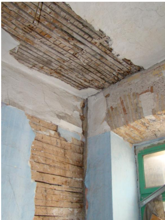
Εικ.105 Αποσάθρωση του επιχρίσματος σε φέρων και μη φέρων τοιχοποιία και στην οροφή του χώρου VII στο ισόγειο.
