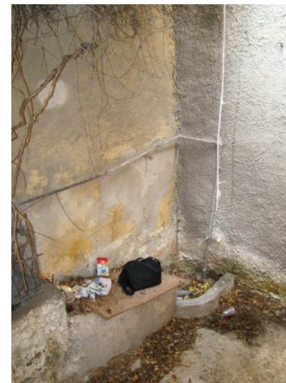
Εικ.117 Σωληνώσεις και η γούρνα στην νοτιοδυτική γωνία της αυλής.
