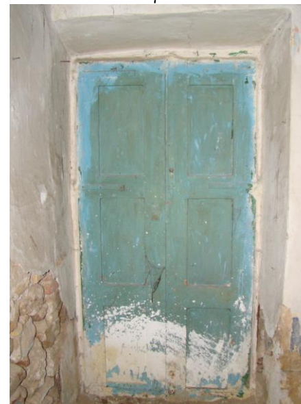
Εικ.96 Εσωτερικό άνοιγμα 9 χώρου XIII υπογείου.
