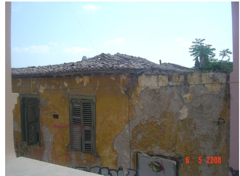
Εικ.72 Αποψη στέγης από την δυτική πλευρά του κτηρίου.
