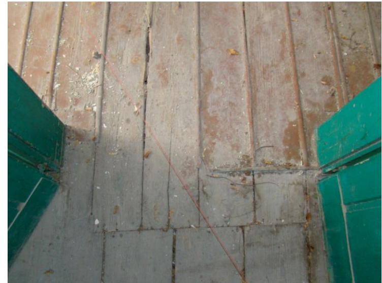
Ευθυγραμμία που χρησιμοποιήθηκε για την μέτρηση των χώρων.
