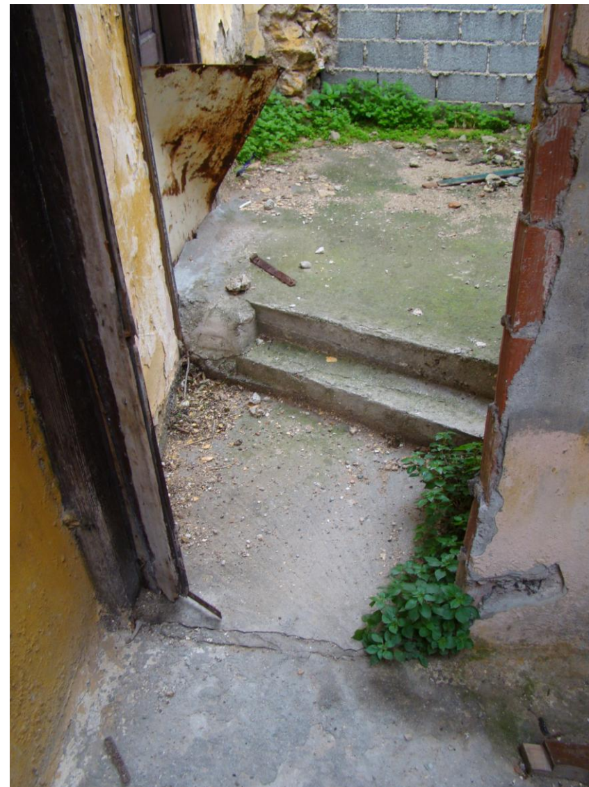
Εικ.74 Δάπεδο χώρου III καλυμμένο με σκυρόδεμα.
