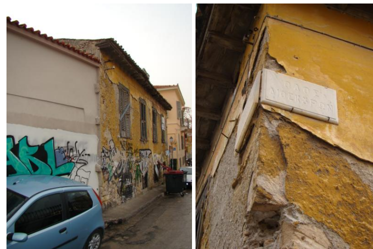
Εικ.26 α ,26β Λαξευτά αγκωνάρια στις δύο γωνίες του κτηρίου: Αριστερή εικόνα επί της οδού Πολυγνώτου, Δεξιά εικόνα επί των οδών Διοσκούρων και Πολυγνώτου
