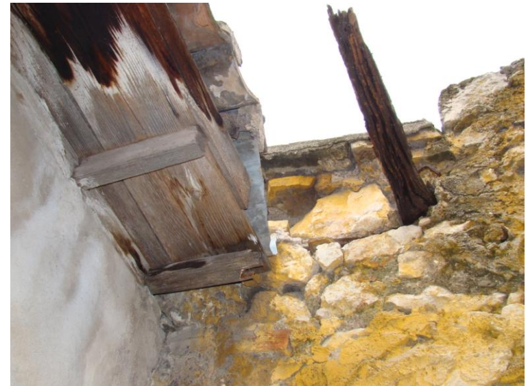
Εικ.60 Διαφορά ύψους μεταξύ των χώρων VI και III: προσθήκη που επέβαλε την αφαίρεση τμήματος της στέγης.
