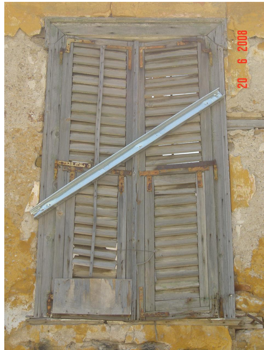
Εικ.94 Εξώφυλλο του ανοίγματος 07 στο ισόγειο επί της οδού Πολυγνώτου.
