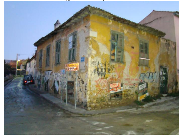
Εικ.3 Άποψη βορειοδυτικής γωνίας του κτηρίου επί των οδών Διοσκούρων και Πολυγνώτου.
