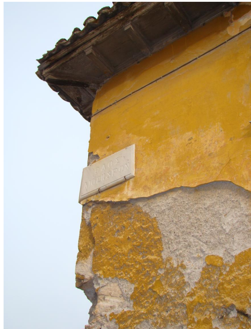
Εικ.148 Εξωτερικός χρωματισμός του κτηρίου (βορειοδυτική άποψη της οδού Διοσκούρων).
