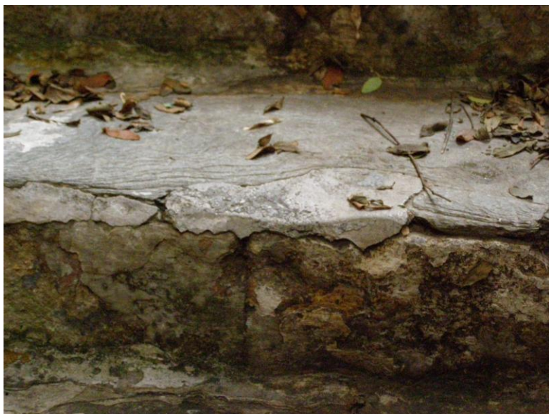
Λεπτομέρεια της κλίμακας που οδηγεί στον ισόγειο.
