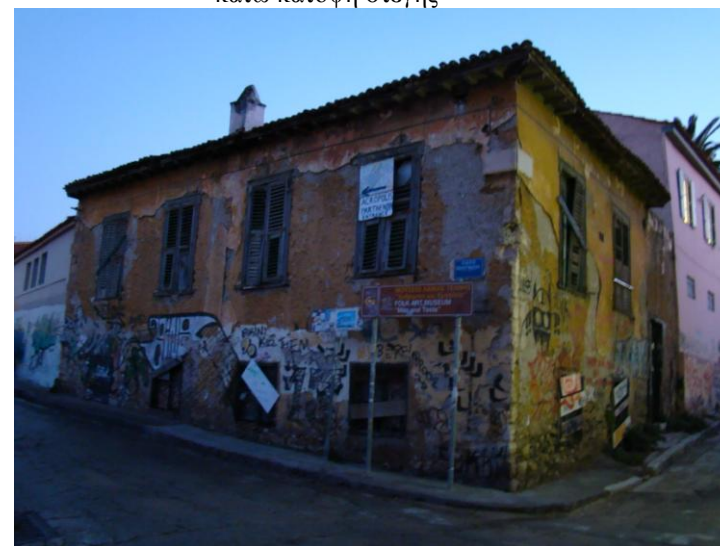
Εικ.21 Βόρεια όψη κτηρίου επί της οδού Πολυγνώτο
