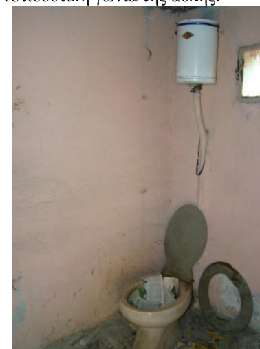
Εικ.118 Χώρος ΙΙ: τουαλέτα στο ισογείο.
