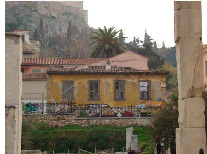
Εικ.2.Άποψη βόρειας πλευράς του κτηρίου επί της οδού Πολυγνώτου.
