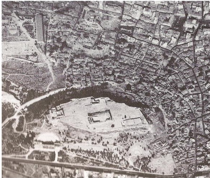
Εικ10 Αεροφωτογραφία της περιοχής της Πλάκας το 1960.
