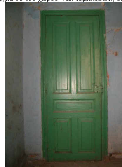
Εικ.30. Άνοιγμα 01 του χώρου V: ταμπλαδωτή εσωτερική διπλή θύρα.
