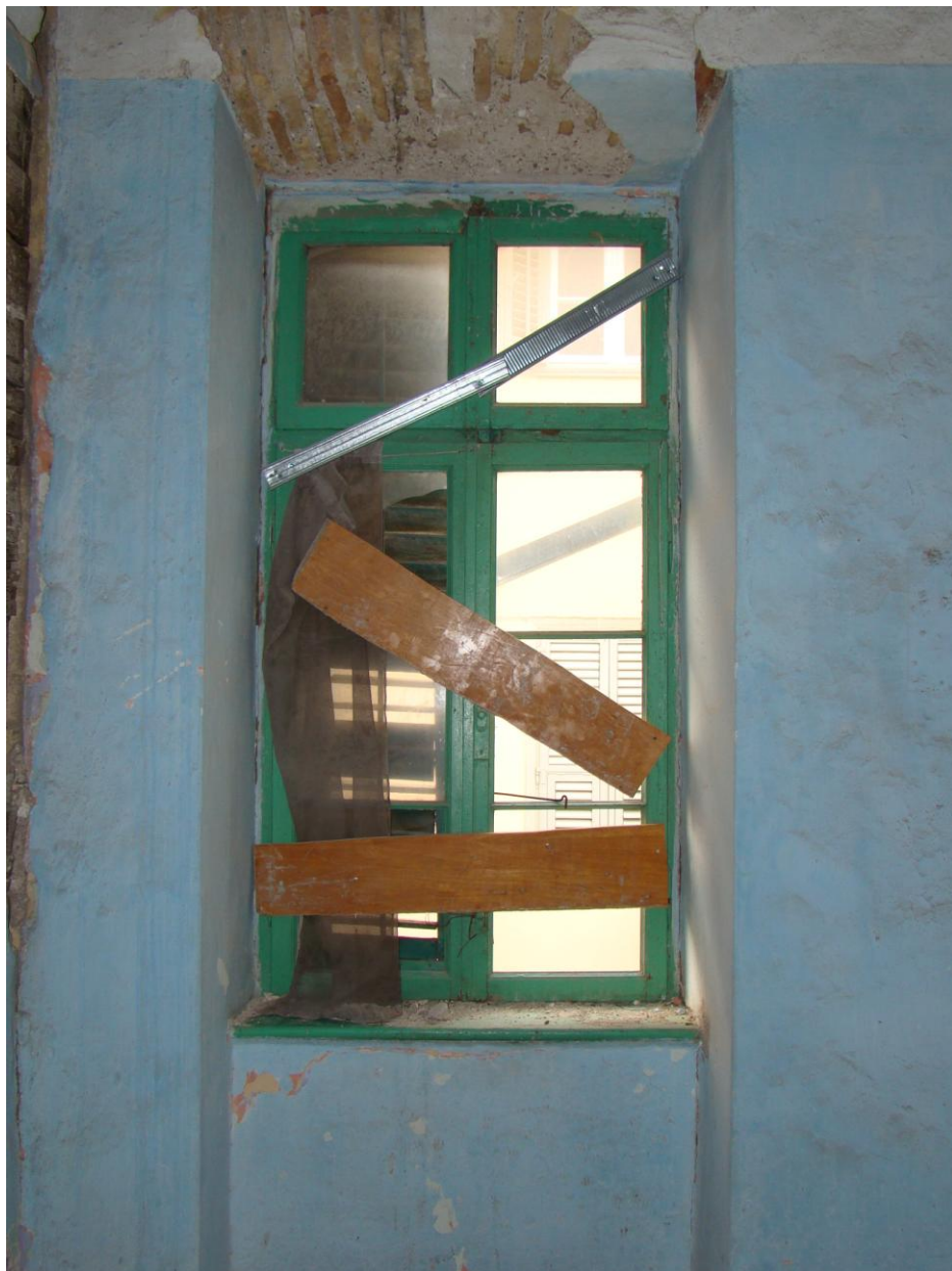
Σφράγιση του ανοίγματος ισογείου με ταμπλάδες και από την εσωτερική πλευρά του κτηρίου.
