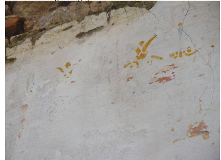
Εικ.32 Χρωματικός διάκοσμος στον ανατολικό τοίχο του χώρου VI στο ισόγειο.
