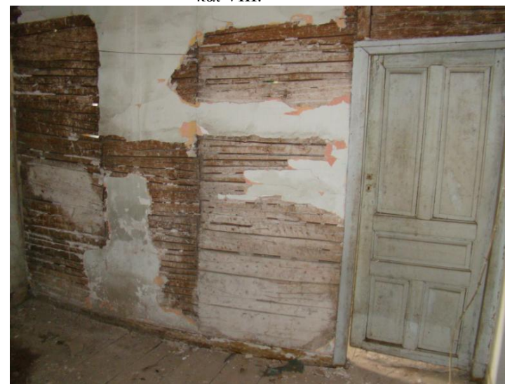
Εικ.66 Καθίζηση τμήματος του δαπέδου στον χώρο VIII.
