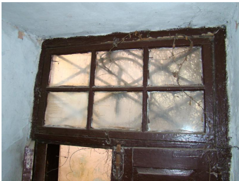
Εικ.93 Φεγγίτης στο άνοιγμα 02 της εισόδου του ισόγειου.
