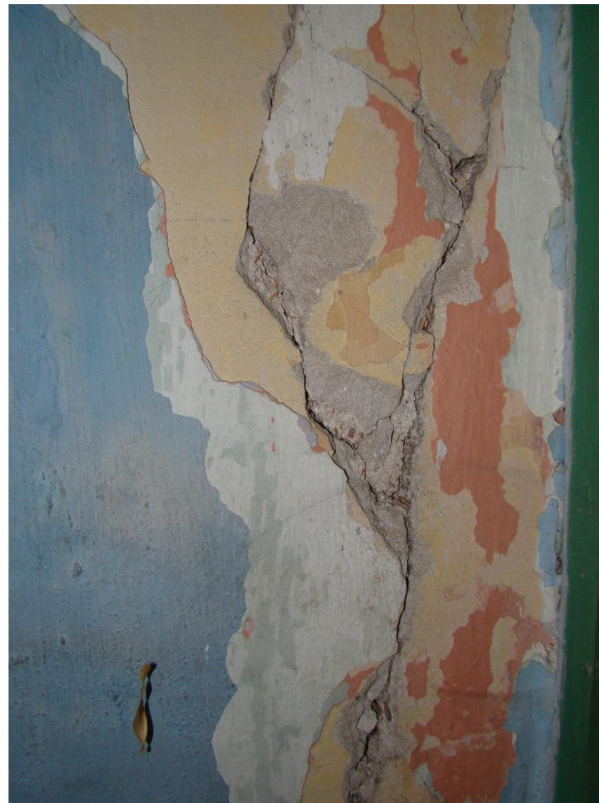
Εικ.56 Στρώματα χρωμάτων που έχουν αποκαλυφθεί στην νοτιοανατολική γωνία του χώρου VII του ισογείου.
