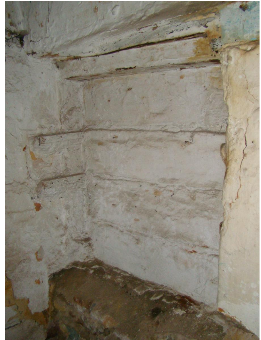
Εικ.40. Ερμάριο στην βόρεια τοιχοποιία του χώρου XII του υπογείου.
