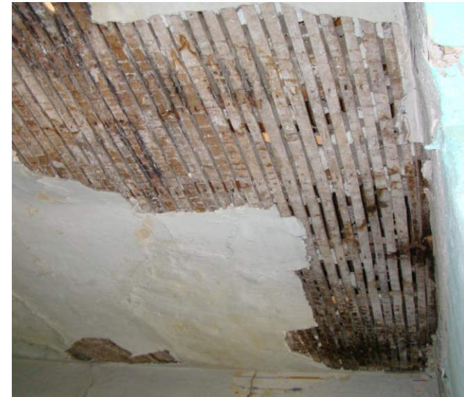
Εικ.101 Ξύλινη οροφή του ισογείου στον χώρο V του ισογείου.
