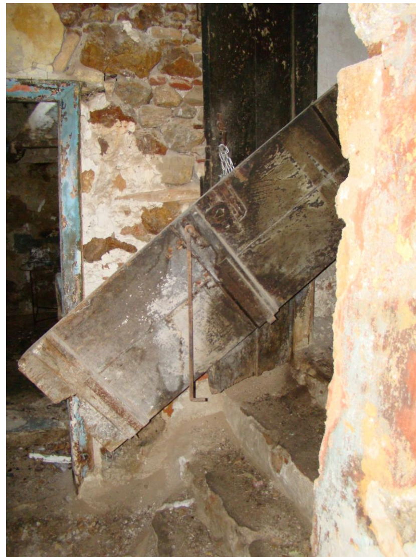
Εικ.51 Πέτρινα σκαλοπάτια στην ανατολική γωνία του κτηρίου καλυμμένα με σκυρόδεμα.
