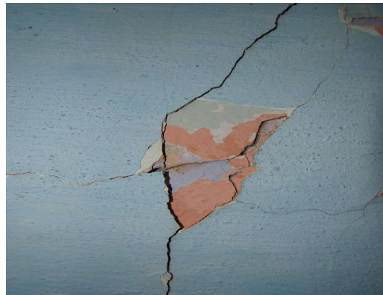
Εικ.108 Στρώματα χρωματισμών στο ισόγειο (χώρος VIII).
