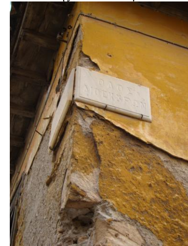
Εικ.70β- Λαξευτά αγκωνάρια επί των οδών Διοσκούρων και Πολυγνώτου.
