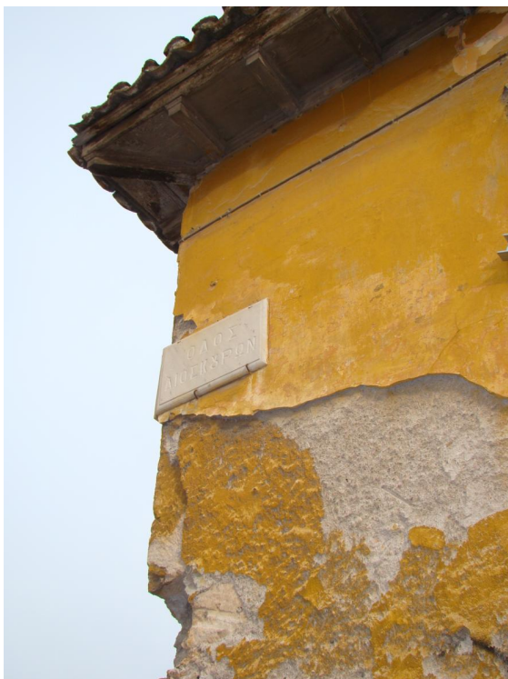
Εικ.107 Εξωτερικός χρωματισμός του κτηρίου: βορειοδυτική άποψη της οδού Διοσκούρων.
