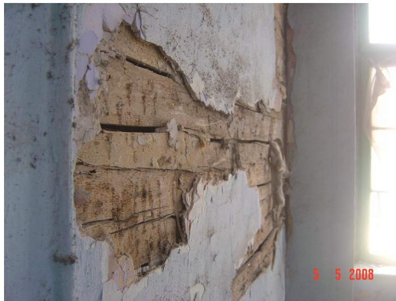
Λεπτομέρεια από τον μπαγδατότοιχο του ισογείου στον κεντρικό χώρο.
