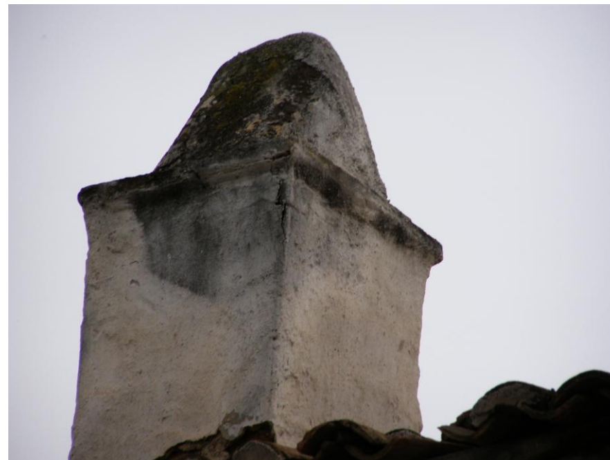
Λεπτομέρεια της καμινάδας στην βόρεια πλευρά του κτηρίου.
