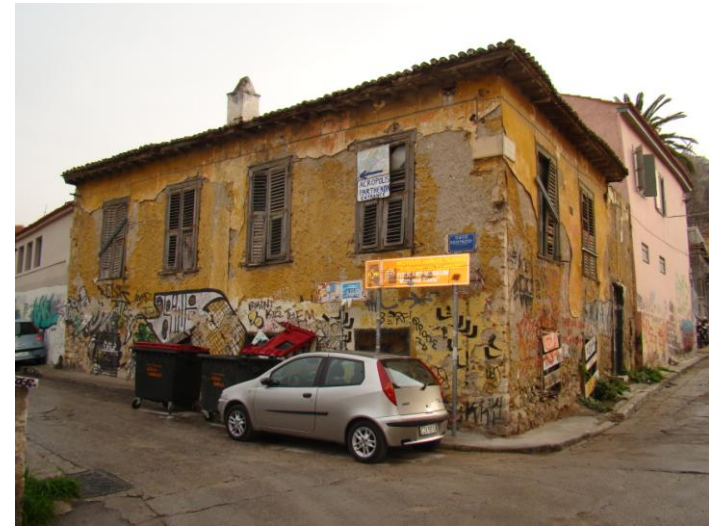
Εικ.63 Τοποθετημένες τάβλες στην εξωτερική μεριά των ανοιγμάτων και στις δύο όψεις.
