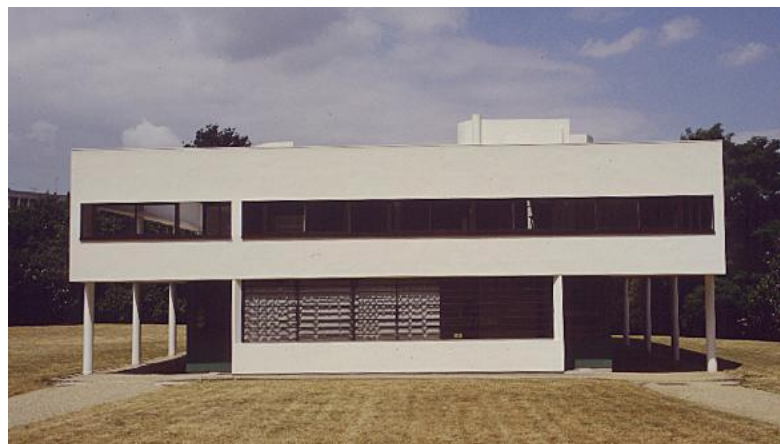
(εικ.29) Όψη Κτιρίου
