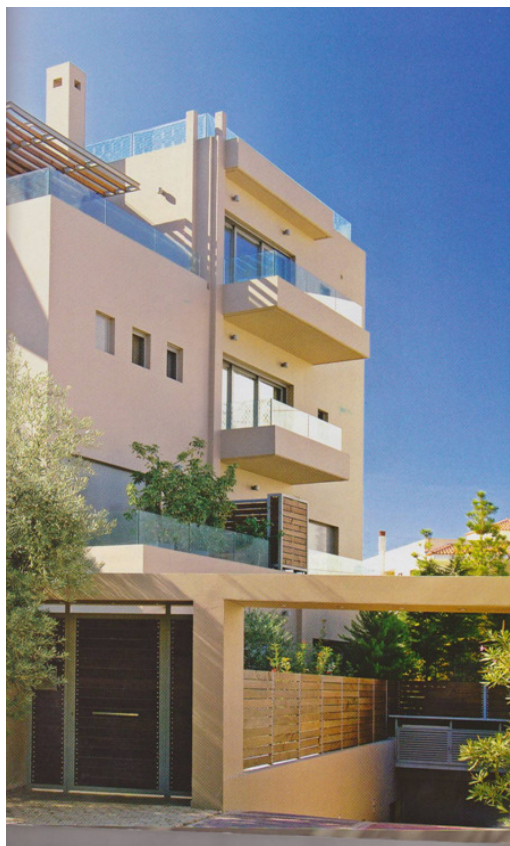
Εικόνα 2: Πλάγια όψη, εξωτερική είσοδος.
