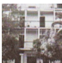
Εικόνα: 1 Πολυκατοικία στην οδό Βουτσινά
