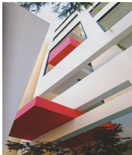
Εικόνα 2: Πλάγια όψη κτιρίου.
