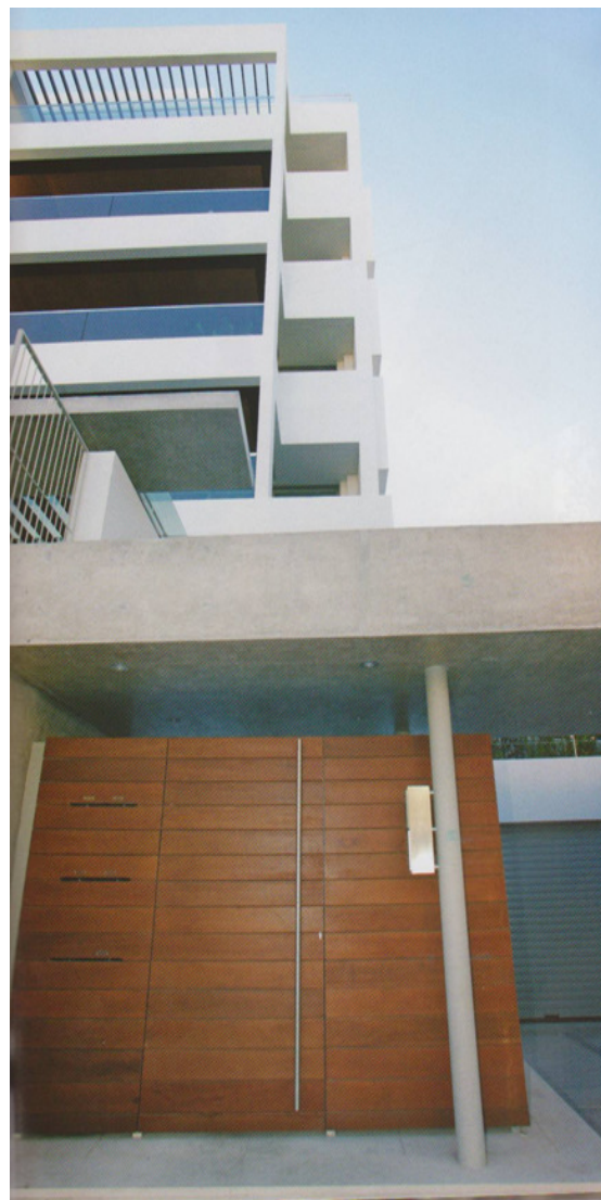
Εικόνα 1: Πρόσοψη κτιρίου, εξωτερική είσοδος.
