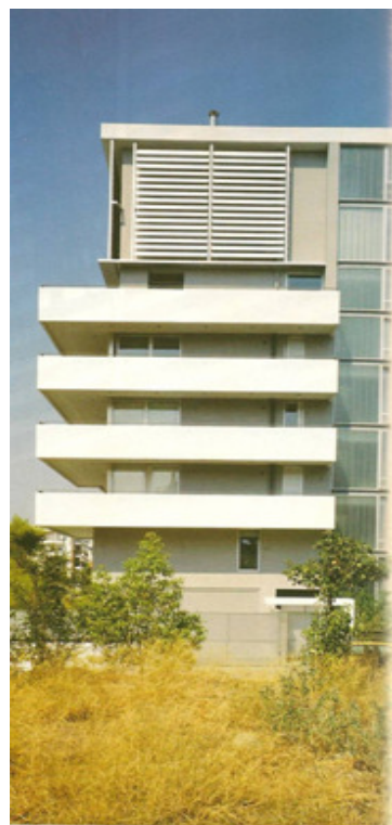
Εικόνα 2: Πλάγια όψη πολυκατοικίας.
