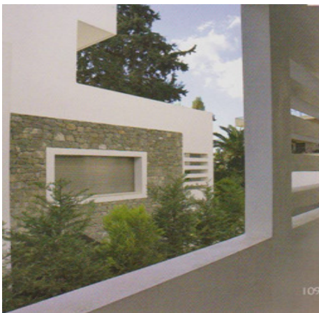
Εικόνα 4: Μινιμαλιστικές γραμμές των σοβατισμένων επιφανειών και ελεύθεροι σχηματισμοί από φυσική πέτρα, δημιουργούν οπτική ισορροπία.
