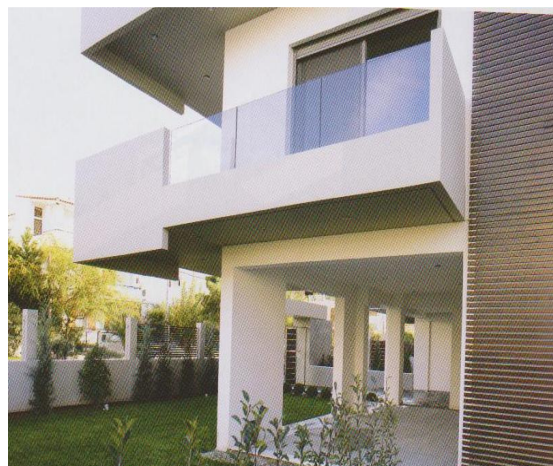
Εικόνα 4: Τμήμα πλάγιας όψης κτιρίου.
