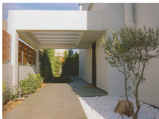
Εικόνα 3: Την κατοικία περιβάλλουν πέργκολες από οπλισμένο σκυρόδεμα.
