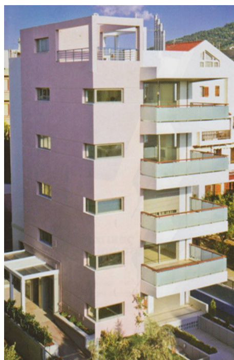
Εικόνα 2 : Πλάγια όψη κτιρίου.
