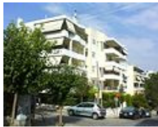
Εικόνα: 14 - Ανοικοδόμηση Χολαργού
