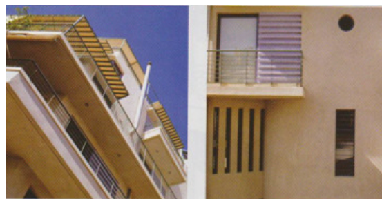
Εικόνα 2: Πλάγιες όψεις κτιρίου.
