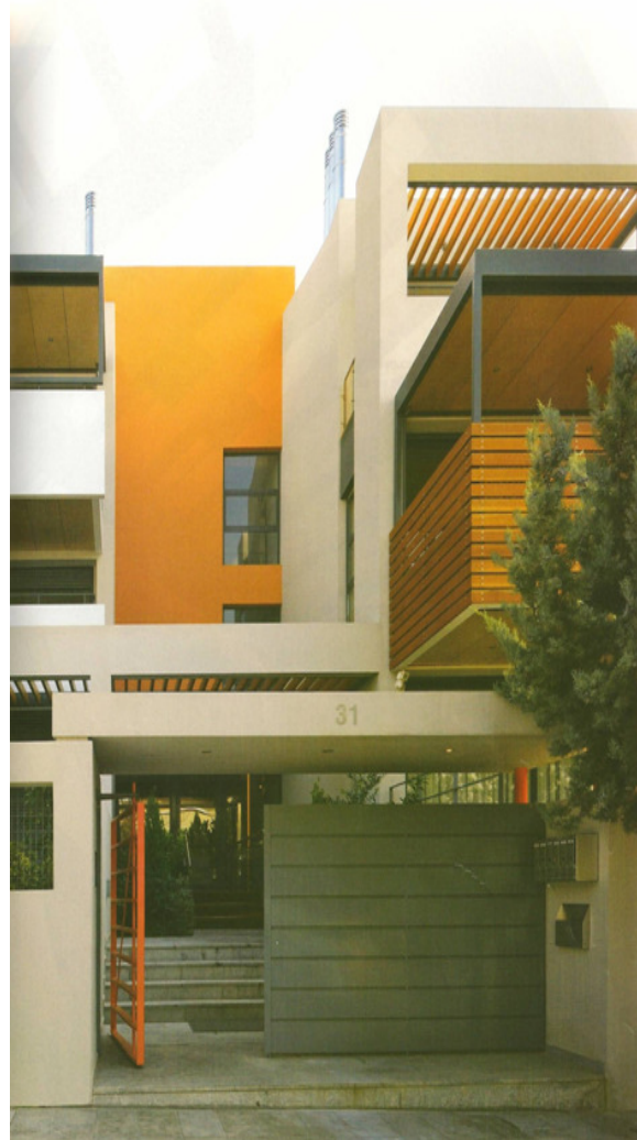
Εικόνα 1: Πρόσοψη πολυκατοικίας, τμήμα της κεντρική εξωτερικής εισόδου.
