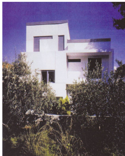
Εικόνα 3: Πίσω όψη κατοικίας.
