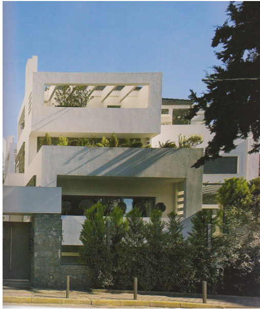
Εικόνα 2: Τμήμα προσόψεως συγκροτήματος.
