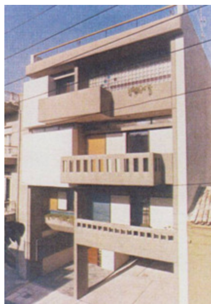
Εικόνα 1: Πρόσοψη πολυκατοικίας επί της οδού Σταματιάδου.
