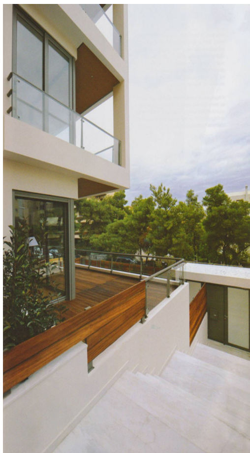
Εικόνα 7: Σκάλα ανόδου στην κεντρική είσοδο του κτιρίου.
