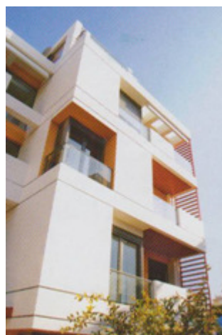
Εικόνα 4: Πλάγια όψη πολυκατοικίας.
