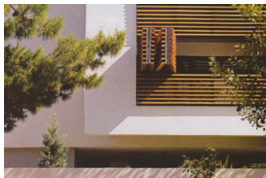
Εικόνα 3: Προβολή νοτιοδυτικής όψης, ανοιγόμενες ξύλινες περσίδες.
