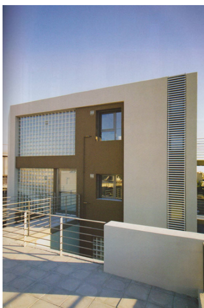
Εικόνα 5: Πλάγια όψη πολυκατοικίας.
