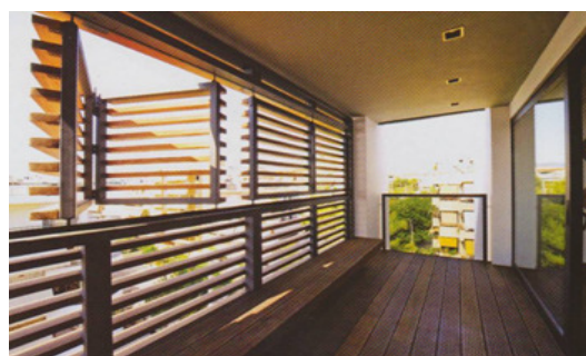
Εικόνα 4: Προβολή ξύλινων περσιδών από εσωτερική άποψη.
