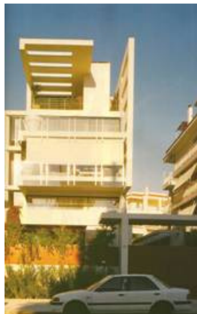
Εικόνα 1: Όψη, επί της οδού Παπάγου
