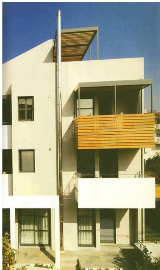
Εικόνα 2: Πλάγια όψη πολυκατοικίας.
