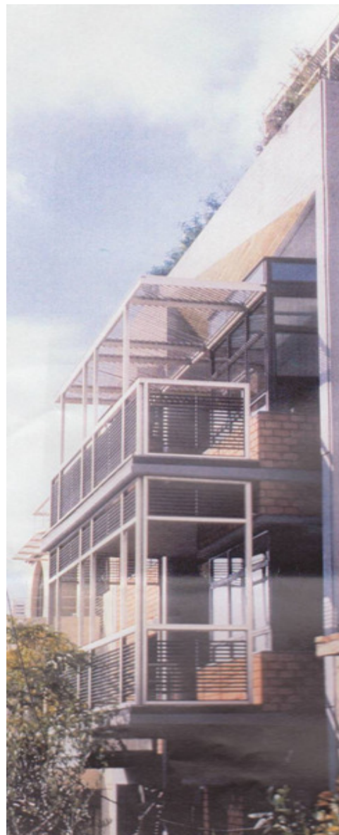
Εικόνα 1: Τμήμα της πρόσοψης, με τους εξώστες και τα σκιάδια ηλιοπροστασίας και ηλιοσυλλογής.
