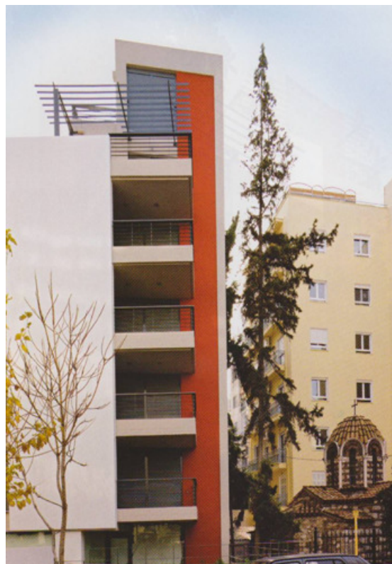
Εικόνα 2: Πλάγια όψη πολυκατοικίας.
