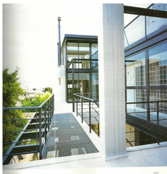
Εικόνα 6: Εξωτερική όψη κτιρίου, προβολή μεταλλικών κατασκευών.
