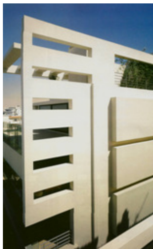
Εικόνα 2: Πλάγια όψη, προβολή κατακόρυφης πέργκολας.
