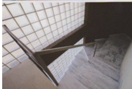
Εικόνα 6: Εσωτερική διαμόρφωση studios, λεπτομέρεια κλιμακοστασίου.
