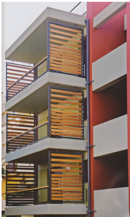
Εικόνα 2: Πλάγια όψη κτιρίου.
