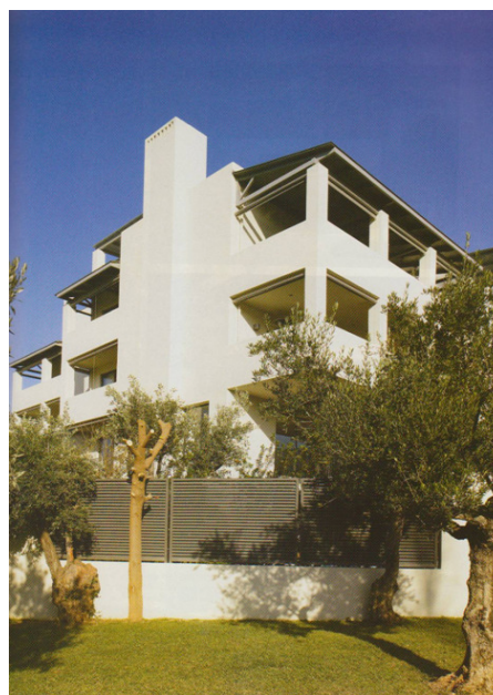
Εικόνα 1: Πλάγια όψη κτιρίου.
