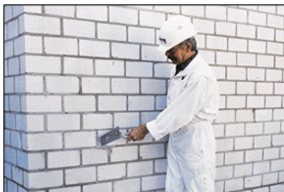
Εικόνα 5- 3 Προετοιμασία υποβάθρου
