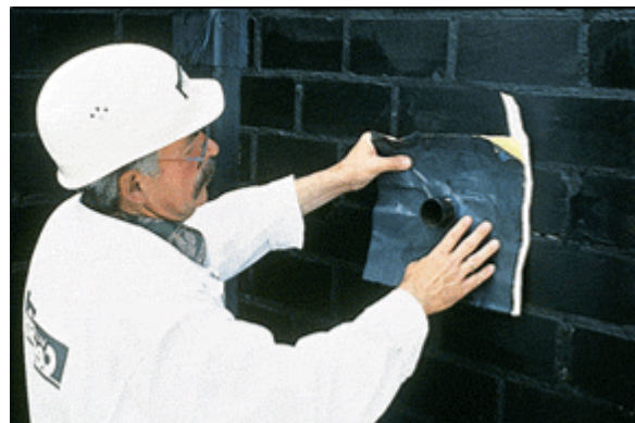
Εικόνα 5- 8 Τοποθέτηση μεμβράνης
