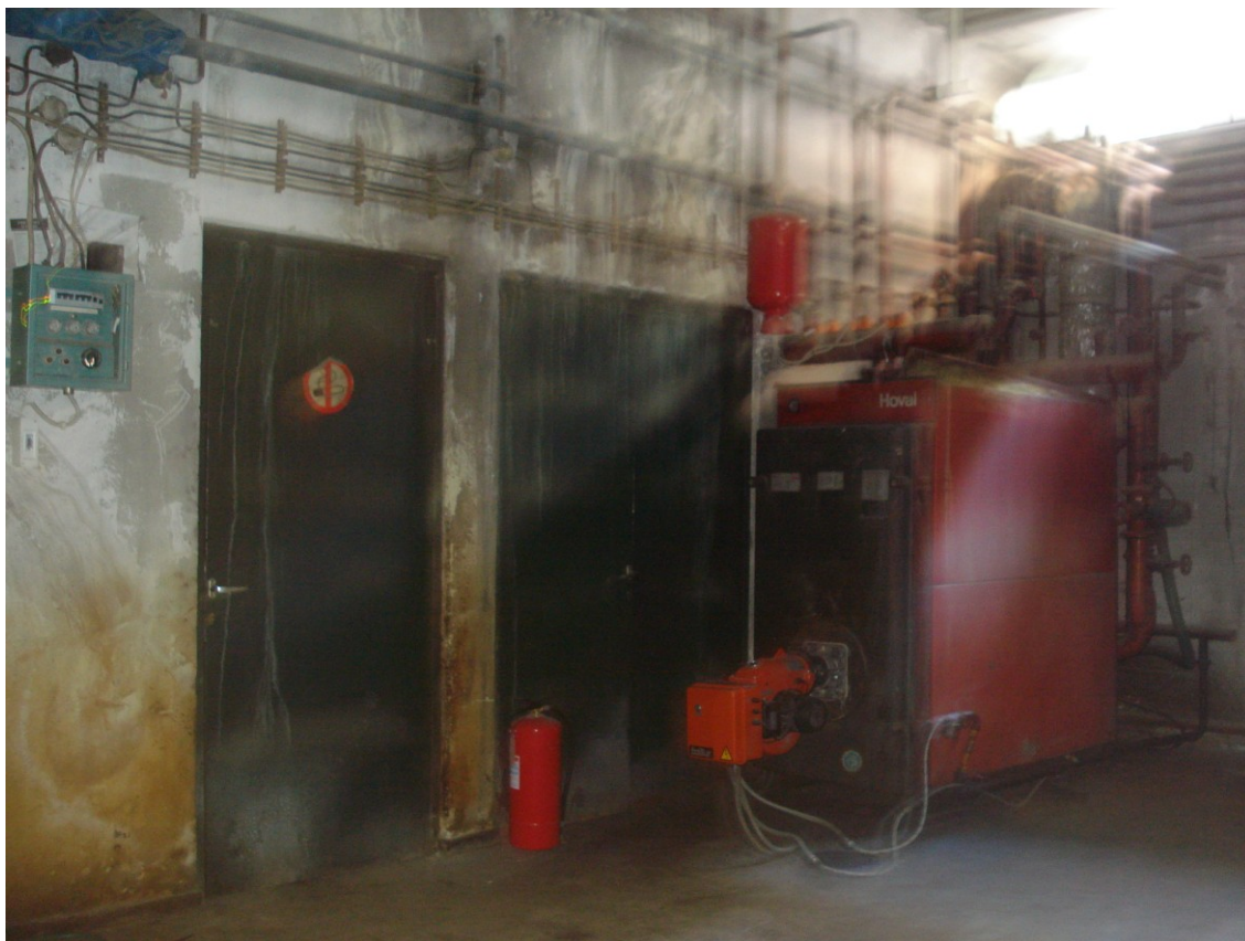
Εικόνα 6- 8 Ο χώρος του λεβητοστασίου, η υγρασία και οι ρύποι προκαλούν διαρκή φθορά στα στοιχεία του κτιρίου [προσωπικό αρχείο] .
