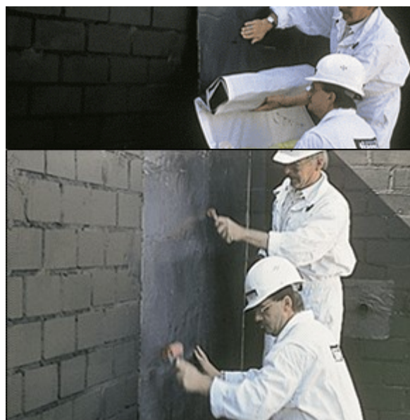
Εικόνα 5- 9 Στρώνσιμο με ροδάκι ή πανί
