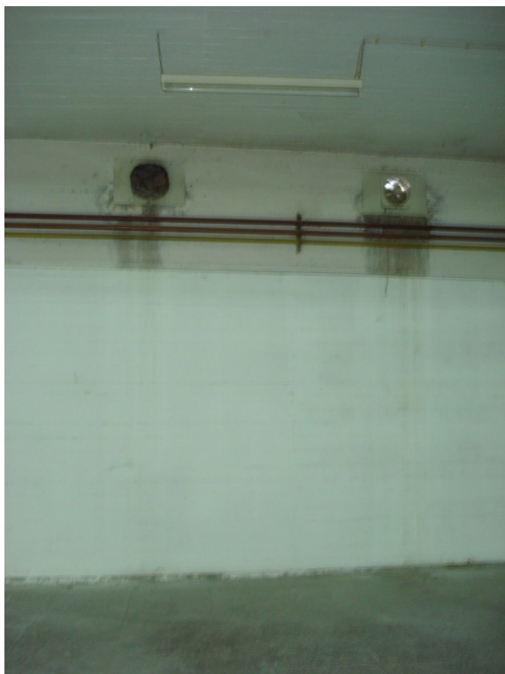
Εικόνα 6- 4 Οπές για την όδευση των εγκαταστάσεων εξαερισμού. Παρατηρείτε ότι έχουν διανοιχθεί στην δοκό, έτσι βγάζουμε το συμπέρασμα ότι οι περιμετρικές δοκοί είναι ανεστραμμένες [προσωπικό αρχείο] .
