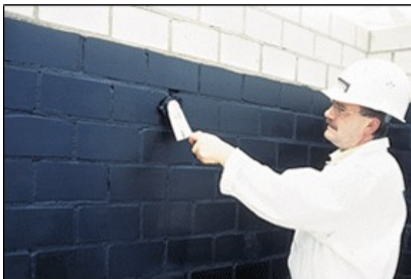
Εικόνα 5- 5 Σφράγιση ατελειών
