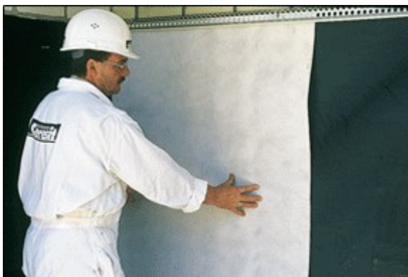
Εικόνα 5- 11 Τοποθέτηση γεφυφάσματος
