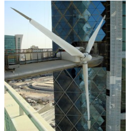
Ανεμογεννήτρια τοποθετημένη μεταξύ των πύργων
