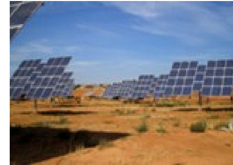
Τοποθέτηση φωτοβολταϊκών σε κεκλιμένα στηρίγματα
