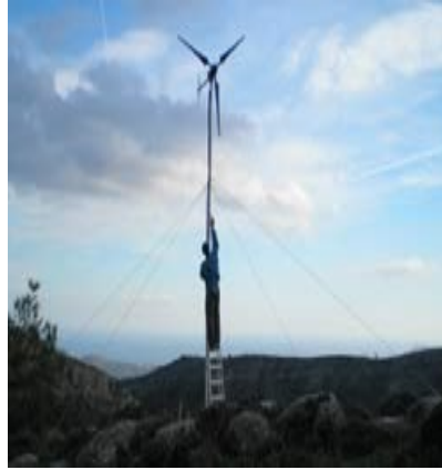
Εγκατάσταση ανεμογεννήτριας στην Ψίνθο, 900 Watt
