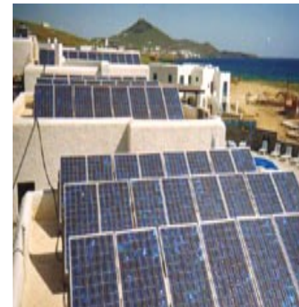
Εγκατάσταση διασυνδεδεμένων φωτοβολταϊκών σε ξενοδοχείο στην Πάρο, ισχύος 10KW που καλύπτει μέρος των ηλεκτρικών αναγκών του. Ωστόσο δεν συμβάλλουν στην καλαισθησία της εξωτερικής εμφάνισης του κτιρίου, κάτι το οποίο είναι αδύνατο να εγκατασταθούν αλλιώς τα πάνελ, αφού υπάρχει δώμα και όχι στέγη
