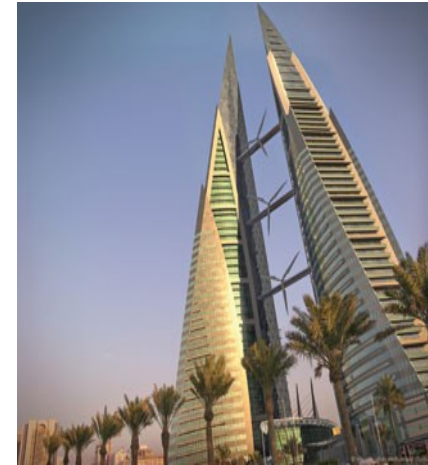
Το κέντρο εμπορίου του Μπαχρέιν με τις τρεις ανεμογεννήτριες στο διάκενο μεταξύ των πύργων
