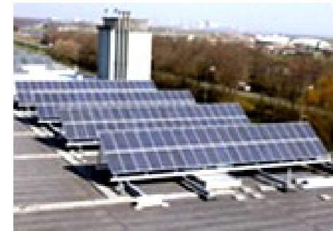
Τοποθέτηση φωτοβολταϊκών σε ειδική βάση
