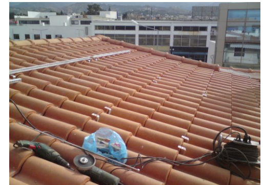
Στάδιο 3: επανατοποθέτηση κεραμιδιών και τοποθέτηση δοκών - ράγων
