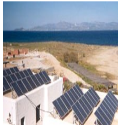
Εγκατάσταση διασυνδεδεμένων φωτοβολταϊκών σε ξενοδοχείο στην Πάρο, ισχύος 10KW που καλύπτει μέρος των ηλεκτρικών αναγκών του. Ωστόσο δεν συμβάλλουν στην καλαισθησία της εξωτερικής εμφάνισης του κτιρίου, κάτι το οποίο είναι αδύνατο να εγκατασταθούν αλλιώς τα πάνελ, αφού υπάρχει δώμα και όχι στέγη
