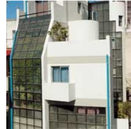
Βιοκλιματικό κτίριο κατοικίας στην Αθήνα.
