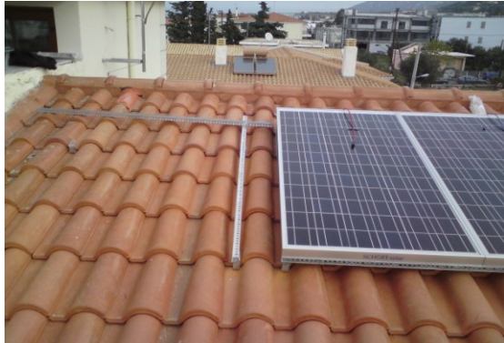
Στάδιο 4: Εγκατάσταση των φ/β στοιχείων
