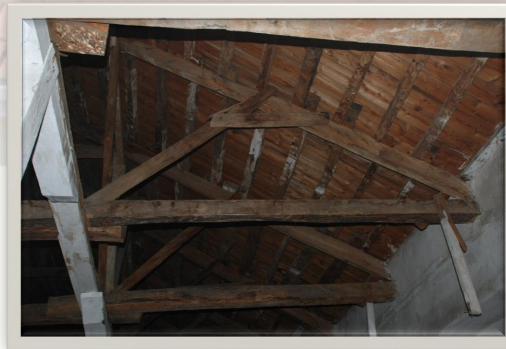
Εικ. 5.22: Κατασκευή στέγης
