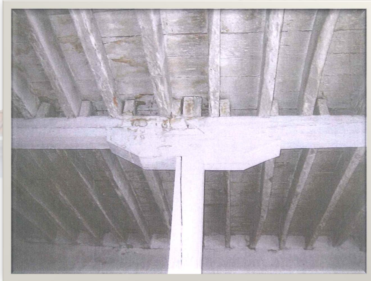
Εικ. 6.6: Ρωγμές στα υποστυλώματα
