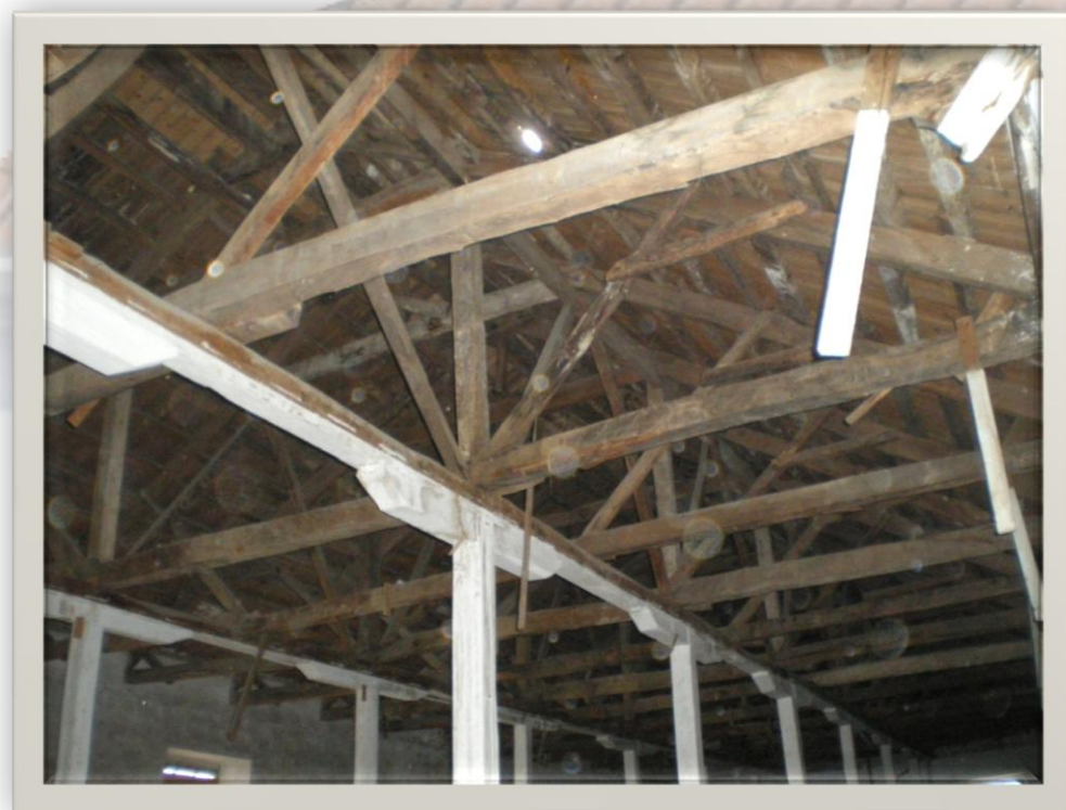
Εικ. 6.14: Εσωτερική άποψη της στέγης
