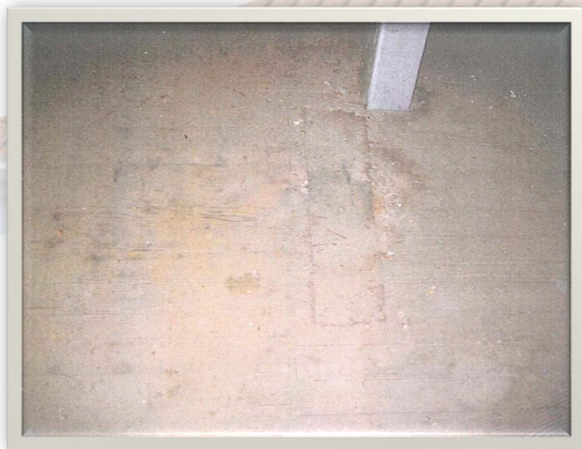
Εικ. 6.9: Νέο ξύλινο δάπεδο ορόφου
