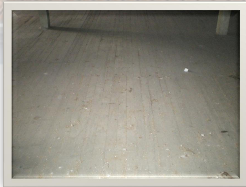
Εικ. 5.7: ξύλινο πάτωμα ορόφου
