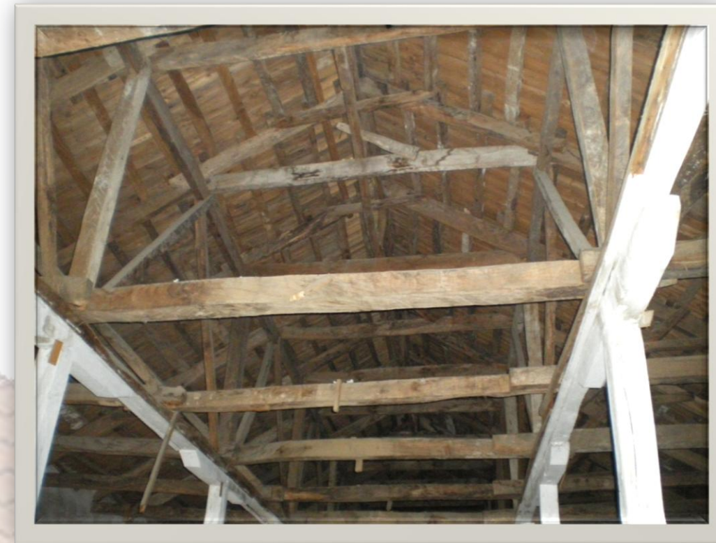
Εικ. 5.21: Κατασκευή στέγης
