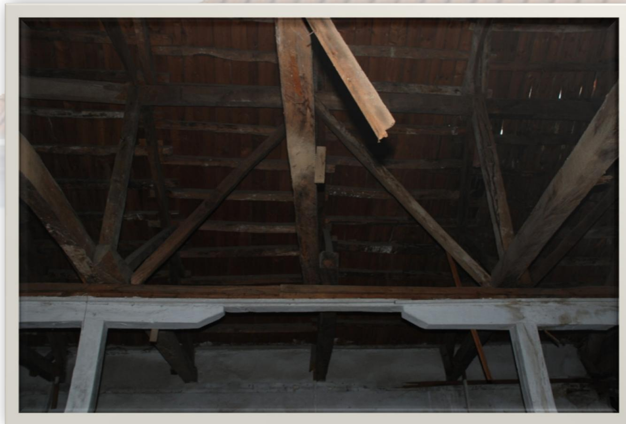
Εικ. 5.20: Κατασκευή στέγης
