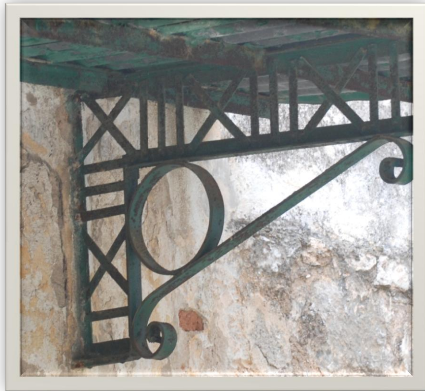
Εικ. 5.17: Λεπτομέρεια μεταλλικού στεγάστρου
