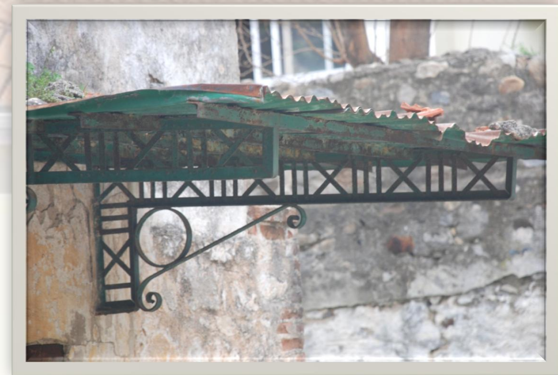
Εικ. 5.16: Μεταλλικό στέγαστρο στη δυτική όψη
