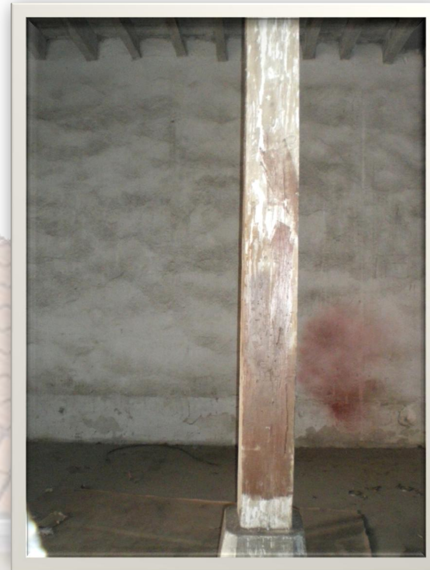
Εικ. 5.5: υποστυλώμα ισογείου
