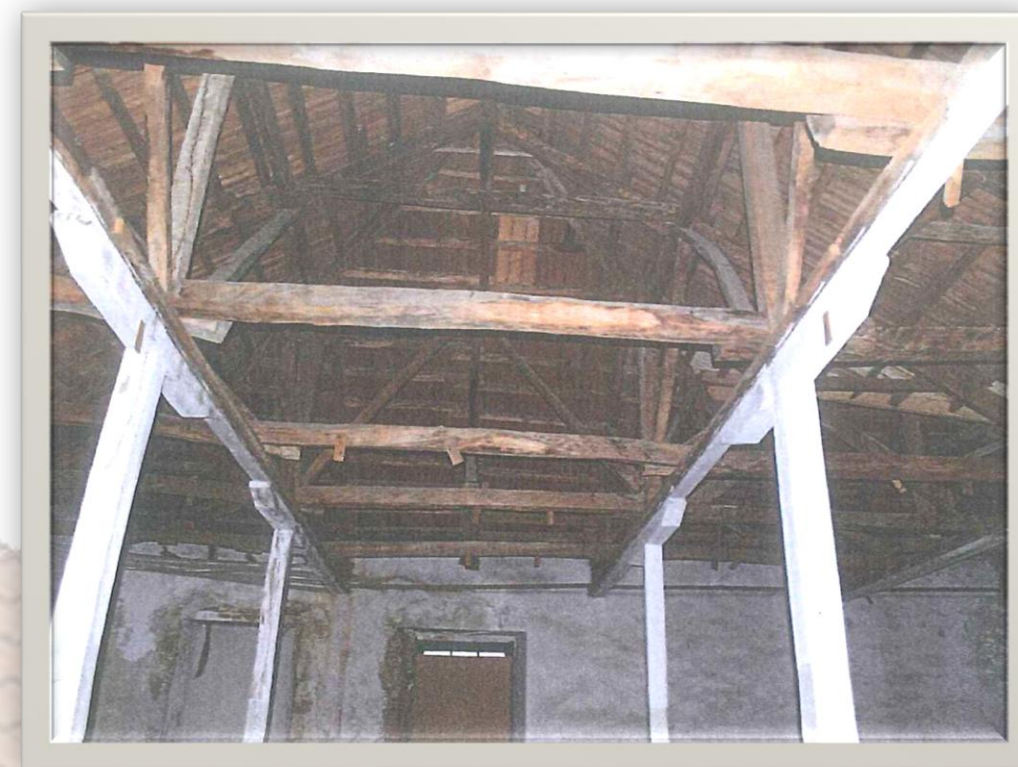
Εικ. 6.15: Εσωτερική άποψη της στέγης
