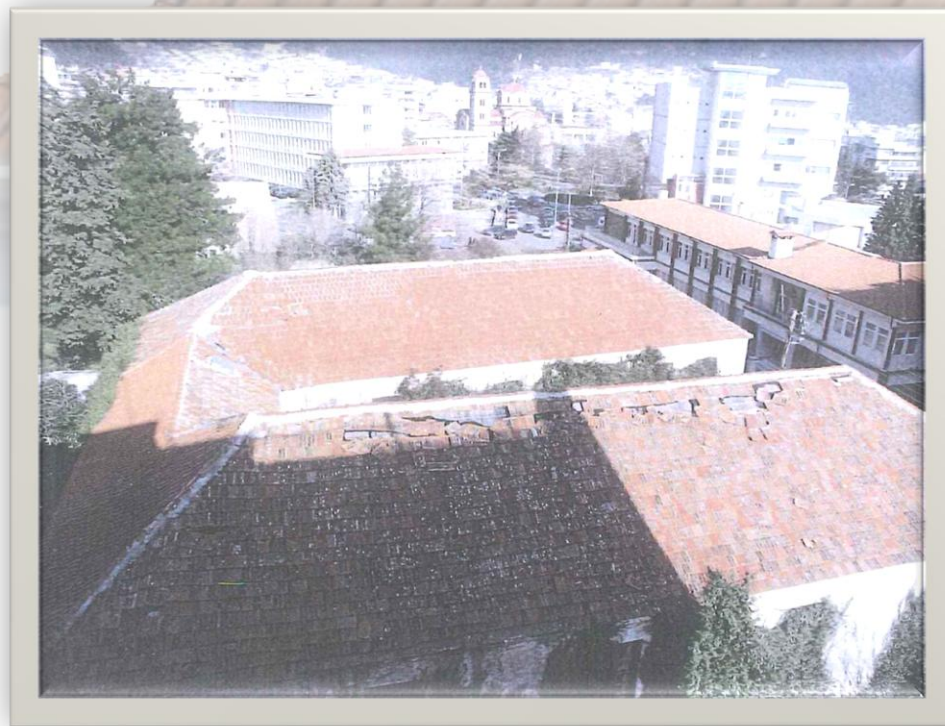
Εικ. 6.18: Η στέγη της καπναποθήκης από τα κτήρια στο νότιο τμήμα του οικοπέδου
