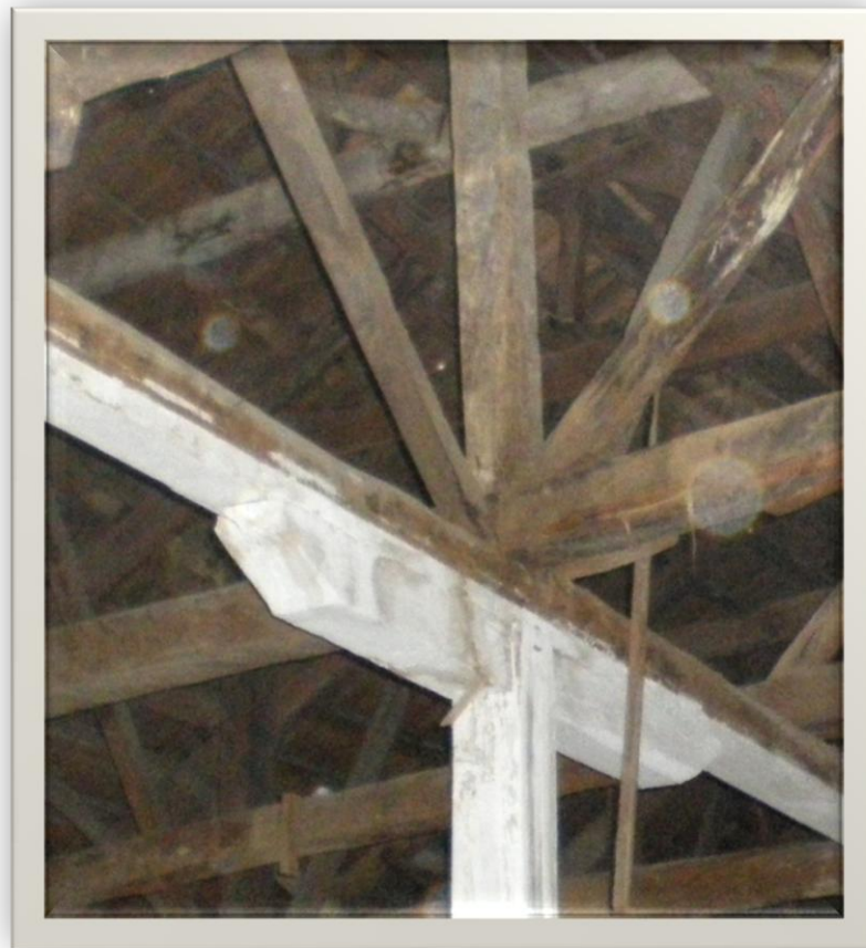
Εικ. 5.6: Έδραση υποστυλώματος ορόφου
