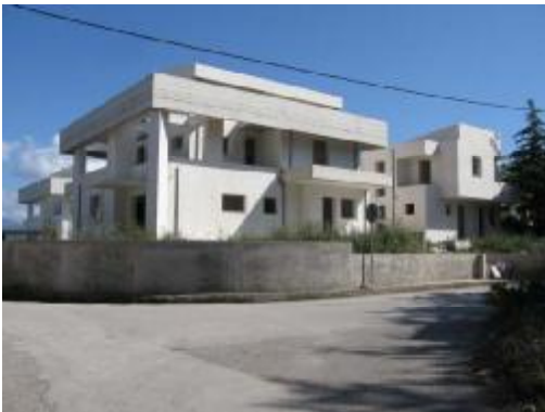
Κατοικία υπό ανέγερση.
