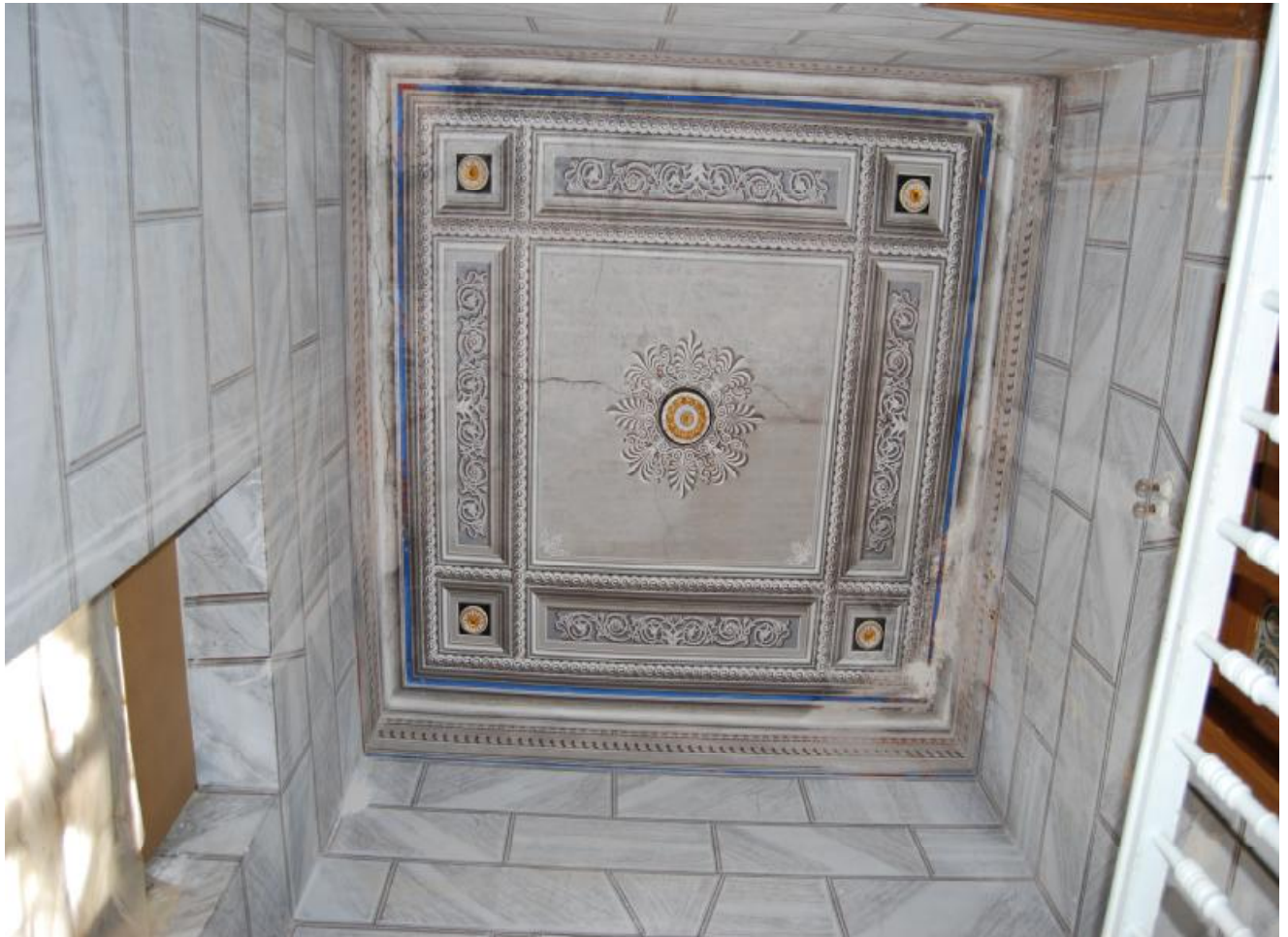
ΕΙΚΟΝΑ 30 : ΑΠΟΨΗ ΟΡΟΦΟΚΟΝΙΑΜΑΤΟΣ ΚΛΙΜΑΚΟΣΤΑΣΙΟΥ
