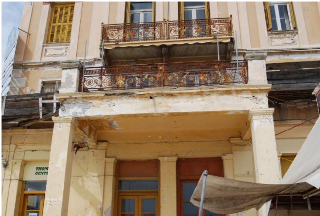
ΕΙΚΟΝΑ 17 :ΠΛΑΙΝΗ ΟΨΗ ΚΤΙΡΙΟΥ
