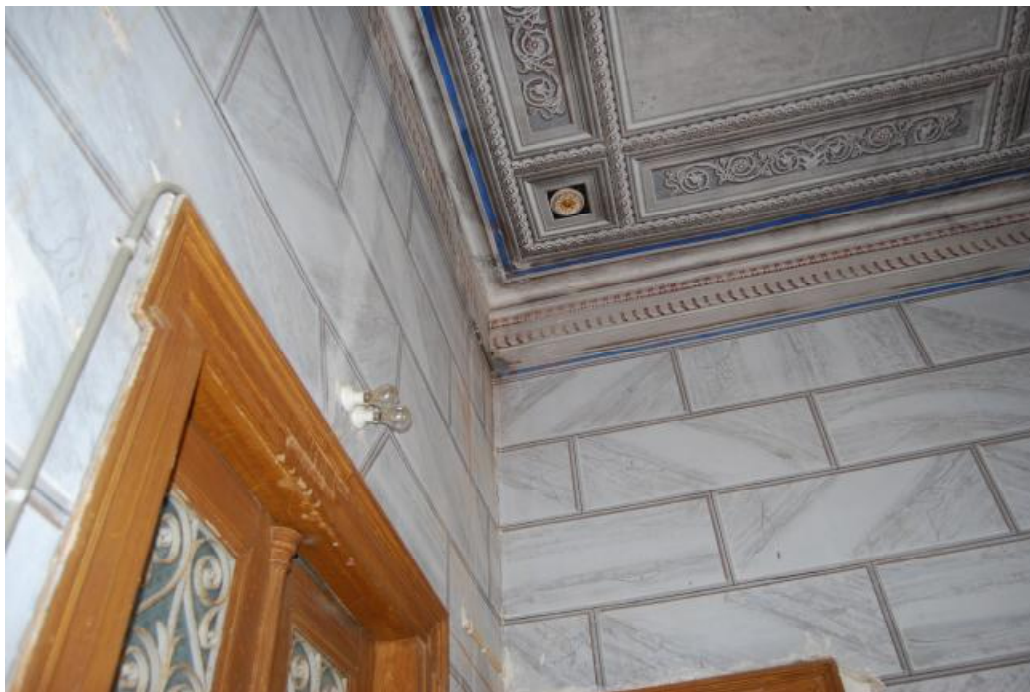
ΕΙΚΟΝΑ 33 : ΑΠΟΨΗ ΤΟΙΧΩΝ Κ ΟΡΟΦΗΣ ΚΛΙΜΑΚΟΣΤΑΣΙΟΥ
