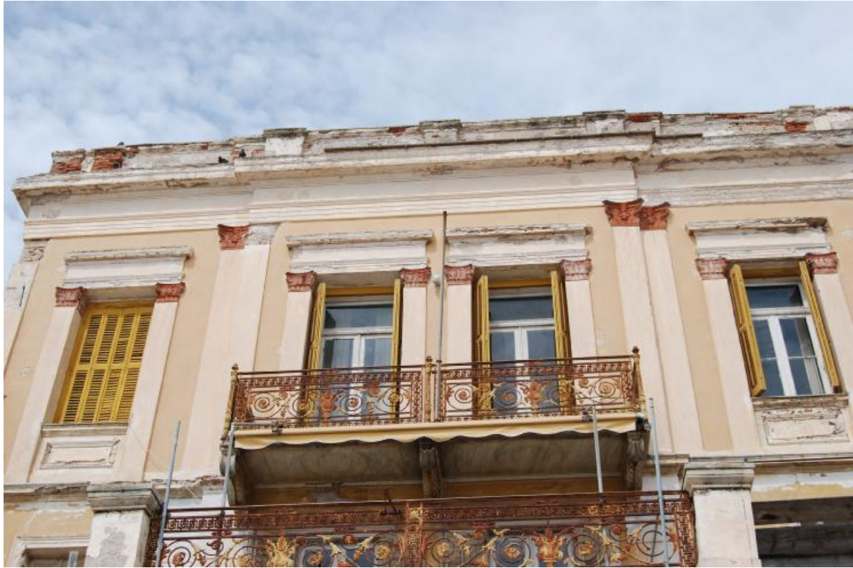
ΕΙΚΟΝΑ 18 : ΠΛΑΙΝΗ ΟΨΗ ΚΤΙΡΙΟΥ
