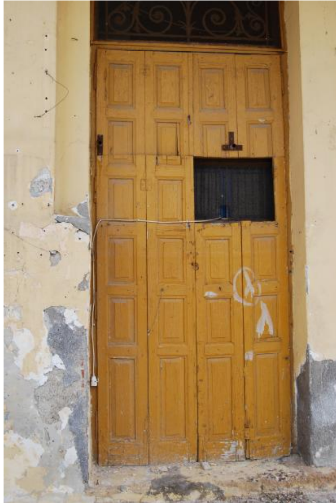
ΕΙΚΟΝΑ 46 : ΕΞΩΤΕΡΙΚΗ ΘΥΡΑ ΜΙΚΡΟΥ ΚΑΤΑΣΤΗΜΑΤΟΣ
