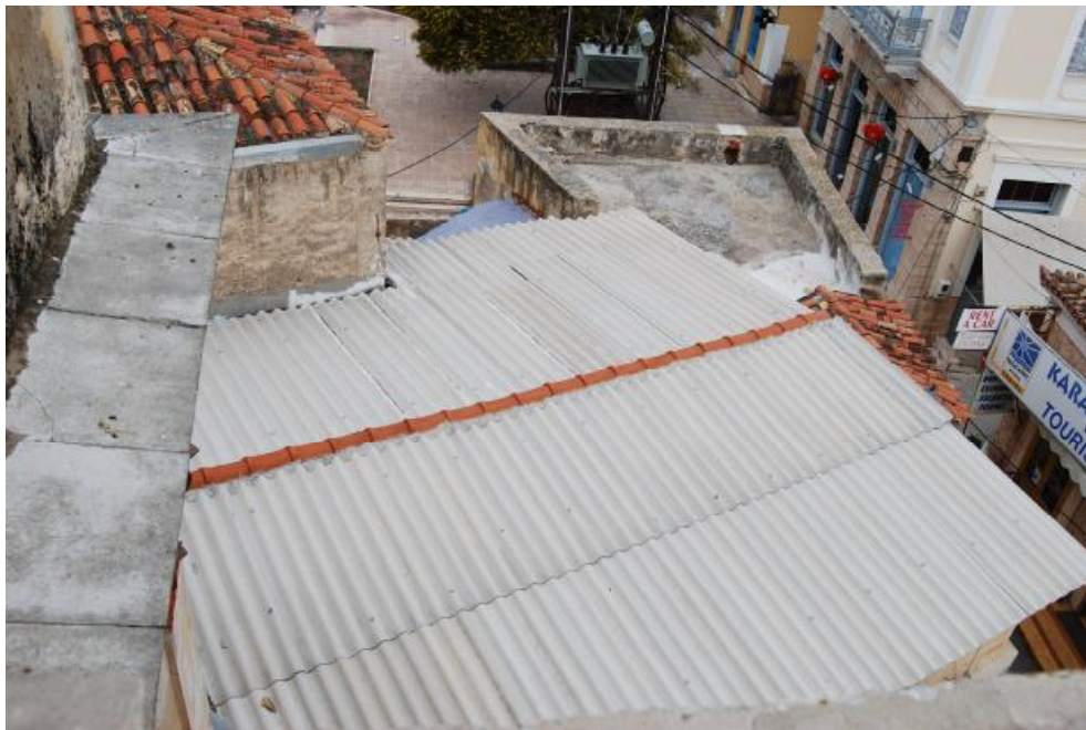
ΕΙΚΟΝΑ 27 : ΑΠΟΨΗ ΣΤΕΓΗΣ ΚΤΙΡΙΟΥ
