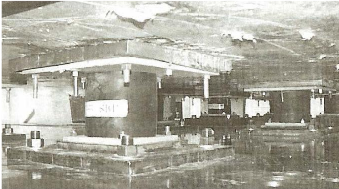
Εικόνα 4.3. Ελαστομεταλλικό εφέδρανο
