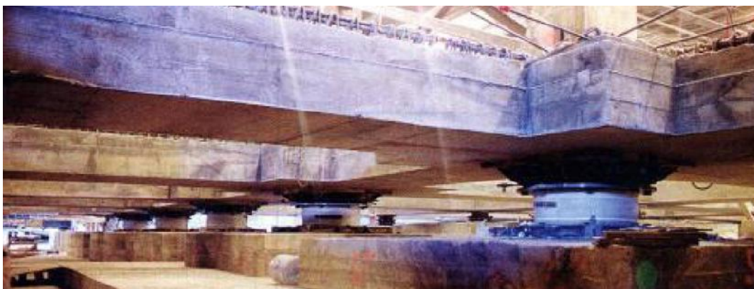
Εικόνα 6.25. Το νέο διάφραγμα υπό κατασκευή
