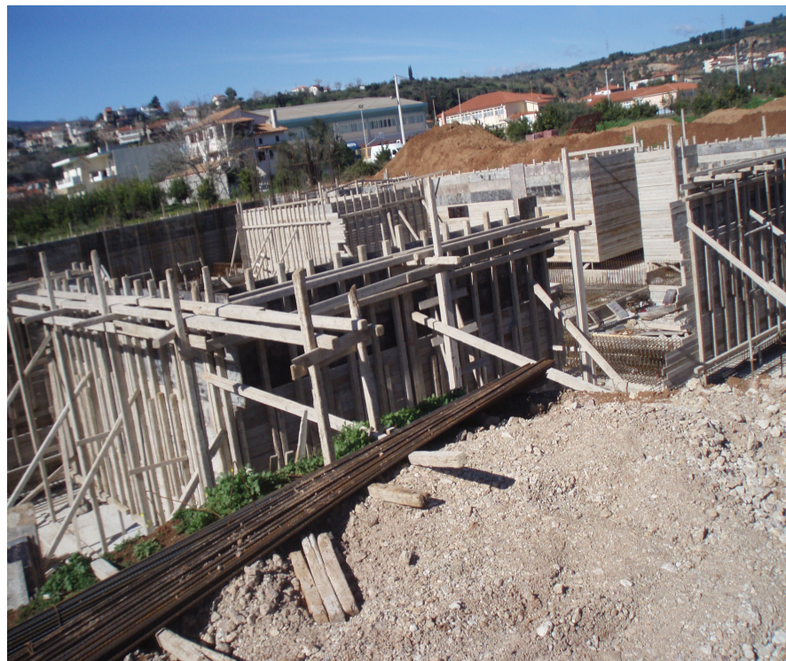
Εικόνα 37: Θεμέλια κατασκευής Νέου Δημαρχείου Αιγείρας
