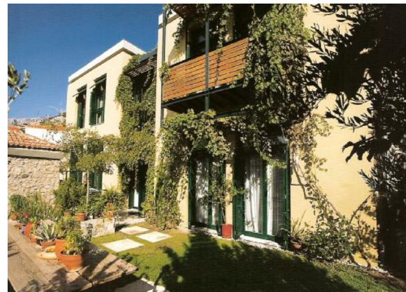
Εικόνα 28: Νοτιανατολική όψη του κτιρίου από το εσωτερικό.
