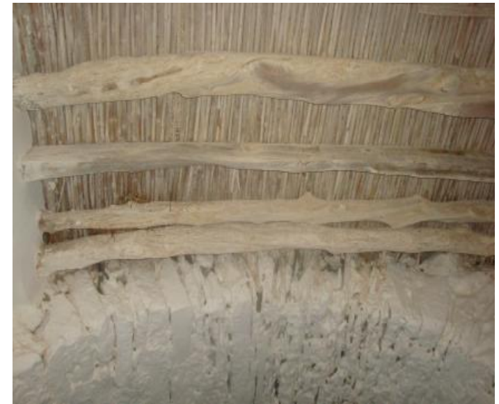
Εικόνα 18: Λεπτομέρεια στο κάτω μέρος του πατώματος.
