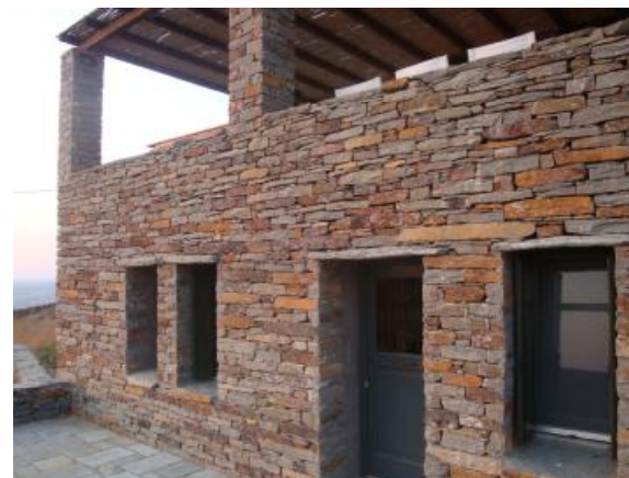
Εικόνα 25: Κατοικία στην Κέα κατασκευής 2005 (όψη).
