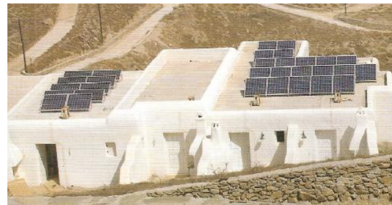
Εικόνα 54: Φωτοβολταϊκά στοιχεία πάνω σε δώμα κυκλαδίτικου σπιτιού.
