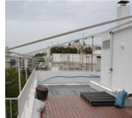
Εικόνα 47: Δώμα κατοικίας στην Αθήνα πριν την μετατροπή του.
