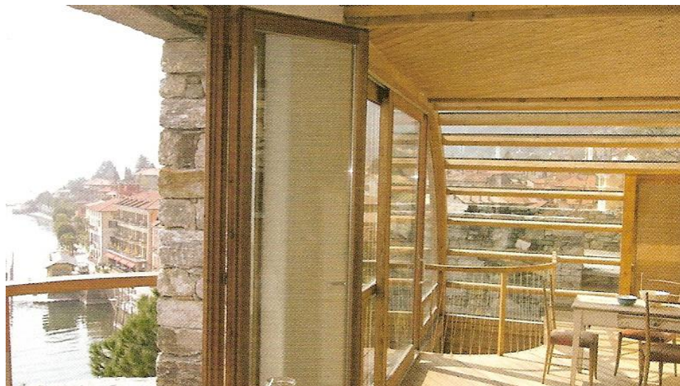
Εικόνα 53: Άποψη από το εσωτερικό στην γυάλινη κατασκευή.
