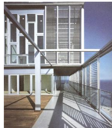
Εικόνα 42: Σταθερές εξωτερικές περσίδες σε κτίριο στην Βαρκελώνη της Ισπανίας
