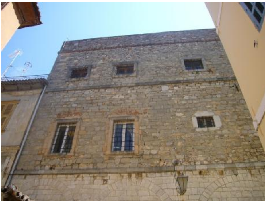
Εικόνα 79: Φωτογραφία της πλαϊνής όψης του κτιρίου. Από προσωπικό αρχείο.
