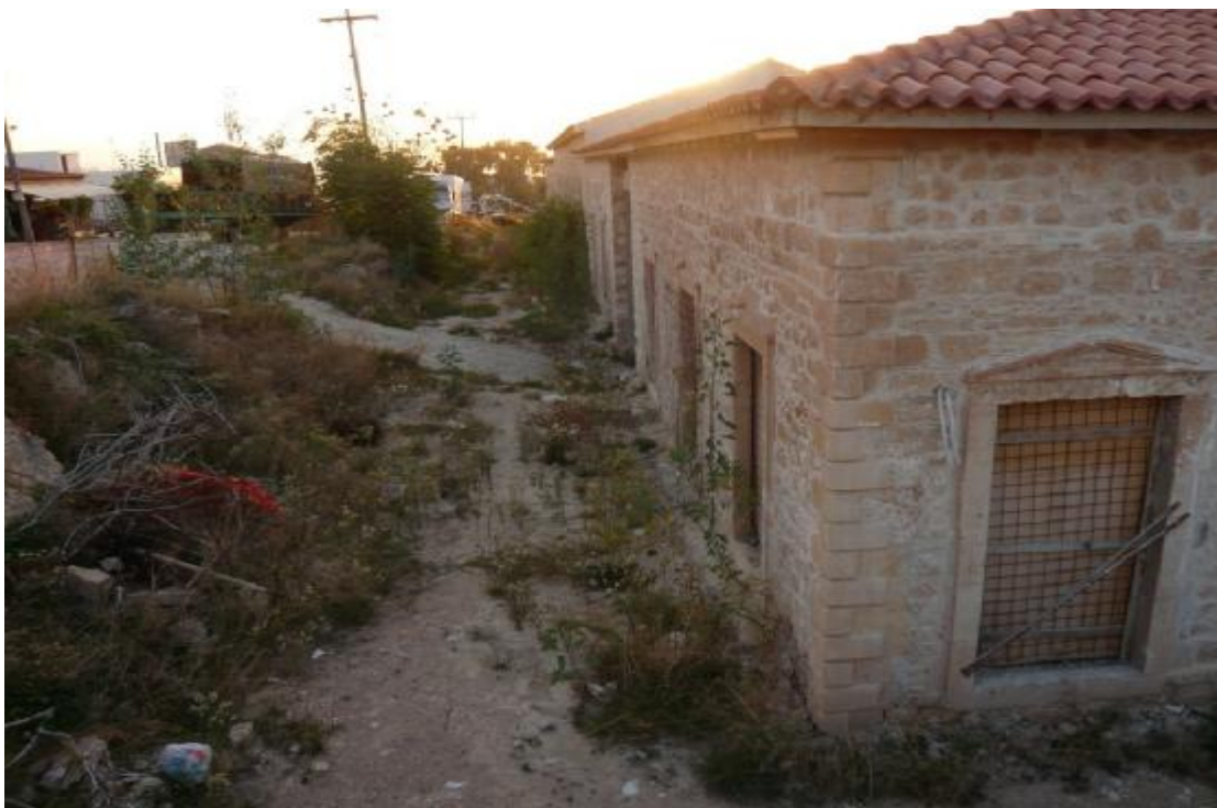
Εικόνα 40: Άποψη από την Νοτιοανατολική όψη του ορφανοτροφείου. Από προσωπικό αρχείο
