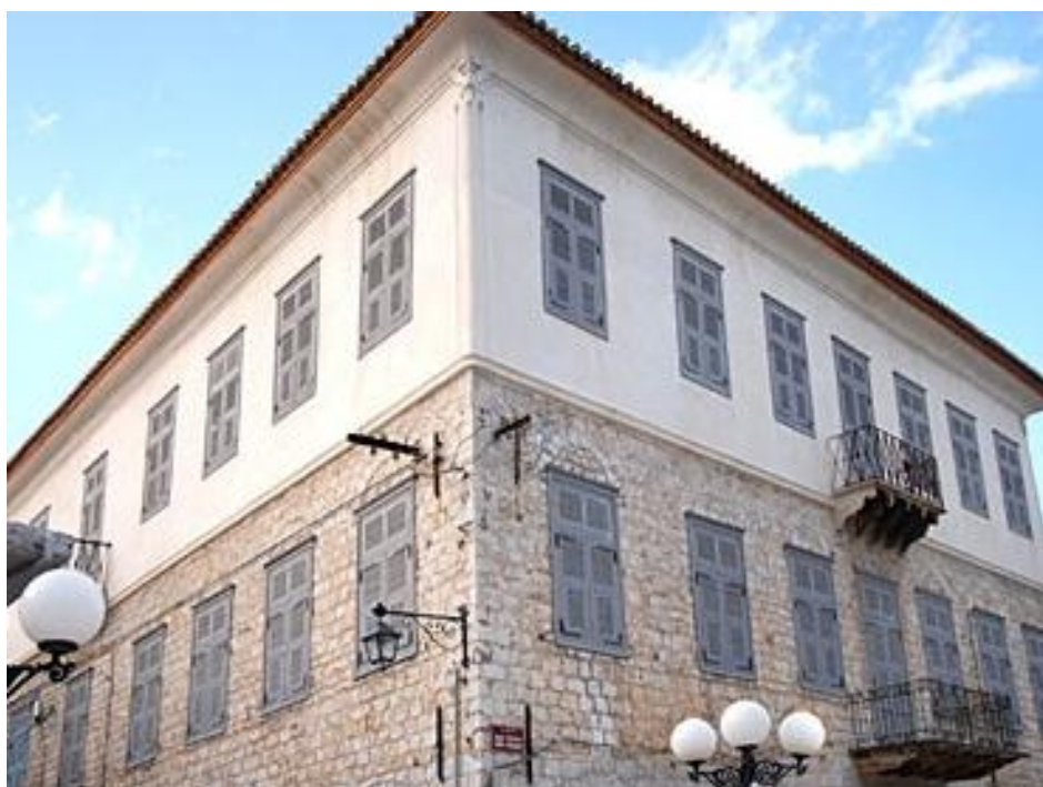
Εικόνα 92: Δύο από τις τρεις πλευρές του κτιρίου, σημερινή κατάσταση. Από προσωπικό αρχείο.
