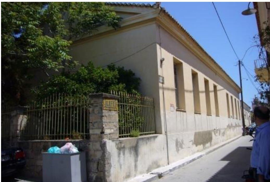
Εικόνα 43: Πίσω όψη κτηρίου. Από προσωπικό αρχείο.
