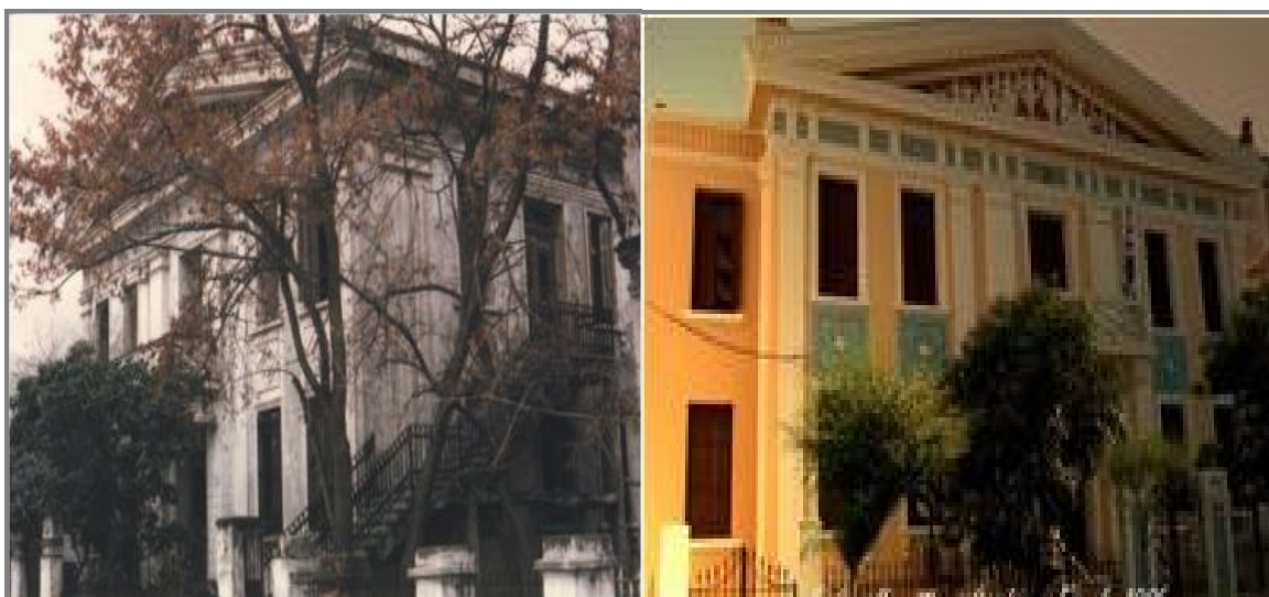
Εικόνα 32: Νεοκλασικό στην οδό Βενιζέλου πριν και μετά την επανάχρηση του ως Δημοτικό Ωδείο της πόλης. Από τα πιο σημαντικά κτίρια της Καβάλας με δύο μεγάλα αετώματα, διαζώματα ψευδοπαρασταστάδες, πλαίσια παραθύρων, πρόθυλο και μαρμάρινη σκάλα.
