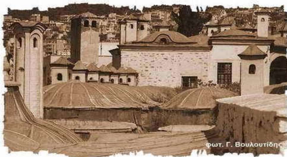
Εικόνα 41: Η άτακτη δομή των θόλων και καμινάδων του Ιμαρέτ της Καβάλας, που όμως του αποδίδουν μια ξεχωριστή μορφή στον χώρο.
