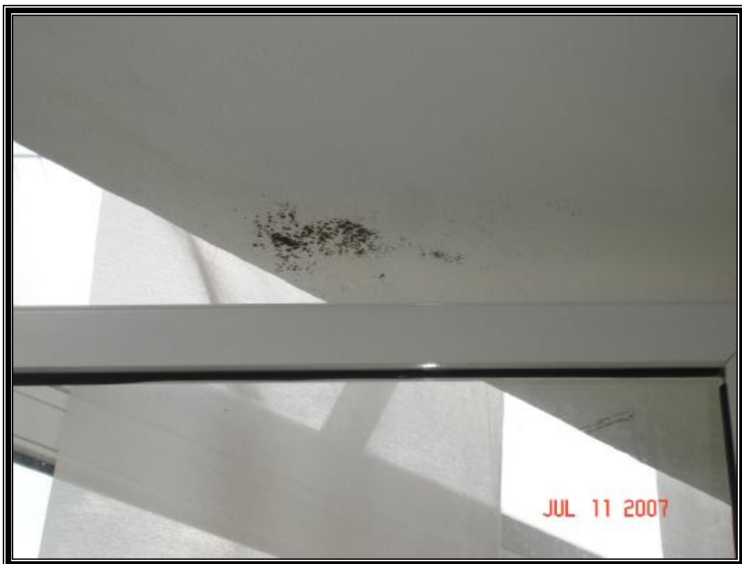
ΕΙΚΟΝΑ 29. Εμφάνιση υγρασίας.
