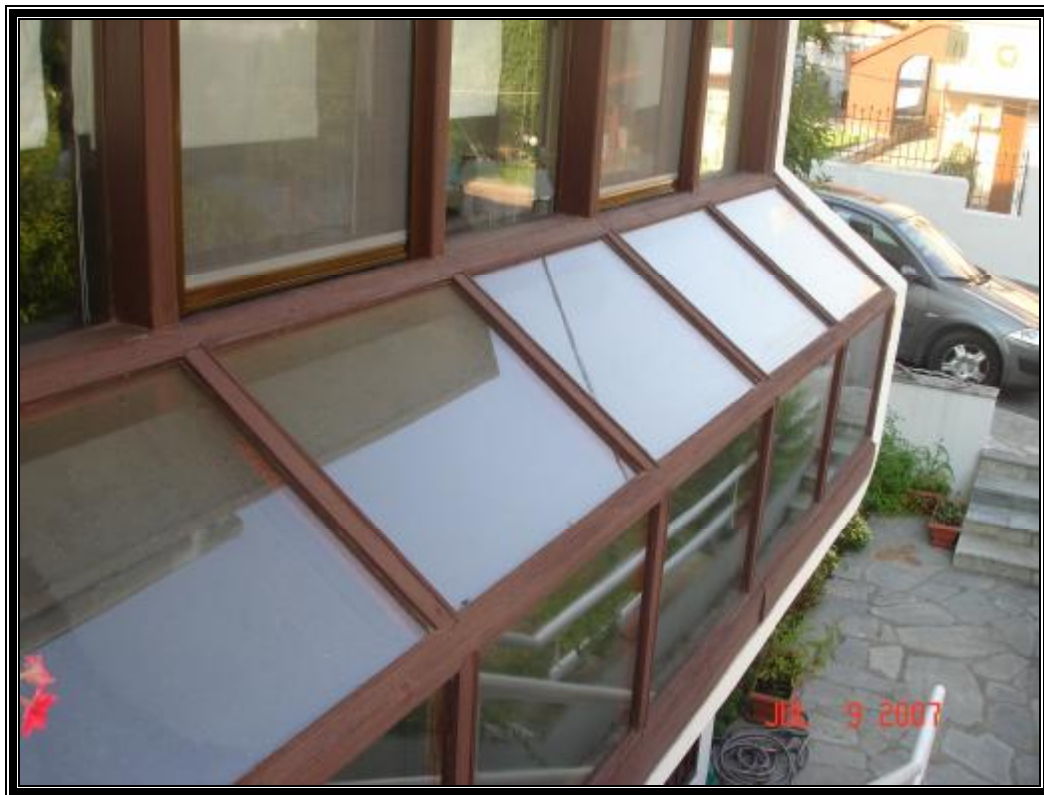
ΕΙΚΟΝΑ 30. Μεταλλικά δοχεία νερού καλυπτόμενα με μονό τζάμι στη νότια όψη της κατοικίας.
