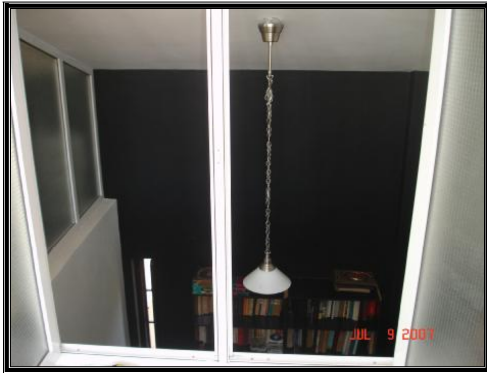
ΕΙΚΟΝΑ 25. Τμήμα τοίχου βαμμένο μαύρο με σκοπό να απορροφά την ηλιακή ακτινοβολία.
