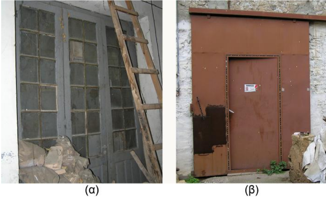
Εικ. 60: α) Η τρίφυλλη ταμπλαδωτή πόρτα της ανατολικής εισόδου, β) η μεταλλική πόρτα της δυτικής εισόδου
