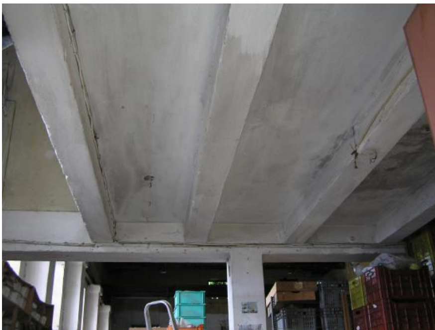
Εικ. 59: Άνοψη των δοκών στήριξης του παταριού
