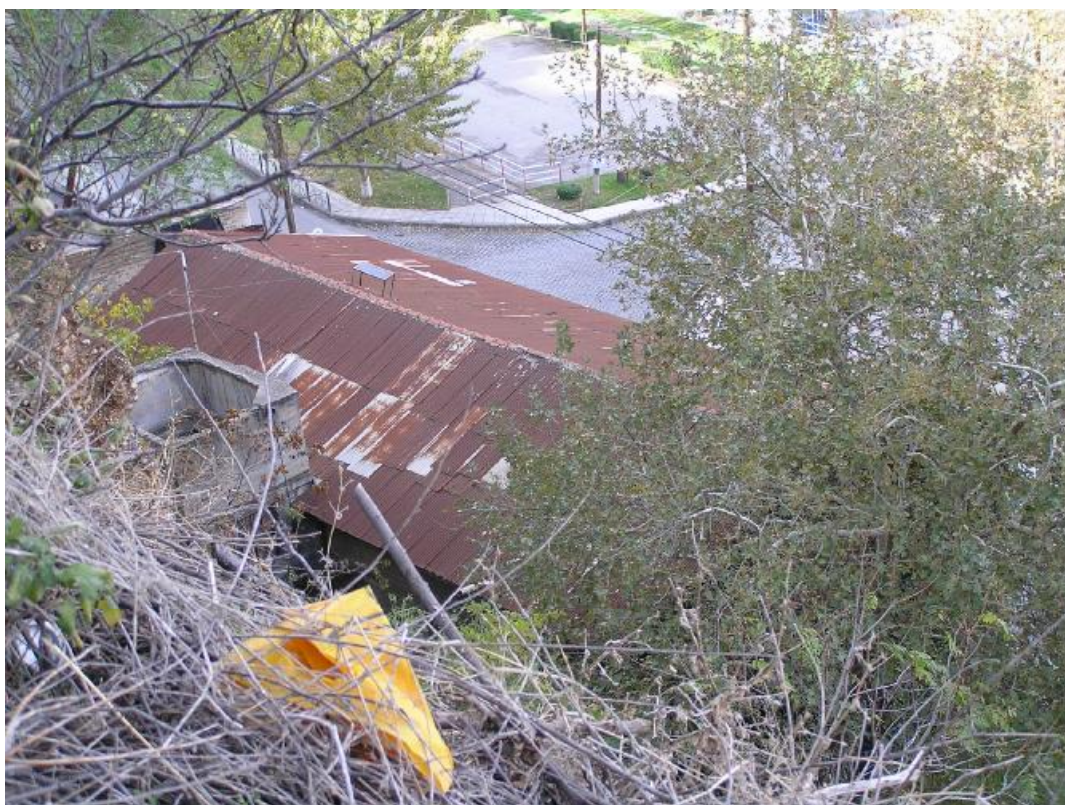
Εικ. 65: Άποψη της στέγης του κτιρίου. Στα αριστερά διακρίνεται το άνοιγμα στο ανώτερο τμήμα της πυργοειδούς κατασκευής.
