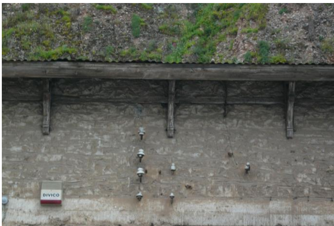
Εικ. 56: Η ξυλοδεσιά όπως φαίνεται στο εξωτερικό της βόρειου τοίχου
