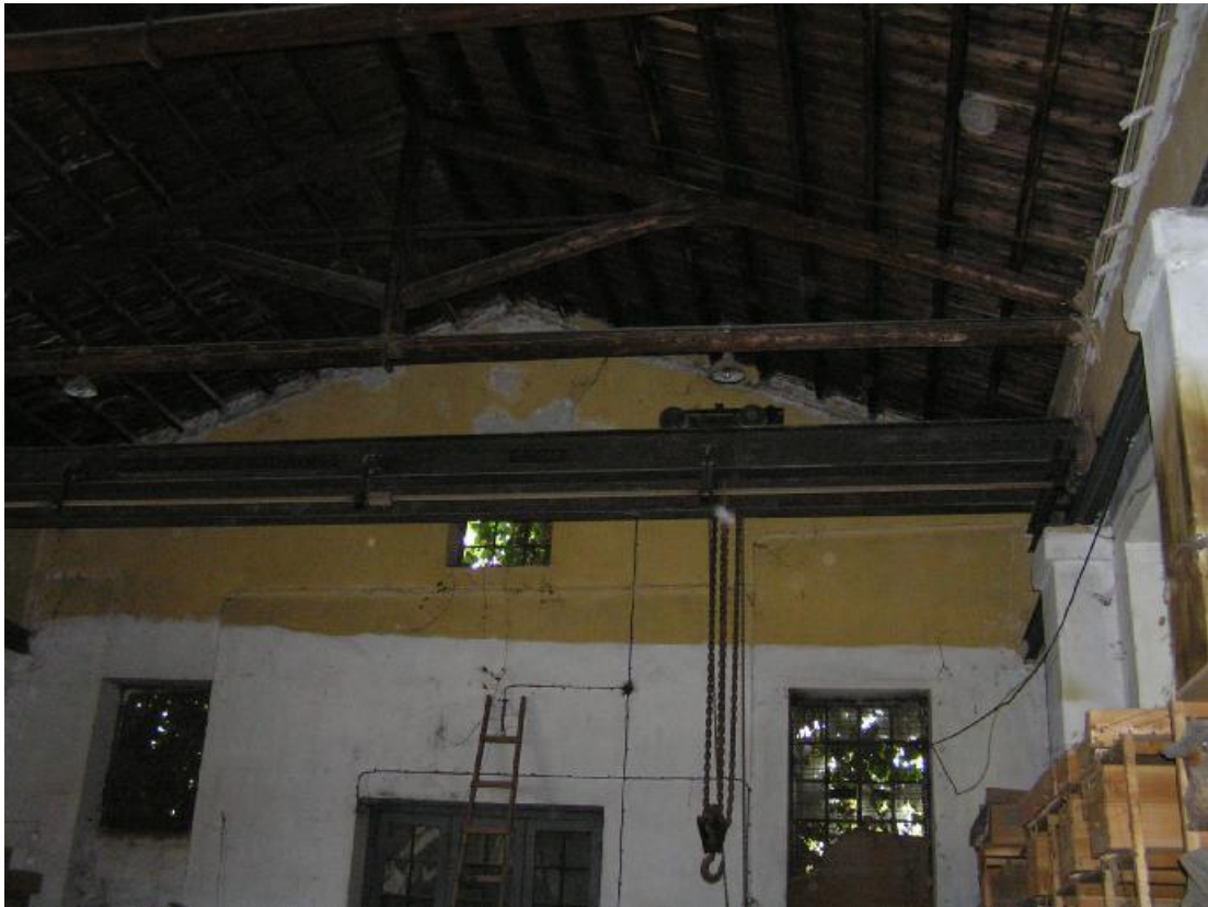
Εικ. 57: Οι ράγες και ο μηχανισμός ανύψωσης που στηρίζονται στους ημιπεσσούς
