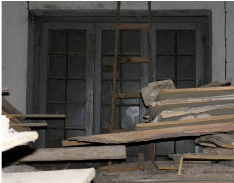
Εικ. 73: α) φθορές στα ξύλινα κουφώματα, β) θραύση κρυστάλλων
