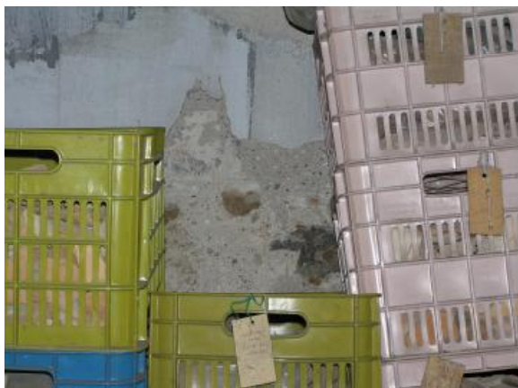
Εικ. 68: Ενδεικτικές βλάβες λιθοδομής: α) πτώση επιχρίσματος, β) υγρασία
