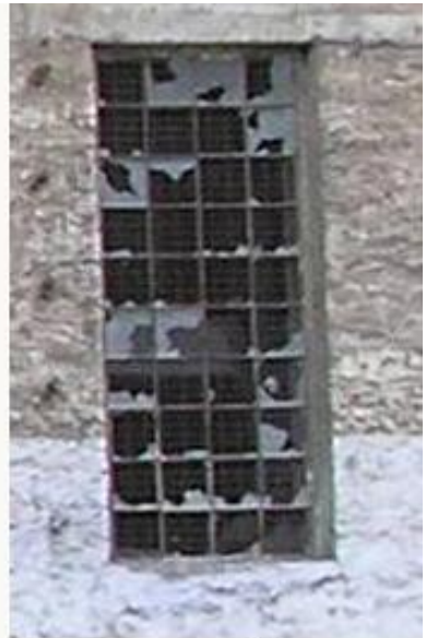
Εικ. 72: α) σκουριά στα μεταλλικά κουφώματα, β) θραύση κρυστάλλων
