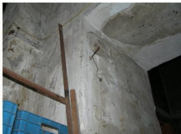
Εικ. 68: Ενδεικτικές βλάβες λιθοδομής: α) πτώση επιχρίσματος, β) υγρασία
