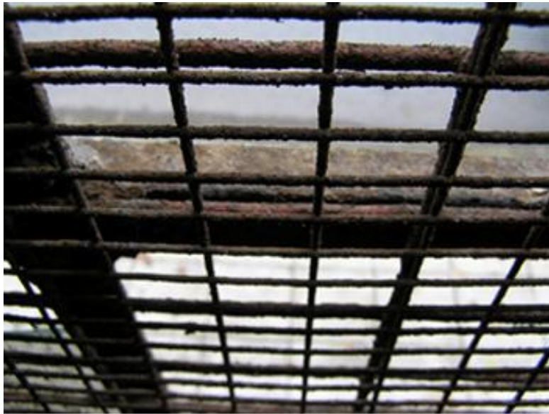
Εικ. 72: α) σκουριά στα μεταλλικά κουφώματα, β) θραύση κρυστάλλων
