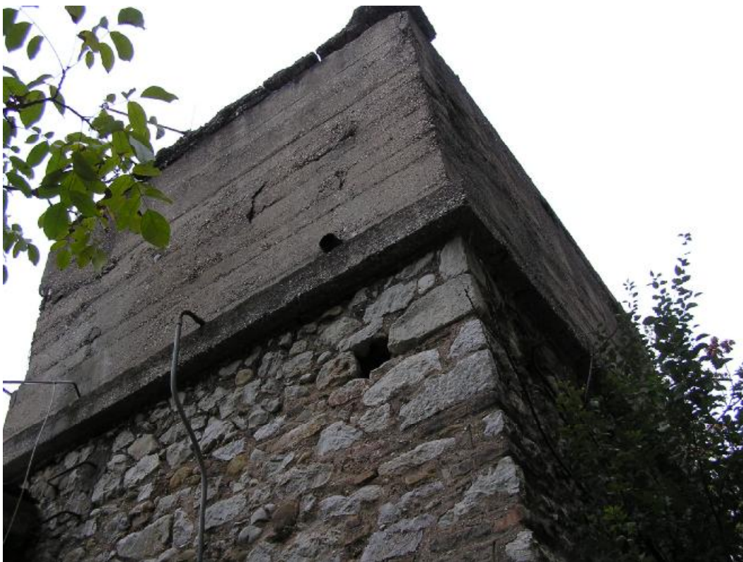
Εικ. 64: Άποψη της πυργοειδούς κατασκευής
