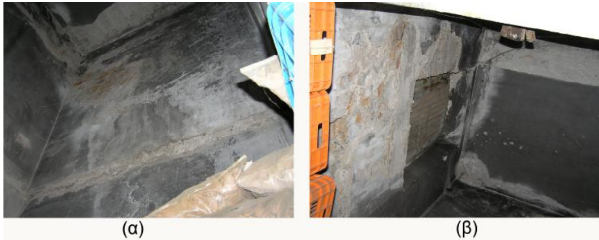
Εικ. 71: α) Υγρασία την τοιχοποιία της πυργοειδούς κατασκευής, β) το ανώτερο κούφωμα έχει αντικατασταθεί με φύλλο λαμαρίνας
