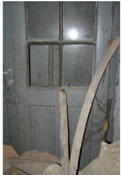
Εικ. 73: α) φθορές στα ξύλινα κουφώματα, β) θραύση κρυστάλλων
