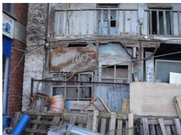
Εικ.17: Μεταγενέστερη προσθήκη στο ισόγειο.
