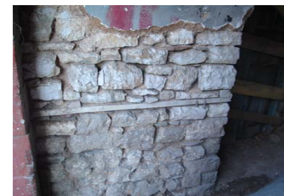
Εικ.28: Οι ξυλοδεσιές βρίσκονται σε καλή κατάσταση.
