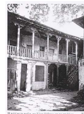
Εικ.14: Κατάσταση του κτιρίου κατά την 4 η φάση.
