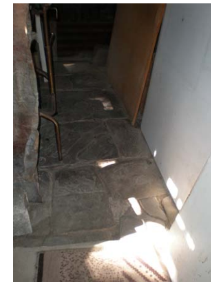
Εικ.20: Πλακόστρωση στον ημιυπαίθριο χώρο του ισογείου.
