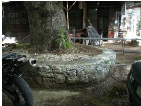
Εικ.3: Διαμόρφωση πεζουλιών γύρω από τον κορμό των πλατάνων στον περιβάλλοντα χώρο.
