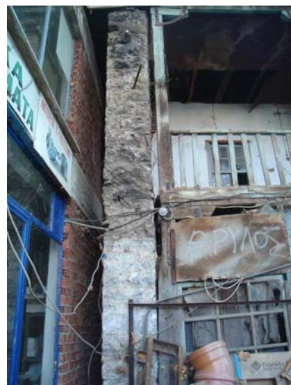
Εικ.26: Ο νότιος φέρων τοίχος της δυτικής πτέρυγας.
