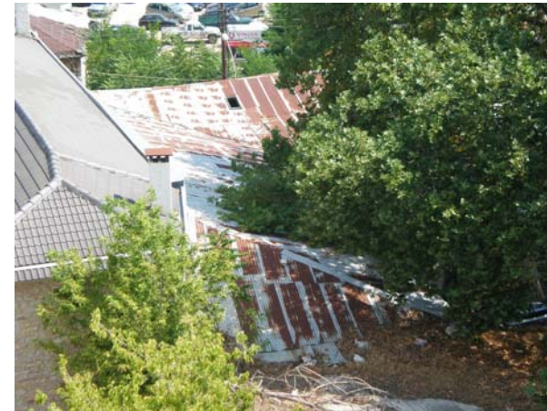
Εικ.53: Άποψη της στέγης από κτίριο όμορου οικοπέδου.
