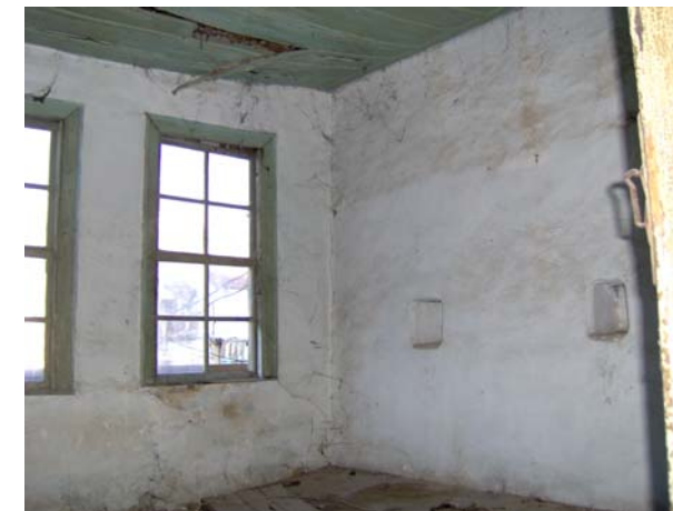
Εικ.22: Ερμάρια στο χώρο Α3 του ορόφου.
