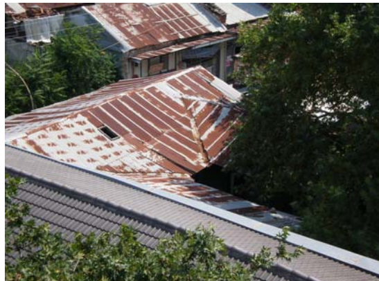
Εικ.17: Άποψη της στέγης από διπλανό κτίριο.
