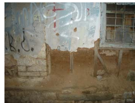
Εικ.29: Αποσάθρωση κονιάματος δομής και αρμολογήματος. Εικ.30: Απουσία υαλοπινάκων στα παράθυρα του ορόφου.
