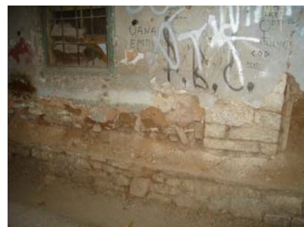
Εικ.25: Τοπική αποδιοργάνωση λιθοδομής.
