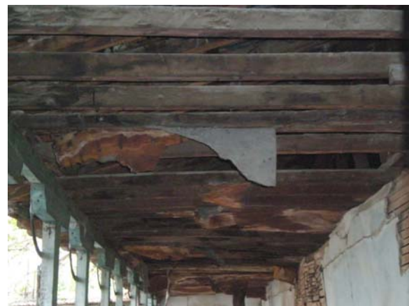
Εικ.59: Στήριξη ζευκτών δυτικής πτέρυγας στον τσατμά και στα ξύλινα υποστυλώματα.
