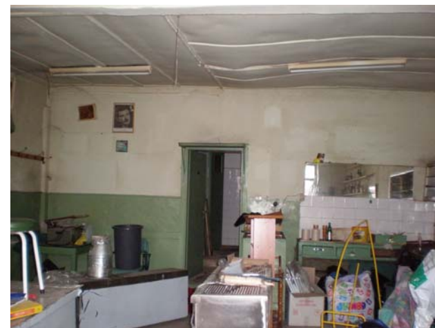
Εικ.33: Εσωτερική άποψη του καταστήματος 15.
