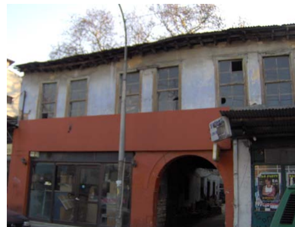
Εικ.19: Η κύρια (βόρεια) όψη του κτιρίου.
