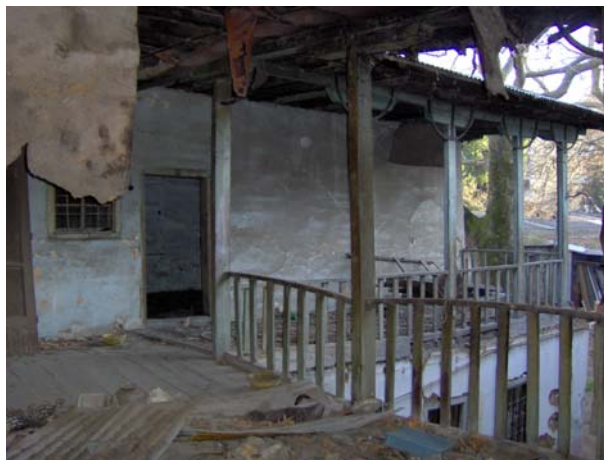
Εικ.49: Άποψη της κρεββάτας από βορειοδυτικό τμήμα του ορόφου.
