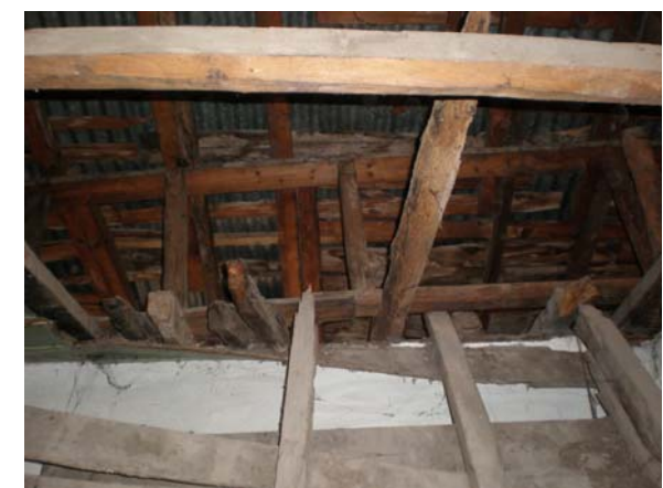
Εικ.58: Στήριξη στέγης στον τσατμαδότοιχο.
