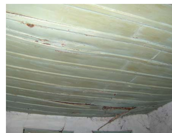
Εικ.45: Η οροφή στο χώρο Α5.
