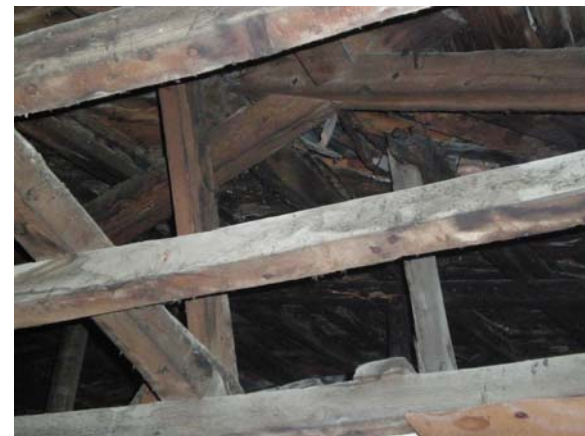
Εικ.62: Σύνδεση βόρειου και δυτικού τμήματος της στέγης.
