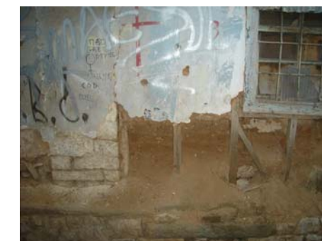
Εικ.15: Τμήμα αργολιθοδομής με ενίσχυση ξύλινων στοιχείων.
