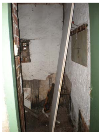
Εικ.39: Βοηθητικός χώρος Ι8 καταστήματος Ι5.
