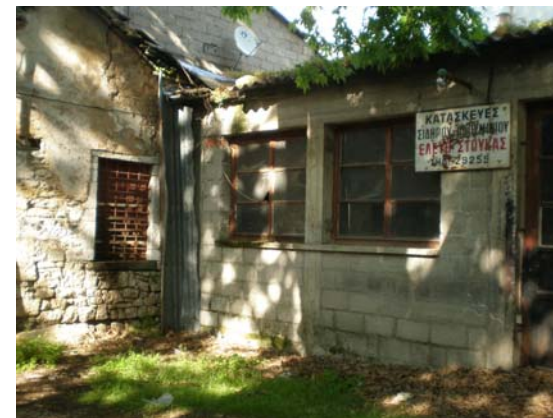
Εικ.6: Κτίσματα βοηθητικής χρήσης στην αυλή.
