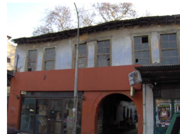
Εικ.10:Σειρά από παράθυρα στην κύρια όψη του κτιρίου.
