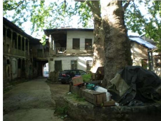
Εικ.2: Άποψη του κτιρίου από την αυλή.
