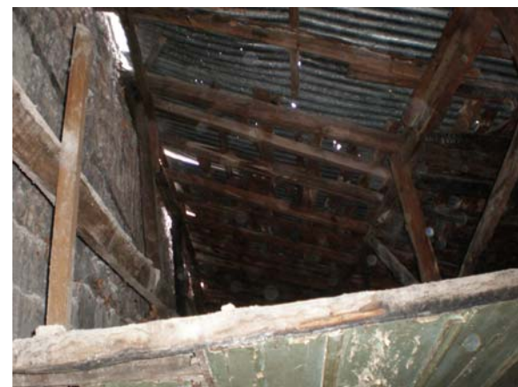
Εικ.64: Στήριξη στέγης δυτικού τμήματος στον λίθινο τοίχο.
