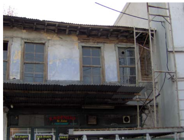
Εικ.32: Αποκόλληση κατά περιοχές του χρωματισμού.
