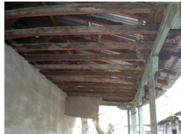
Εικ.60: Στήριξη ζευκτών ανατολικής πτέρυγας στον τσατμά και στα ξύλινα υποστυλώματα.
