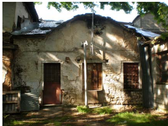
Εικ.5: Νότια όψη του διπλανού κτίσματος.
