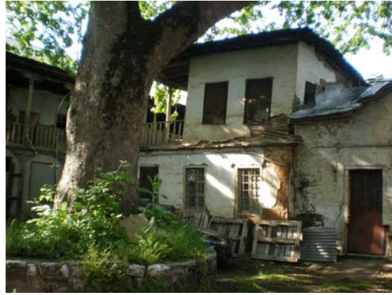
Εικ.1: Άποψη της ανατολικής πτέρυγας από την αυλή.
