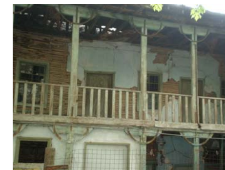
Εικ.29: Αποσάθρωση κονιάματος δομής και αρμολογήματος. Εικ.30: Απουσία υαλοπινάκων στα παράθυρα του ορόφου.
