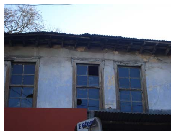
Εικ.11: Ξύλινα φουρούσια της στέγης.
