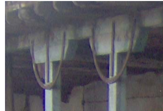
Εικ.12: Μεταλλικά ενισχυτικά στοιχεία υποστυλωμάτων.
