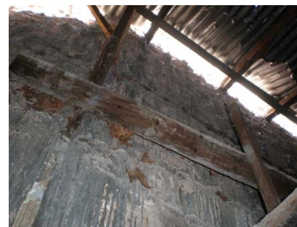
Εικ.57: Στήριξη στέγης δυτικής πτέρυγας στο λίθινο τοίχο.
