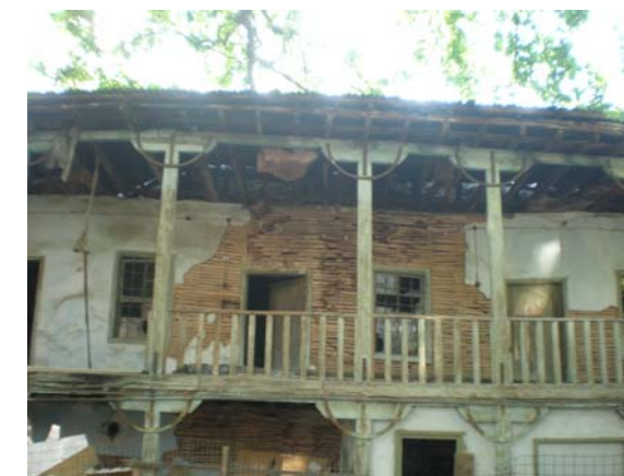
Εικ.32: Υπάρχουσα κατάσταση του ορόφου.
