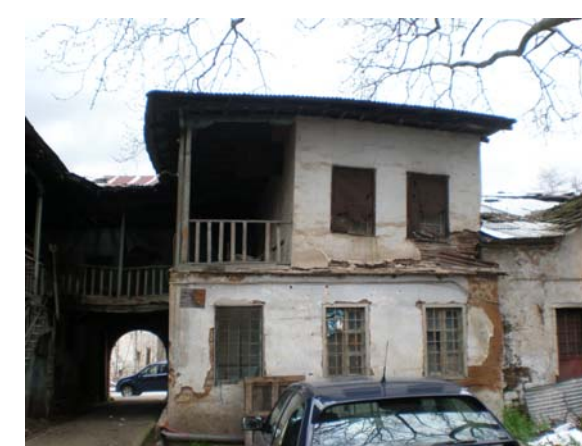
Εικ.24: Νότια άποψη της ανατολικής πτέρυγας.
