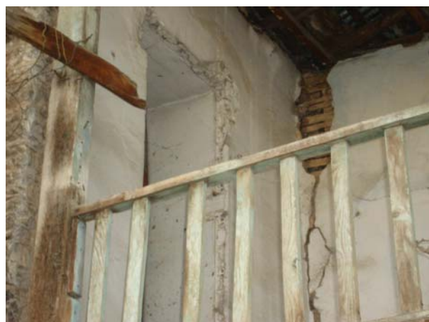
Εικ.27: Μεταγενέστερο άνοιγμα στο νότιο τοίχο της δυτικής πτέρυγας του ορόφου.
