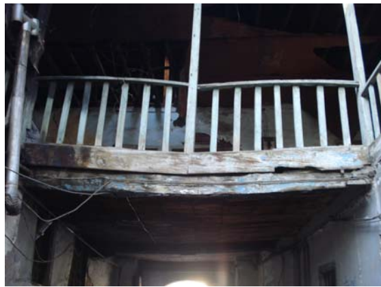
Εικ.20: Τύπος ξύλινων κιγκλιδωμάτων.
