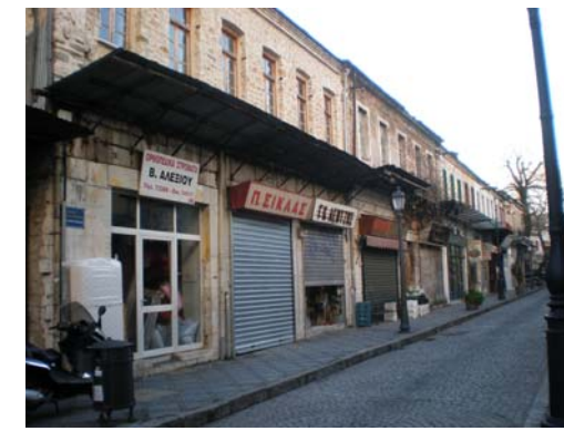
Εικ.4: Χάνι επί της οδού Ανεξαρτησίας.
