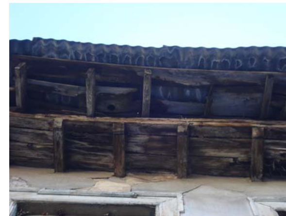
Εικ.55: Διαμόρφωση φουρουνισιού στην κύρια όψη.
