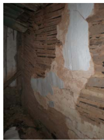
Εικ.26: Αποσάθρωση επιχρίσματος.
