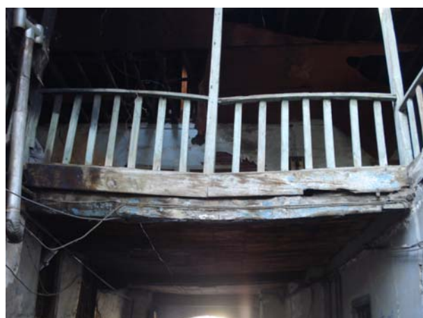
Εικ.29: Τμήμα της κρεββάτας που «γεφυρώνει» τις δυο πτέρυγες.
