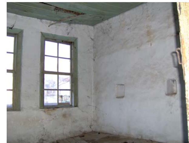
Εικ.42: Άποψη του χώρου Α3.
