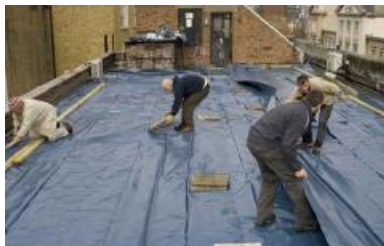
Τοποθέτηση αδιάβροχης μεμβράνης
