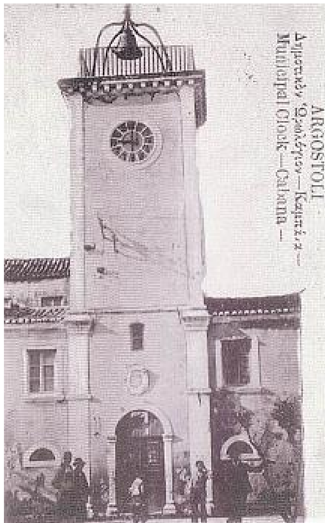
Εικόνα 17: Το καμπαναριό της πλατείας καμπάνας
