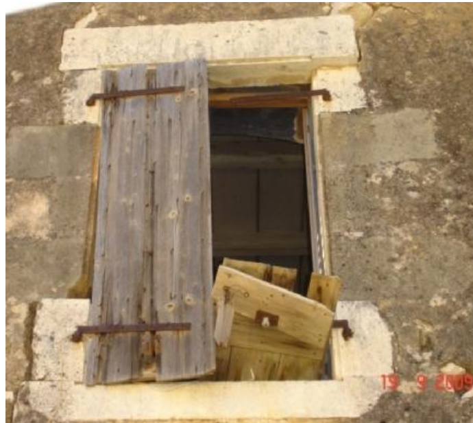
Εικόνα 52: Τύπος καρφωτού παντζουριού καρφωμένου με φούμπιες στη λιθοδομή προσωπικό αρχείο
