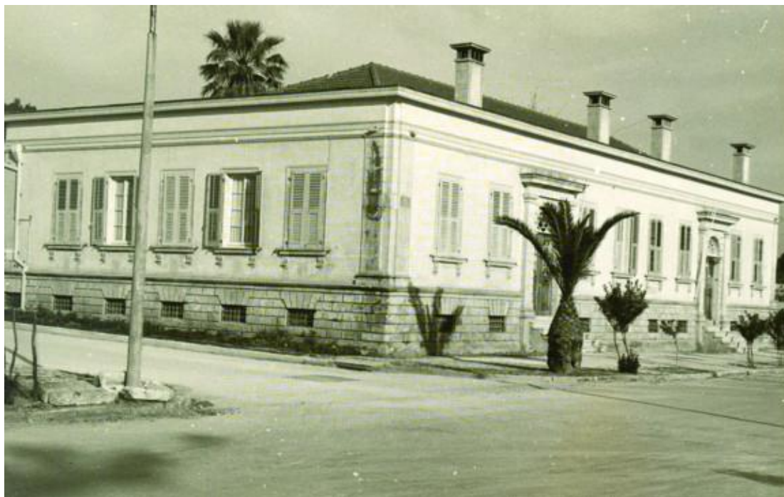
Εικόνα 120: Το κτήριο πριν την ανακαίνιση του
