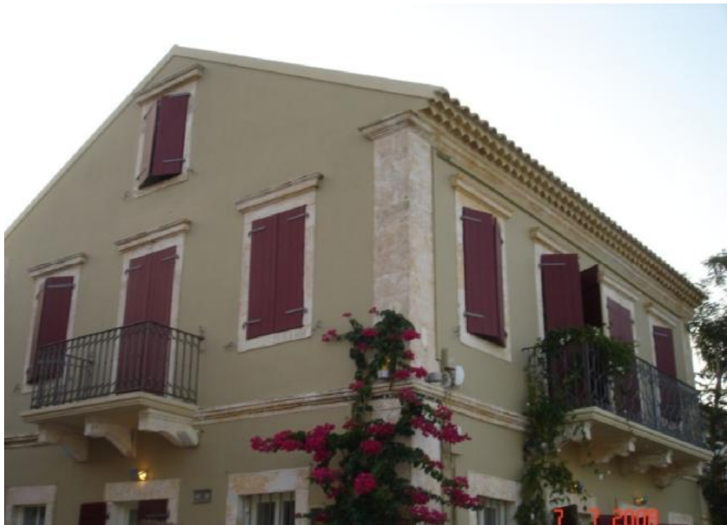
Εικόνα 72:ανακαινισμένη οικία στο Φισκάρδο παρατηρούμε και το ατσούπι και το γείσο για την προστασία της λιθοδομής
