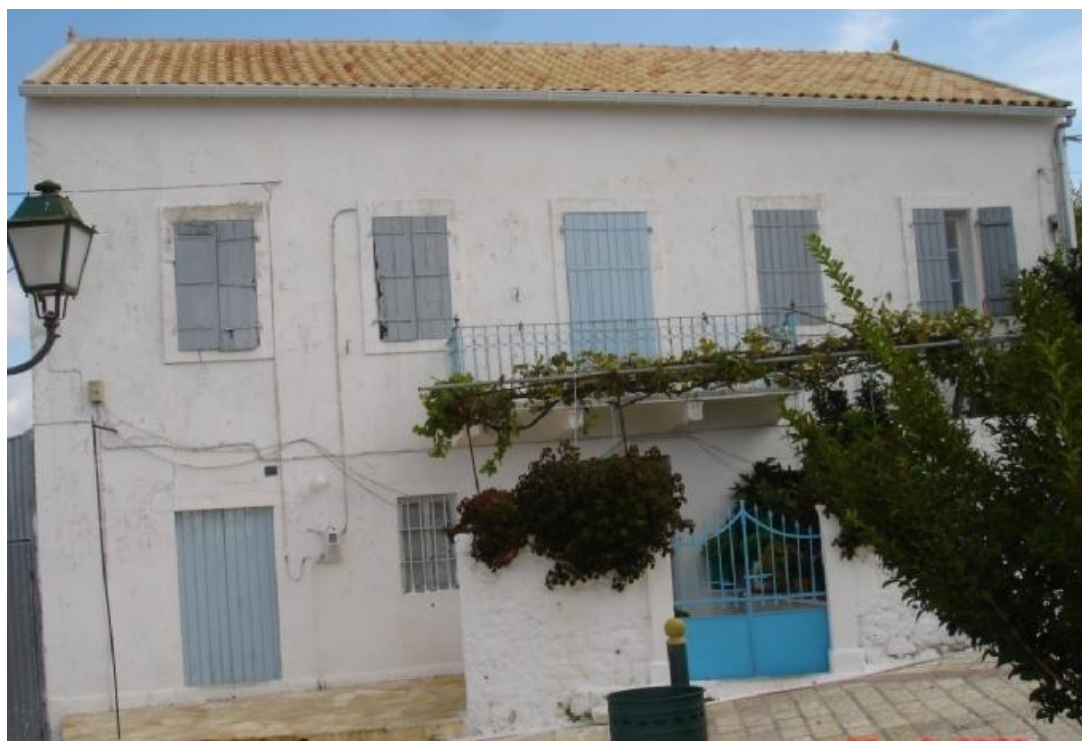
Εικόνα 61: Οικία στα Μεσοβούνια (παρατηρούμε το απλό ορθογωνικό πλαίσιο περιμετρικά των ανοιγμάτων) προσωπικό αρχείο
