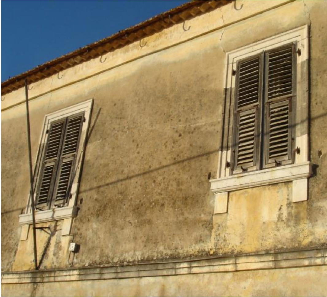
Εικόνα 59: Οικία στην Αγία Ευφημία (παρατηρούμε και τον καθ' ύψος τονισμό αλλά και το διαχωριστικό των ορόφων που γίνεται με λαξευτή λιθοδομή πηγή: προσωπικό αρχείο)
