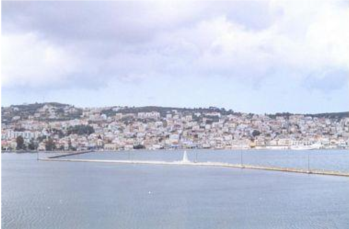
Εικόνα 23: :Η Γέφυρα στην σημερινή της κατάσταση ( http://www.kefalonitis.com/plugins/p2_news/printarticle.php?p2_articleid=377 26/08/09)
