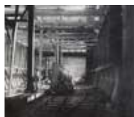
Εργασίες κατασκευής της σήραγγας Θησείο- Ομόνοια
