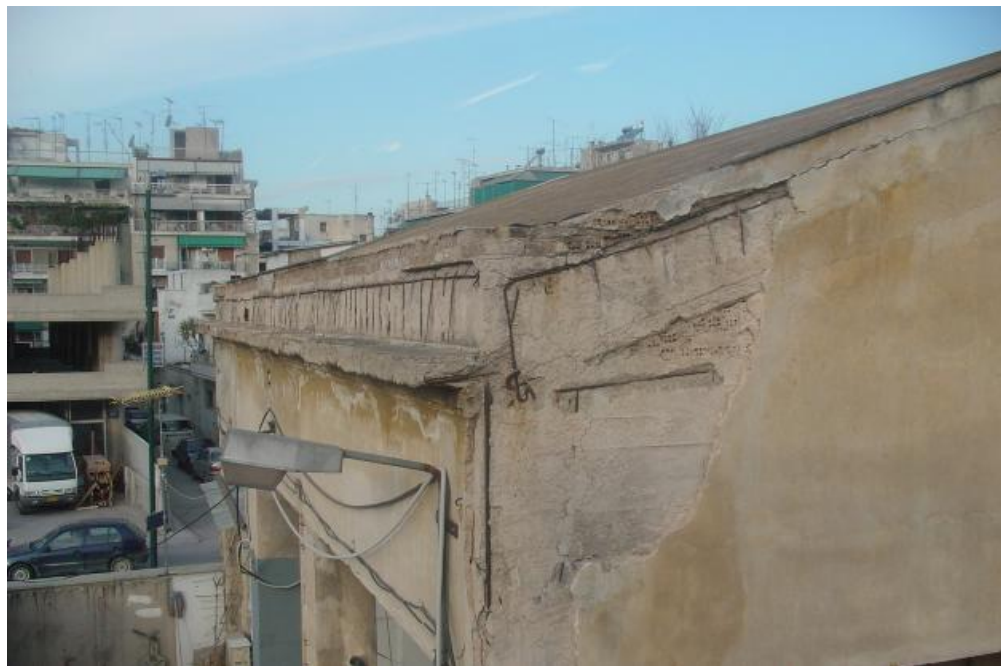
ΦΤ.09 Νοτιοανατολική (NA) όψη στέγης.
