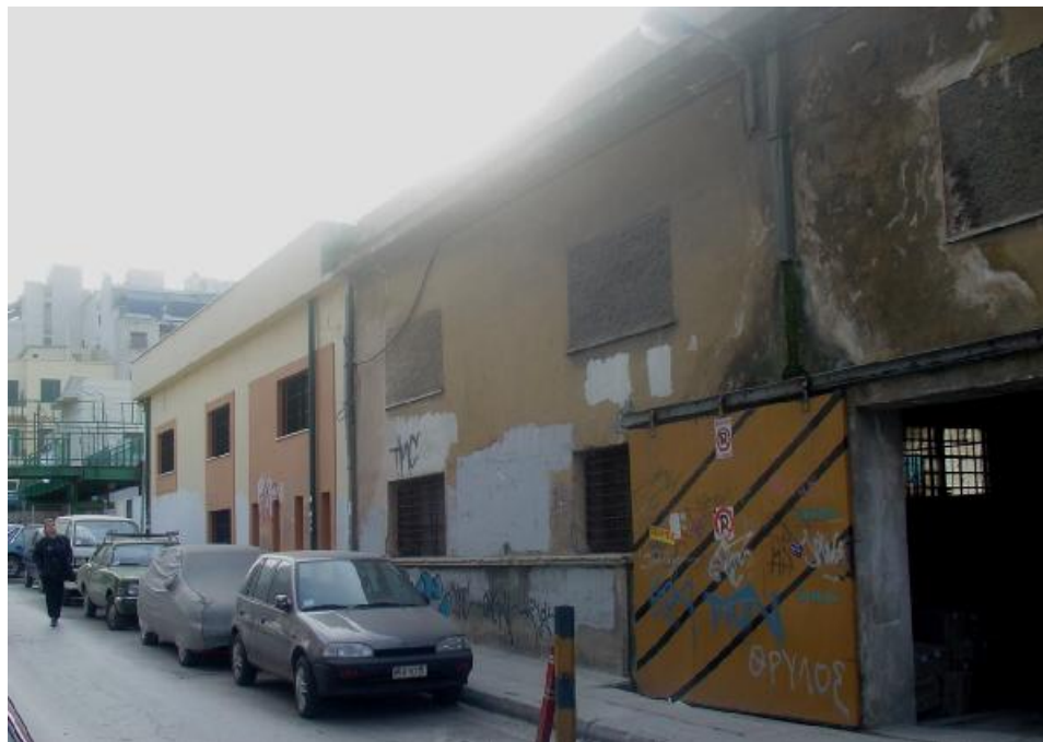
ΦΤ.05 Άποψη Βόρειας όψης συνεργείου και αποθήκης.
