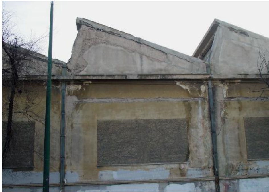
ΦΤ.01 Δυτική όψη (Δ) αμαξοστασίου.
