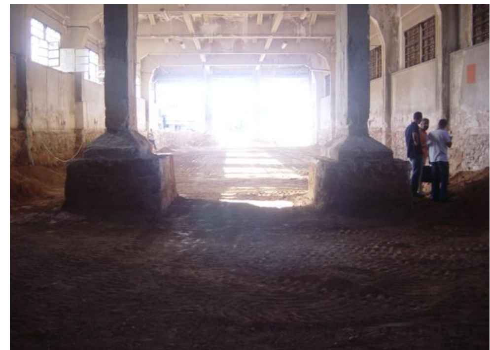
ΦΤ.18 Κοντινή λήψη πεδιλοδοκών θεμελίωσης.
