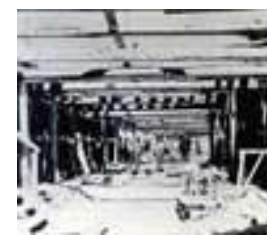
Εργασίες κατασκευής σήραγγας Θησείο- Ομόνοια
