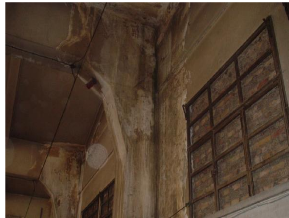
ΦΤ.14 Φθορές στις ενώσεις των δοκών με τα υποστυλώματα.
