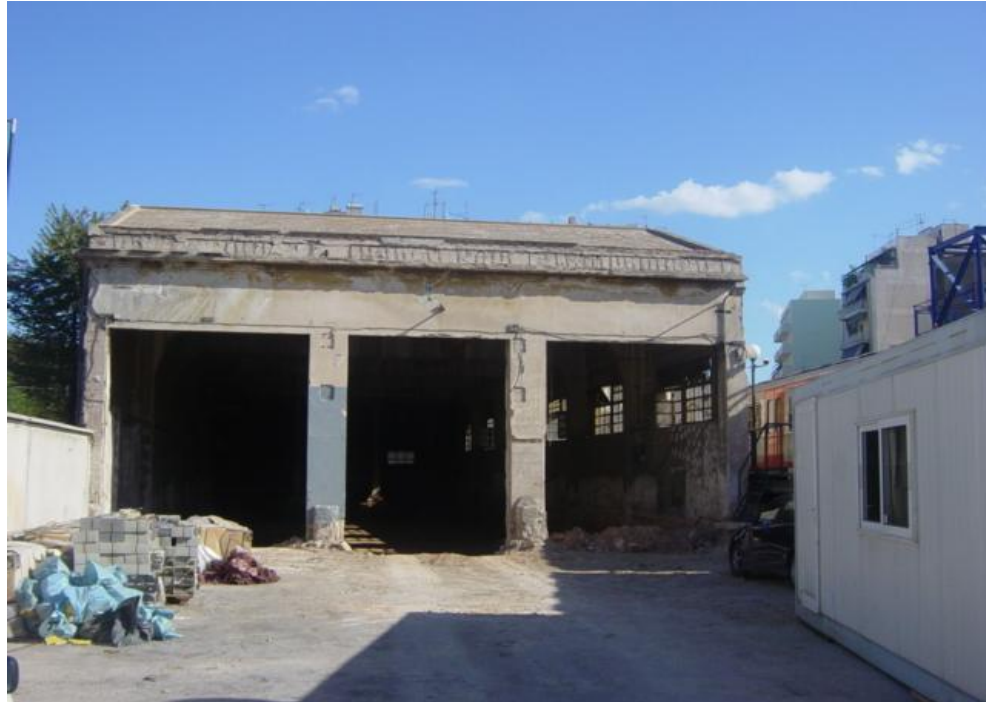
ΦΤ.07 Νότια (N) όψη αμαξοστασίου.
