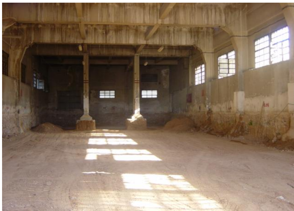
ΦΤ.13 Φάση εκσκαφής, στο επίπεδο των θεμελίων του αμαξοστασίου και του συνεργείου
