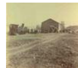
Εργοτάξιο κατασκευής του ΣΑΠ κοντά στ
