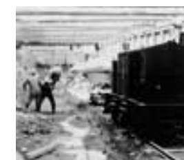
Εργασίες κατασκευής σήραγγας Ομόνοια-Αττική
