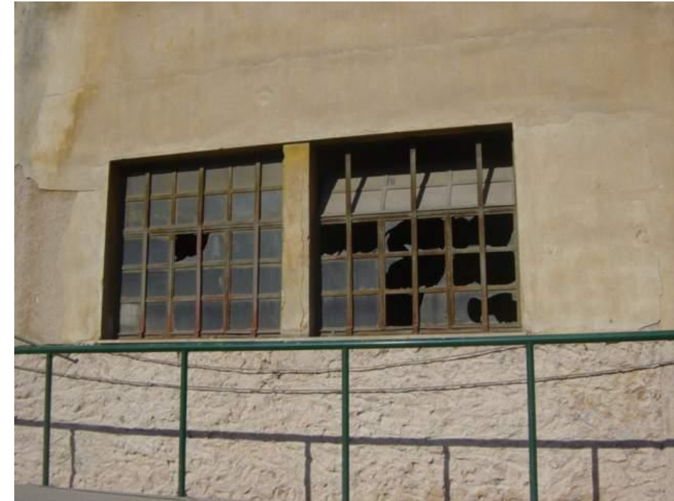
ΦΤ.08 Κοντινή λήψη ανοίγματος ανατολικής (Α) όψης.
