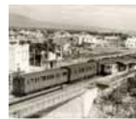
Σταθμός Ανω- Πατήσια
