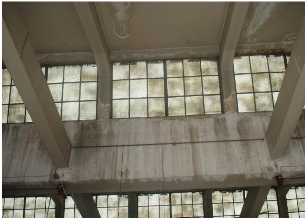
ΦΤ.11 Εσωτερική λήψη κουφωμάτων πριονωτής στέγης, αμαξοστασίου.
