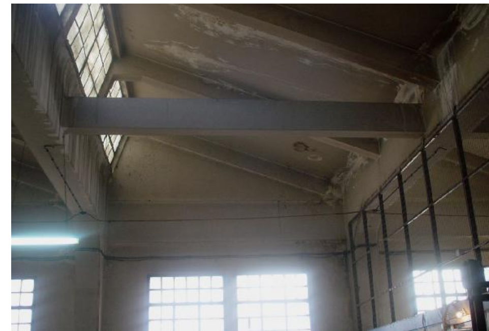
ΦΤ.10 Εσωτερική λήψη ζευκτών πριονωτής στέγης, αμαξοστασίου.
