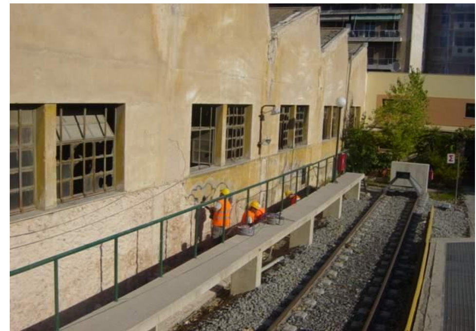
ΦΤ.04 Νοτιοδυτική (ΝΔ) όψη αμαξοστασίου και αποθήκης.
