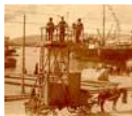
Ιπήλατη επισκευαστική άμαξα των ηλεκτροφόρων καλωδίων του τροχιοδρόμου στον Πειραιά
