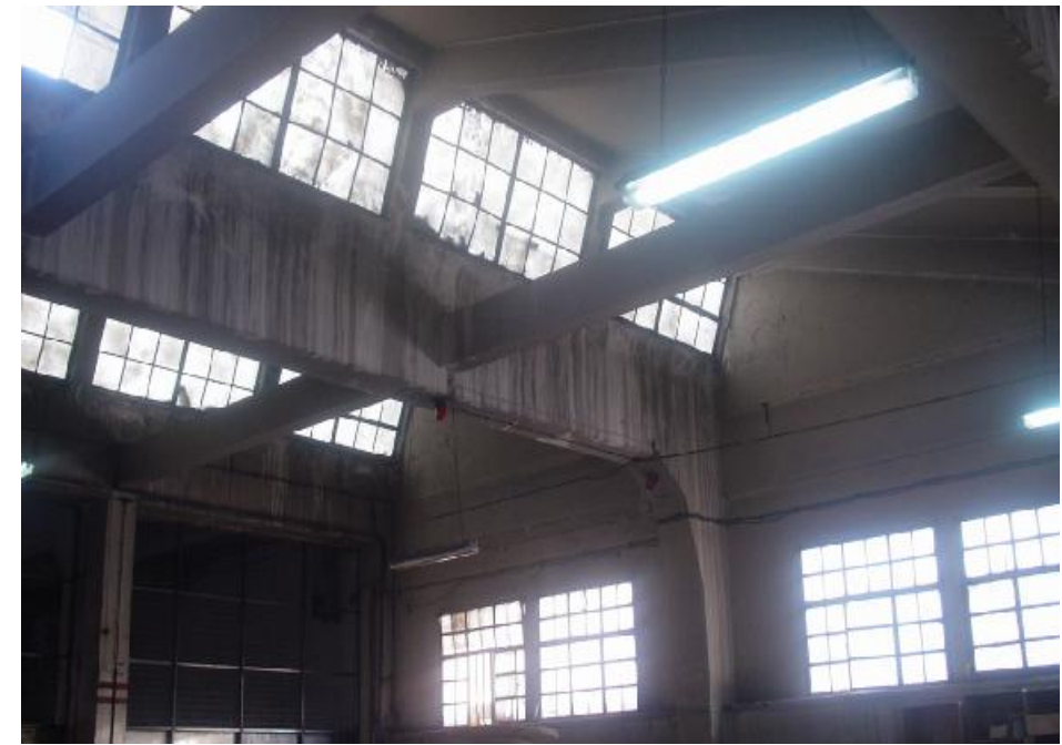
ΦΤ.12 Εσωτερική λήψη ζευκτών πριονωτής στέγης αμαξοστασίου, στα σύνορα με το συνεργείο.
