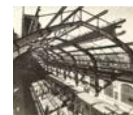
1926 - Κατασκευή Σταθμού Πειραιά
