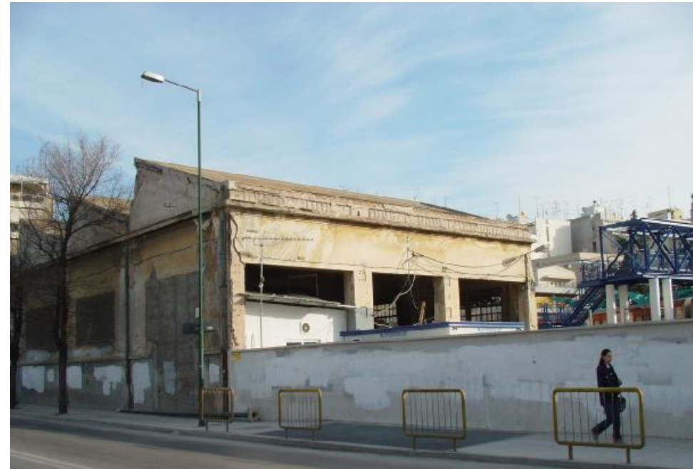
ΦΤ.02 Νοτιοδυτική (ΝΔ) όψη αμαξοστασίου.
