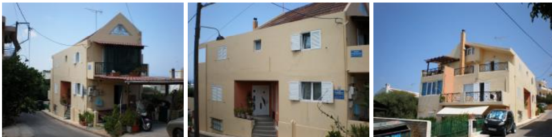
Υπάρχον κτιριακό κέλυφος.
