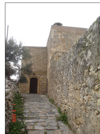
Όψη Ν-Δ τμήματος Φ N15
