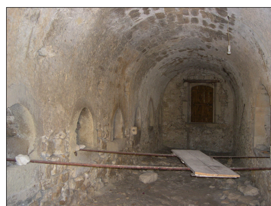
Εσωτερική Άποψη θολωτής αίθουσας Φ 06.7
