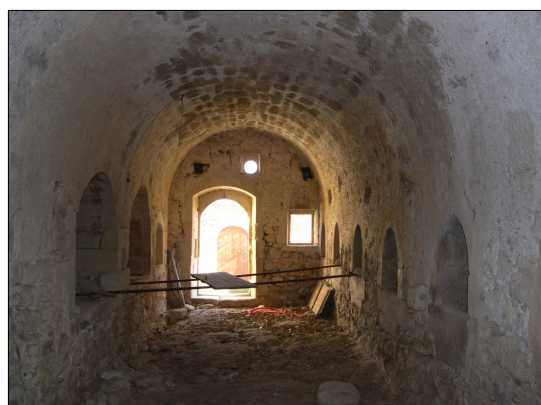
Εσωτερική Άποψη θολωτής αίθουσας Φ 06.6
