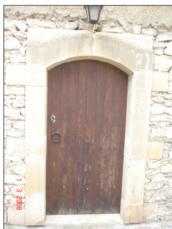
Όψη Ν-Δ τμήματος Φ N17
