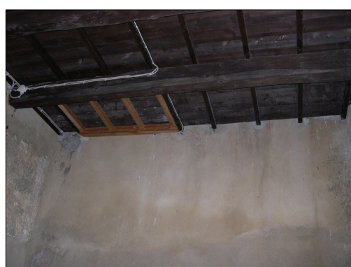
Δώμα ισογείου-Καταπακτή Φ 04.5
