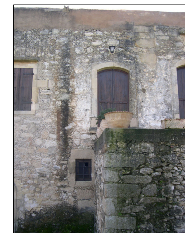
Άποψη ανοιγμάτων βορείου τμήματος Φ Β12
