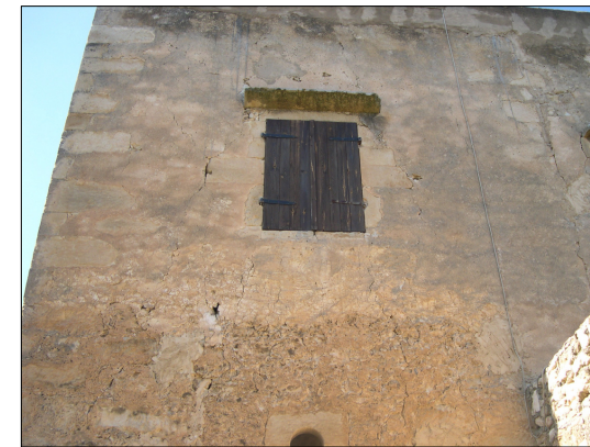
Άποψη Ανοίγματος ΚΤΑ/Κ1.09 Φ Α6
