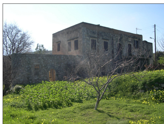
Βόρεια Άποψη του Κτιρίου Φ Β21
