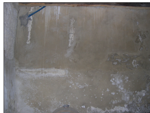
δείγμα νέου επιχρίσματος Φ 04.6
