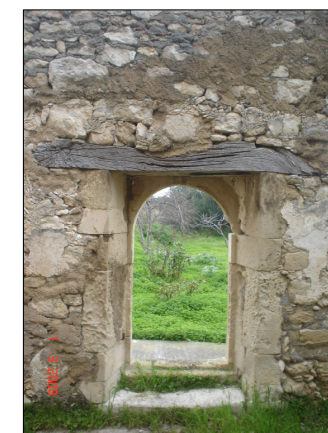
Άνοιγμα Βόρειου τοίχου Φ 05.2
