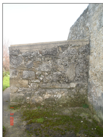
Δυτική Όψη Ξυλόφουρνου Φ Β17
