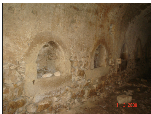
Εσωτερική Άποψη θολωτής αίθουσας Φ 06.10
