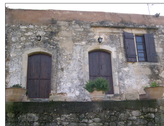
Άποψη ανοιγμάτων βορείου τμήματος Φ Β11
