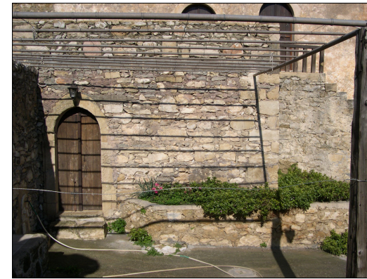
Όψη του χώρου A0.08 Φ N7
