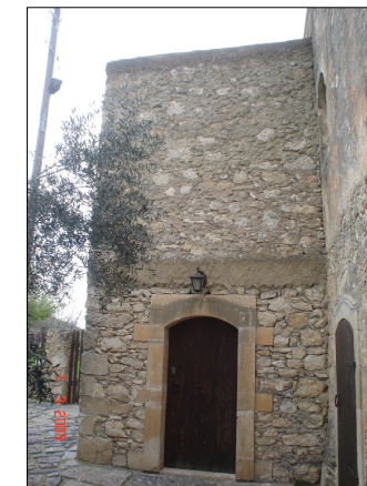
Όψη Ν-Δ τμήματος Φ N16
