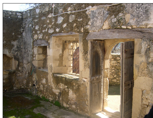
Εσωτερική Άποψη ασκεπή τμήματος Φ 05.9
