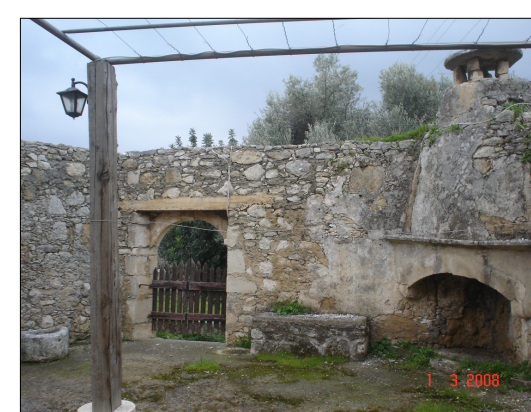
Άποψη Νότιας Όψης Εσωτερικά Φ 09.1
