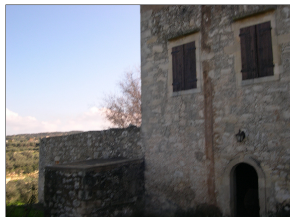
Άποψη Βόρειου Τμήματος Φ Β18
