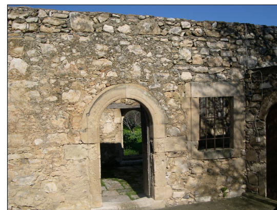
Νότιος Τοίχος ασκεπή Τμήματος Α0.06 Φ Ε3
