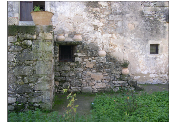
Άποψη βόρειας κλίμακας Φ Β8
