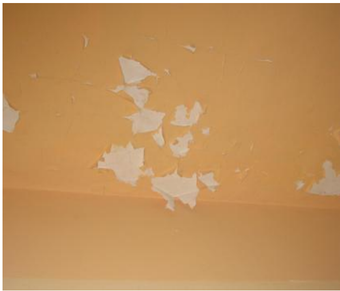
Ταβάνι και πλαϊνός τοίχος δωματίου 3. Σημάδια υγρασίας και αποχρωμάτιση
