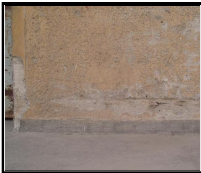
εικ.19 ΥΛΙΚΟ ΕΠΙΚΑΛΥΨΗΣ ΕΞΩΤΕΡΙΚΗΣ ΤΟΙΧΟΠΟΙΑΣ (χοντρός σοβάς)
