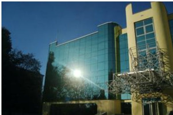
Εικόνα 3. 35 Κτίριο στα Σκόπια
