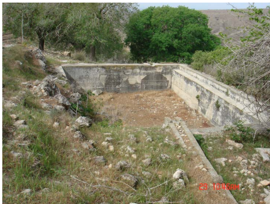
Εικ.86 Ανατολική άποψη από την δεξαμενή στην οποία διοχέτευαν νερό για τις ανάγκες του Συγκροτήματος. Σήμερα έχει επενδυθεί αυτή η πετρόκτιστη κατασκευή με τσιμεντοκονία.
