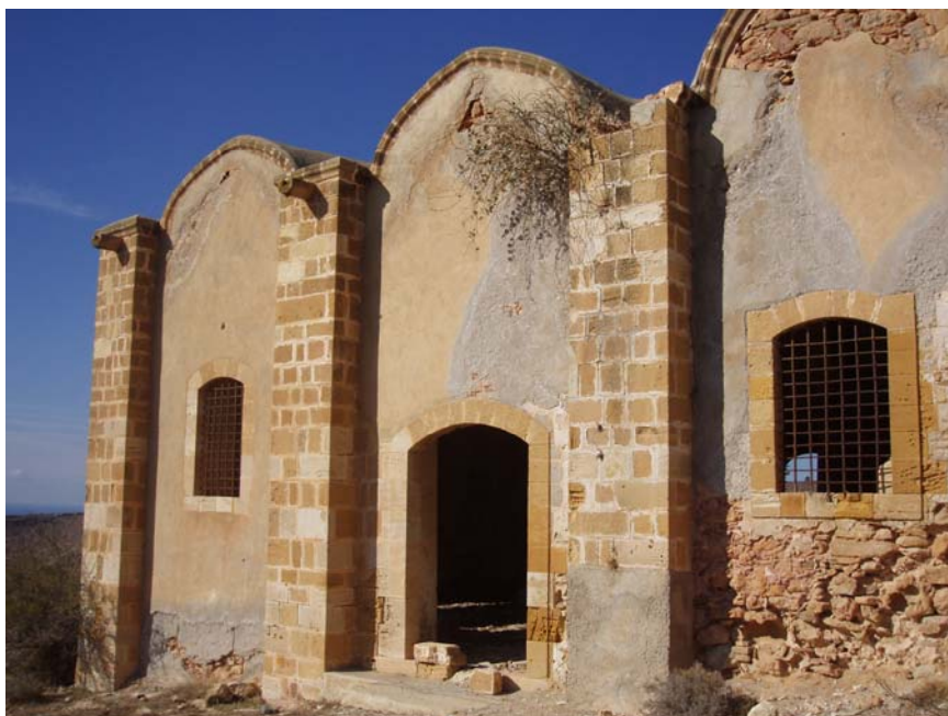
Εικ.57 Γενική Άποψη ανοιγμάτων του Νότιου κλίτους.
