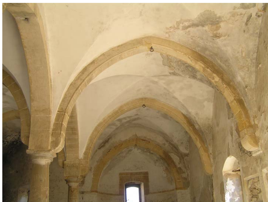
Εικ.45 Άποψη του εσωτερικού του Νότιου κλίτους που καταλήγει σε ημικυκλική εσωτερικά και τρίπλευρη εξωτερικά αψίδα και είναι καλυμμένο με σταυροθόλια.
