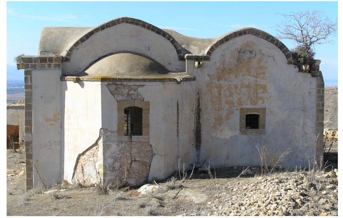
Εικ.23 Ανατολική άποψη του ναού. Επένδυση τοιχοποιίας καθολικού με ασβεστοκονία.
