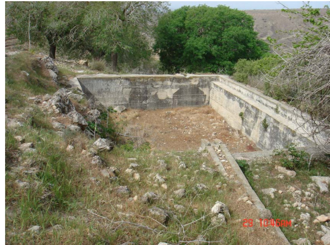
Εικ.86 Ανατολική άποψη από την δεξαμενή στην οποία διοχέτευαν νερό για τις ανάγκες του Συγκροτήματος
