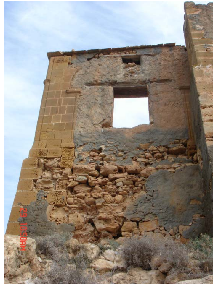
Εικ.14-15 Σημάδια αρχικής μορφής (γένεση τόξου).Νότια όψη
