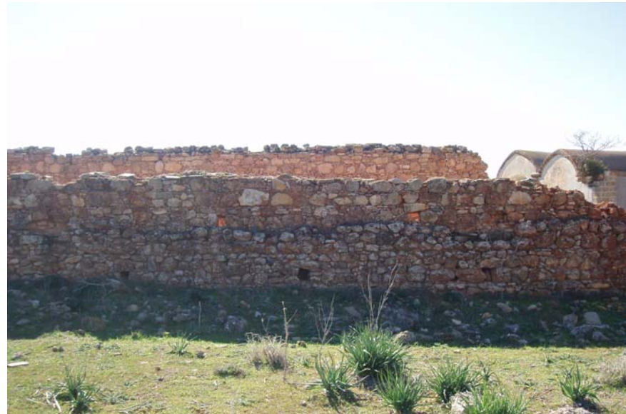
Εικ.74 Βόρεια άποψη των αποθηκών. Κτισμένη η τοιχοποιία σε δυο παρειές.
