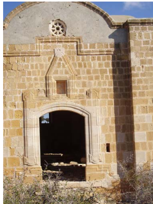
Το πλαίσιο θυρώματος της κυρίας εισόδου του καθολικού από Δυτικά.
