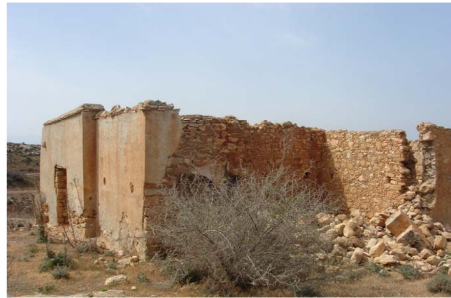
Εικ.8 Βορειοανατολική άποψη των κελιών Υπολείμματα από την αρχική κατασκευή δώματος στο Ηγουμενείο..
