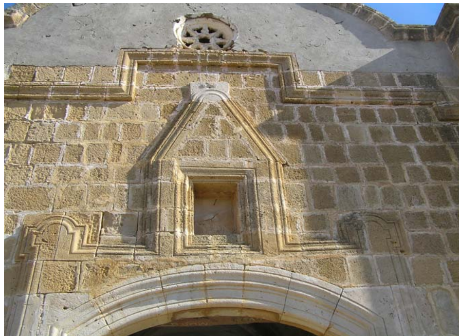
Εικ.33 Λεπτομέρεια του θυρώματος - κόγχη θυρώματος - επιβλητικά διακοσμημένη η κεντρική είσοδος του Ναού.
