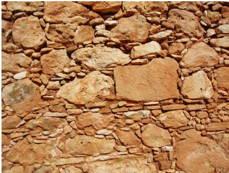
Τρόπος κτισίματος της τοιχοποιίας τόσο στους βοηθητικούς χώρους τόσο και στο ηγουμενείο
