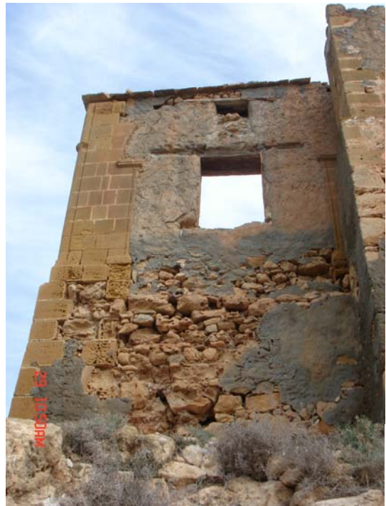
Εικ.14-15 Σημάδια αρχικής μορφής (γένεση τόξου).Νότια όψη
