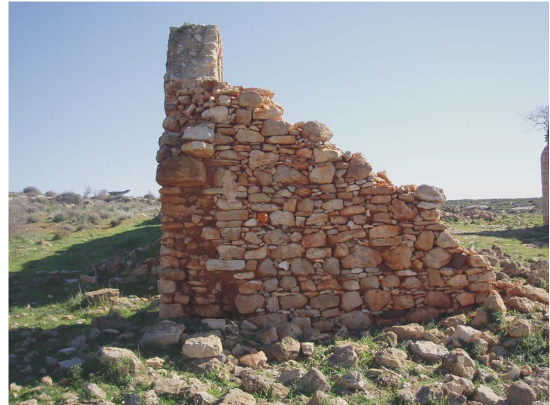
Εικ.78 Δυτική άποψη του κτιρίου των αποθηκών-κυρίας εισόδου.
