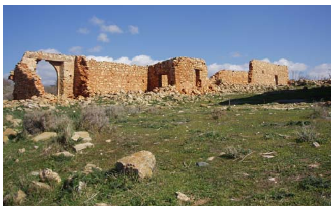
Εικ.64 Γενική άποψη των αποθηκών από Νοτιοδυτικά.
