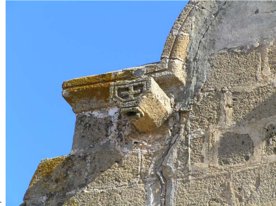
Εικ.35 Λεπτομέρεια γείσου και λαξευτής λίθινης υδρορρόης στην πρόσοψη του ναού (Δυτικά).
