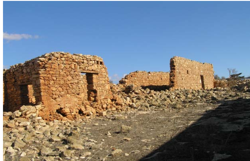
Εικ.67 Νοτιοδυτική άποψη των αποθηκών.
