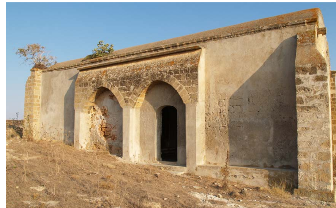
Εικ.26 Γενική άποψη του Βόρειου κλίτους. Κτισμένο σε επικλινές βραχώδεις έδαφος.
