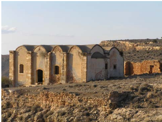
Εικ.26 Γενική άποψη του Βόρειου κλίτους. Εμφανής η θεμελίωση του καθολικού πάνω σε φυσικό βραχώδες έδαφος.
