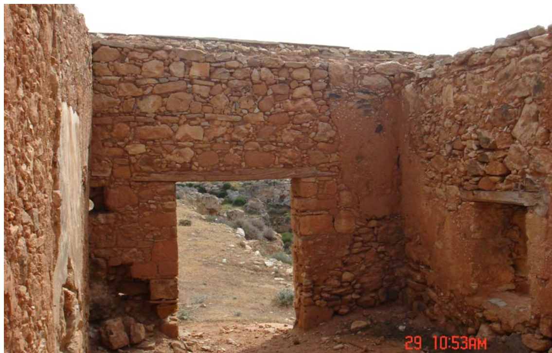
Εικ.21 Εσωτερική άποψη του χώρου K01 . Είσοδος του χώρου απέναντι
