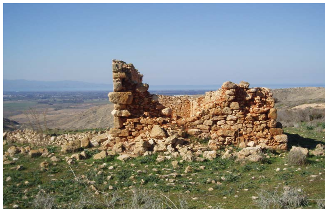
Εικ.72 Ανατολική άποψη των αποθηκών. Στο βάθος ο κόλπος της κατεχόμενης Μόρφου.
