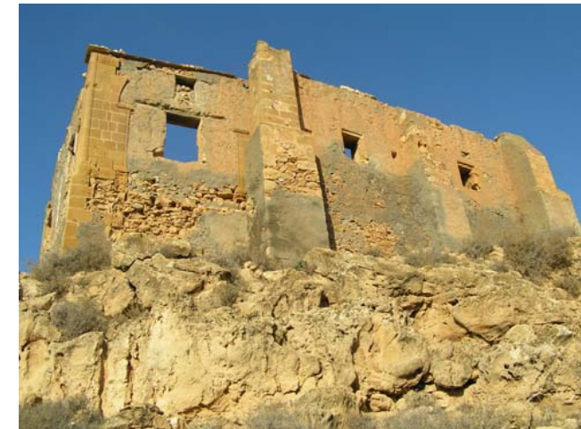
Το ηγουμενείο είναι κτισμένο πάνω στο φυσικό βραχώδες έδαφος καθώς επίσης και σε μεγαλειώδεις αντηρίδες.
