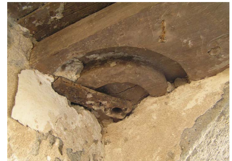
Εικ.55 Λεπτομέρεια οδηγού θύρας Βόρειου κλίτους (ότι έχει απομείνει).
