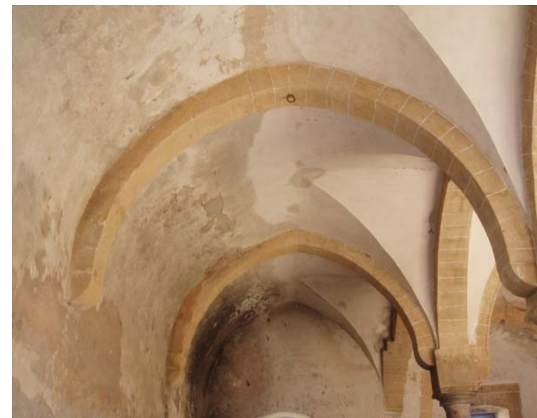
Εικ.53 Λεπτομέρεια αψίδας στο Βόρειο κλίτος καθώς και η γεφύρωση του κλίτους με ημισταυροθόλια .
