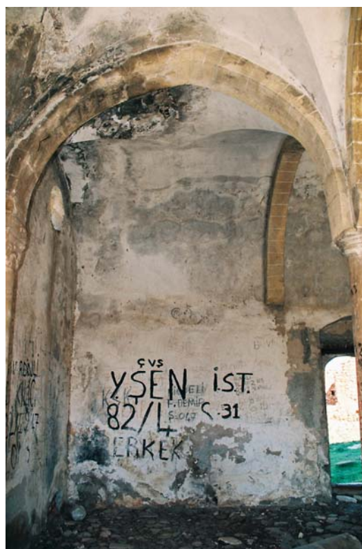
Εικ.47 Λεπτομέρεια της 1 ης αψίδας από την Τοξοστοιχία που φέρεται στους τέσσερις κίονες. Εντονα τα σημάδια πυρκαγιάς και βανδαλισμού από Τούρκους 'επισκέπτες'.
