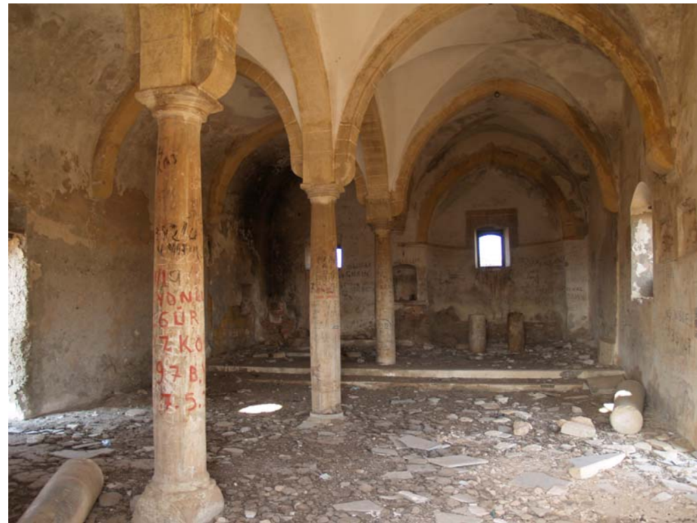
Εικ.39 Εσωτερική άποψη του ναού προς Δυσμάς. Τα δυο κλίτη χωρίζονται από μια Τοξοστοιχία που φέρεται στους τέσσερις κίονες.
