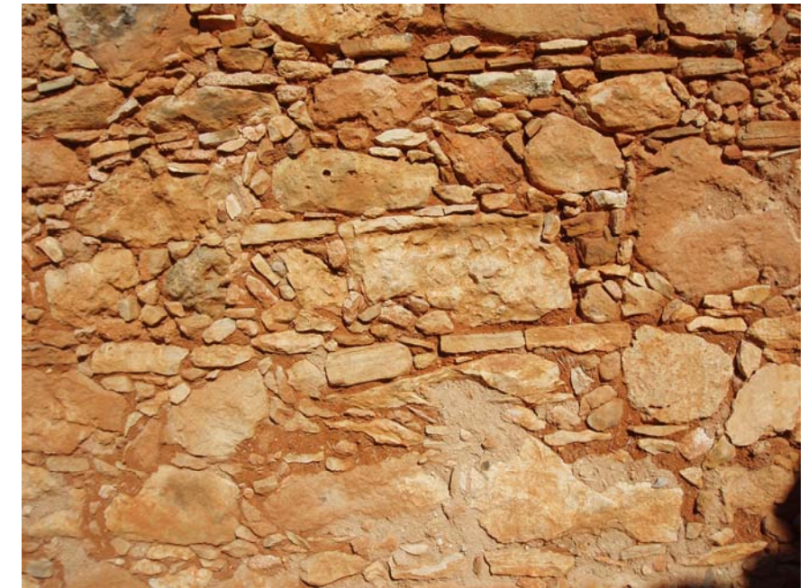
Ανεπίχριστη τοιχοποιία από το εξωτερικό των επιφανειών των αποθηκευτικών χώρων
