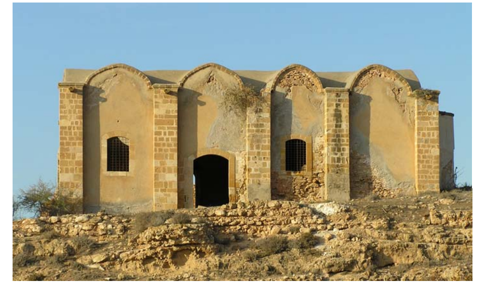
Εικ.56 Γενική άποψη του Νότιου κλίτους. Διακρίνονται τα τέσσερα οξυκόρυφα τόξα που είναι κάθετα στο Νότιο κλίτος.
