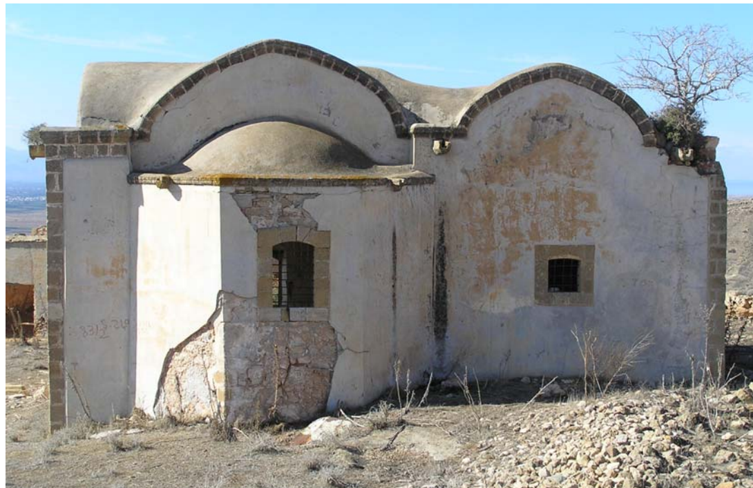
Εικ.23 Ανατολική άποψη του ναού
