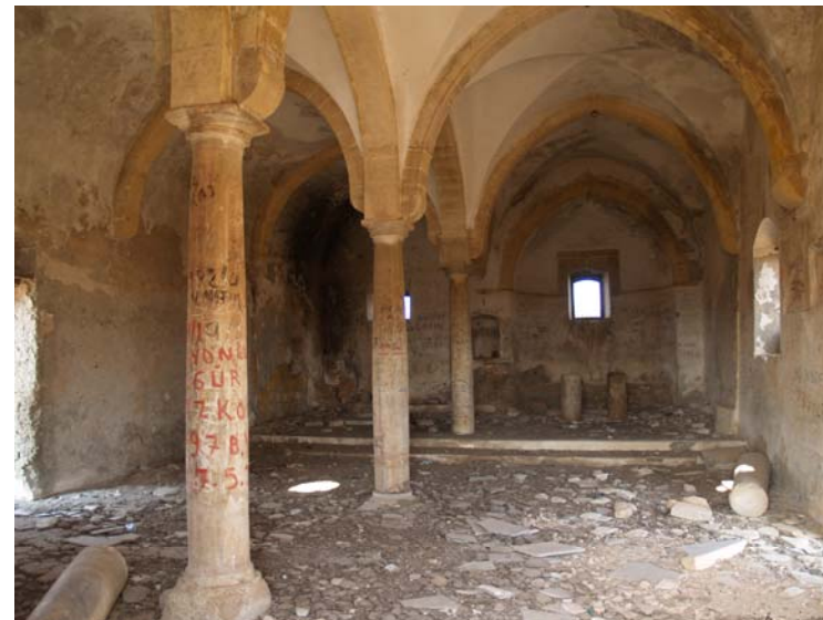
Εικ.39 Εσωτερική άποψη του ναού προς Δυσμάς. (Βανδαλισμοί, απουσία Τέμπλου). Τα δυο κλίτη χωρίζονται από μια Τοξοστοιχία που φέρεται στους τέσσερις κίονες
