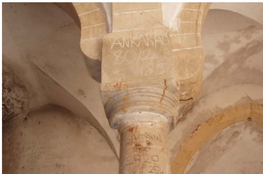
Εικ.51 Λεπτομέρεια από το μαρμάρινο κιονόκρανο Δωρικού ρυθμού και το φουρούσι του τόξου
