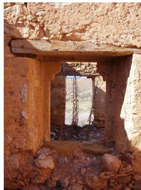
Εικ.55 Λεπτομέρεια κουφώματος στο εσωτερικό Του Ηγουμενείου.
