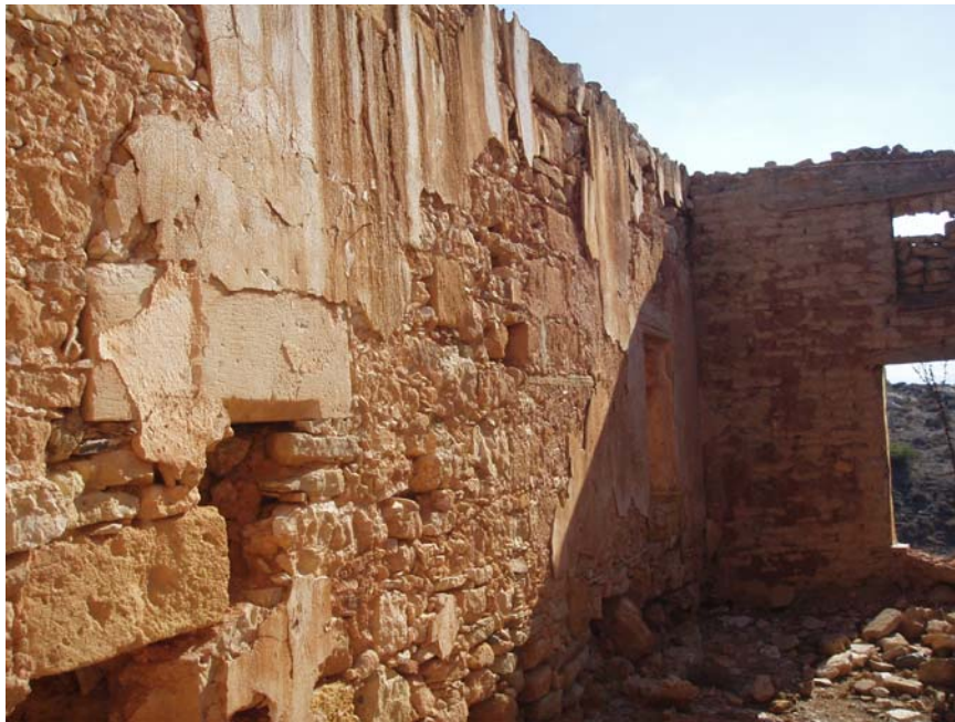
Επιφάνειες στο εσωτερικό του ηγουμενείου (ΚΟΙ) οι οποίες ήταν επιχρισμένες με γύψο
