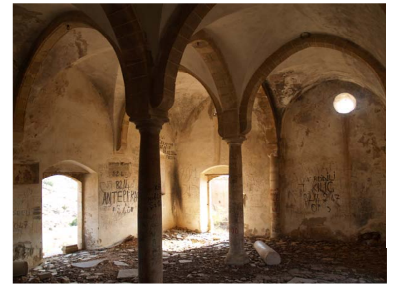
Εικ.38 Εσωτερική άποψη του ναού προς Ανατολάς .Επενδυμένα και τα δυο κλίτη με ασβεστοκονίαμα.
