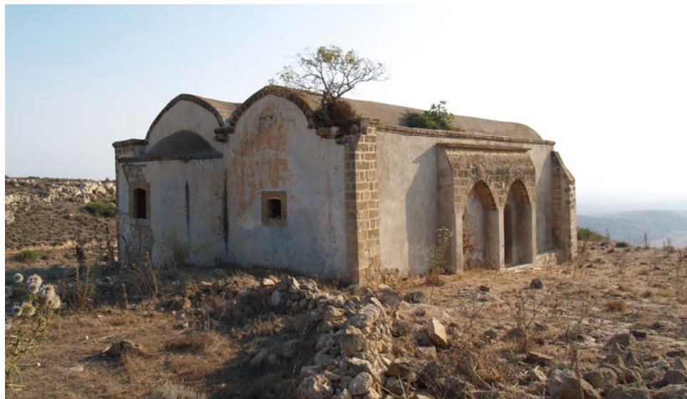
Εικ.24 Βορειοανατολική άποψη του ναού, Νότιο και Βόρειο κλίτος. Διακρίνεται στο Νότιο κλίτος το τετρατοσφαίριο της αψίδας ιερού και στο Βόρειο Κλίτος η κατά μήκος καμάρα που έχει τον ρόλο της αντηρίδας.
