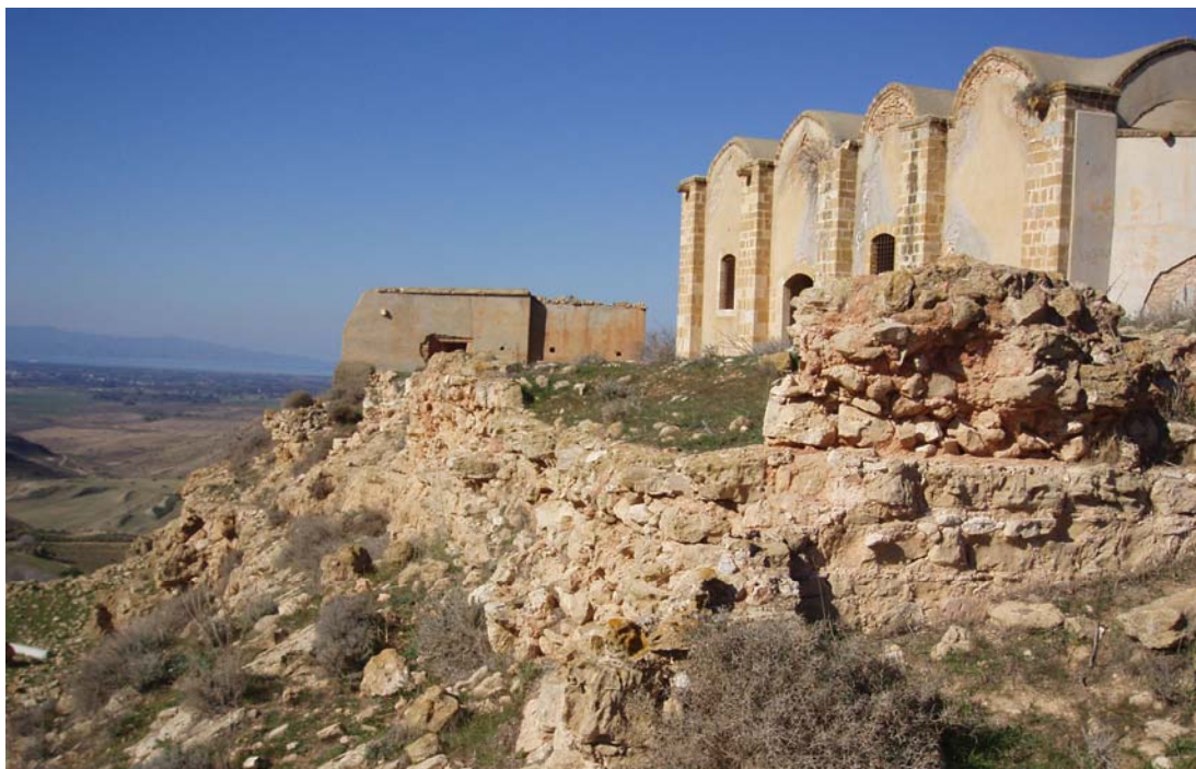
Εικ.85 Σημάδια ερειπίων που αποδεικνύουν την ύπαρξη αντηρίδας Νοτιοανατολικά του Συγκροτήματος και γενικότερα την ύπαρξη περικλειστού τοίχου.
