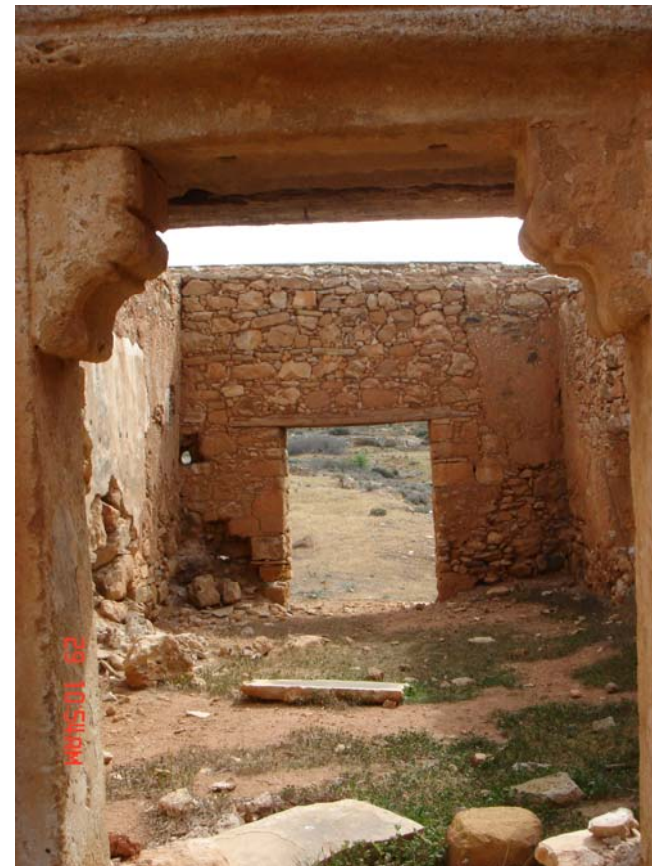
Εικ.19 Από το εσωτερικό του χώρου K03 βλέποντας από μικρό κούφωμα στο εσωτερικό του χώρου K01
