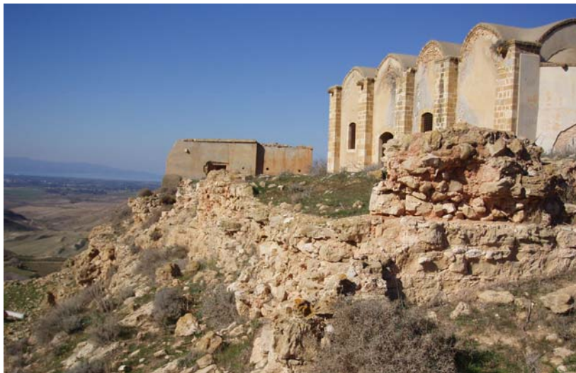
Εικ.85 Σημάδια ερειπίων που αποδεικνύουν την ύπαρξη αντηρίδας Νοτιοανατολικά του συγκροτήματος και γενικότερα την ύπαρξη περίκλειστου τοίχου.
