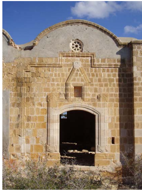
Εικ.32 Άποψη της κυρίας εισόδου του ναού. Η τοιχοποιία είναι από σκληρό πορώδες λίθο
