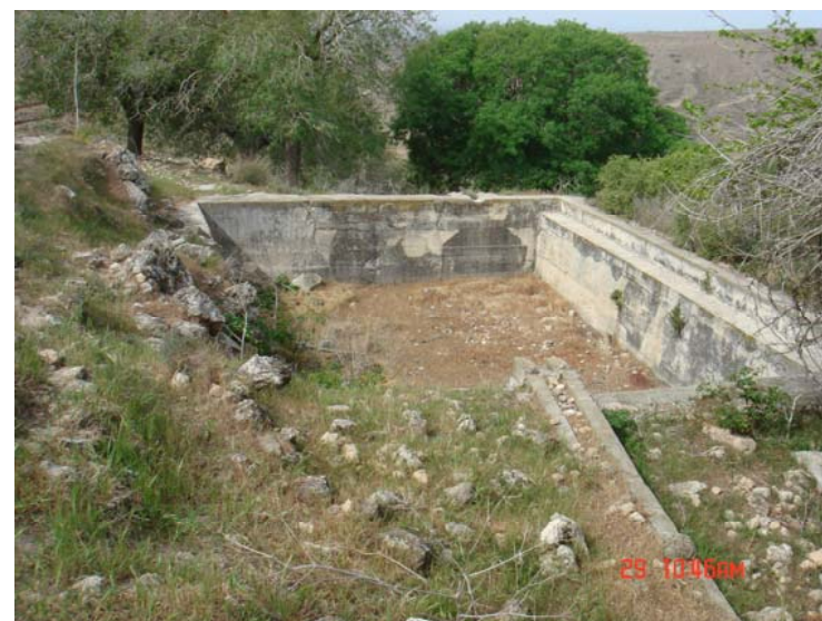
Εικ.86 Ανατολική άποψη από την δεξαμενή στην οποία διοχέτευαν νερό για τις ανάγκες του Συγκροτήματος
