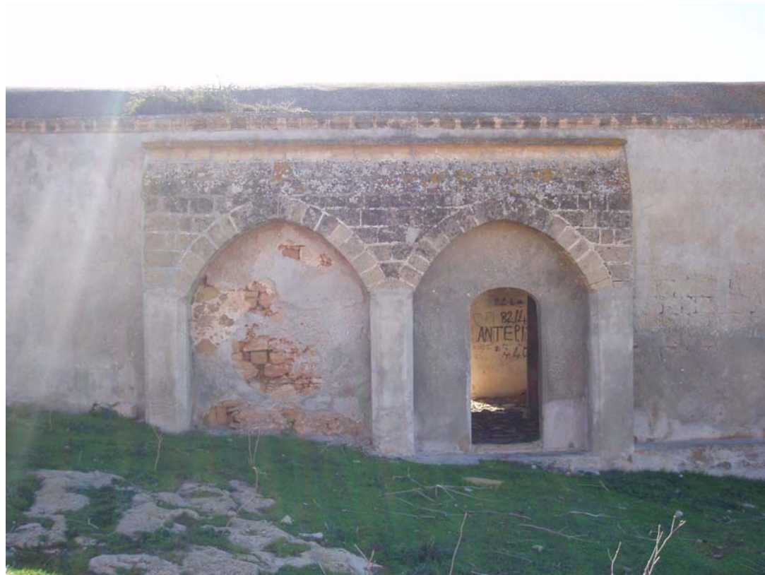
Εικ.27 Κατά μήκος καμάρα Βόρειου κλίτους που έχει τον ρόλο και ως αντηρίδα . Πιθανόν το τμήμα του τοίχου αυτού να ανήκει σε παλαιότερες εκκλησίες σύμφωνα με τον Ρώσο Μοναχό Μπάρσκυ.
