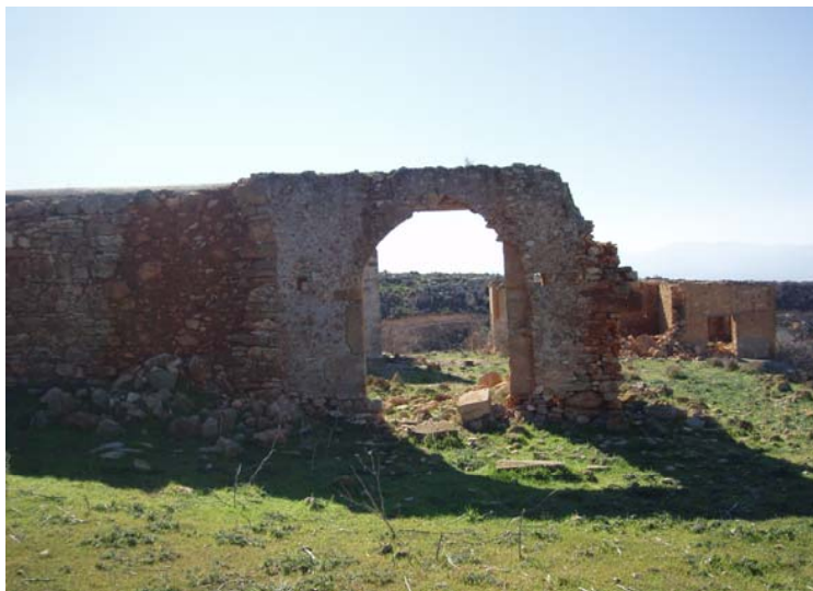
Εικ.77 Βόρεια άποψη κυρίας εισόδου του μοναστηριακού συγκροτήματος η οποία γεφυρώνεται με ένα οξυκόρυφο τόξο.
