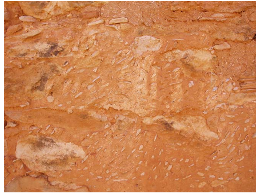
Τεχνική που χρησιμοποιούσαν για επίχρισμα στους εσωτερικούς χώρους
