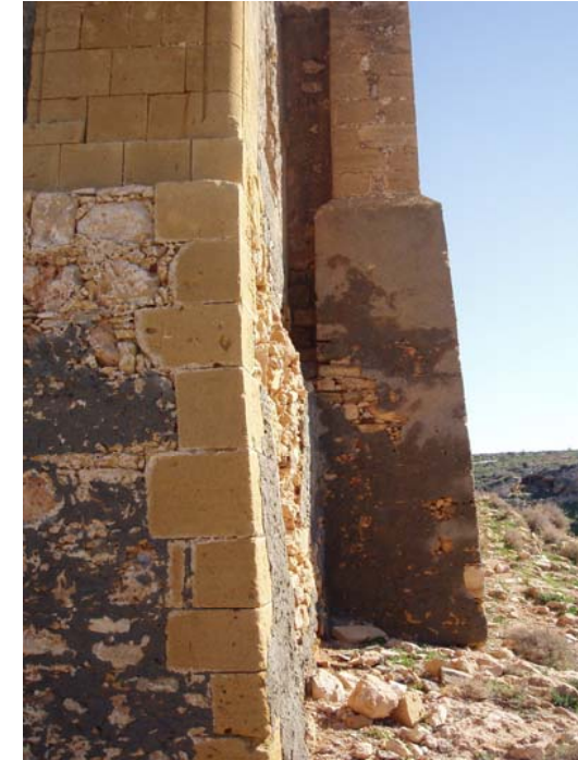
Εικ.13 Λεπτομέρεια από βάση αντηρίδας στο Δυτικό μέρος του κτίσματος
