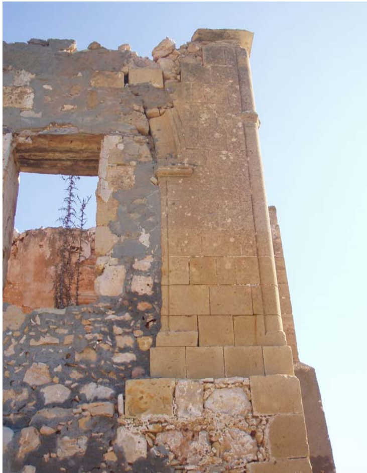
Εικ.12 Δυτικά του κτίσματος - Σημάδια αρχικής μορφής (γένεση τόξου)
