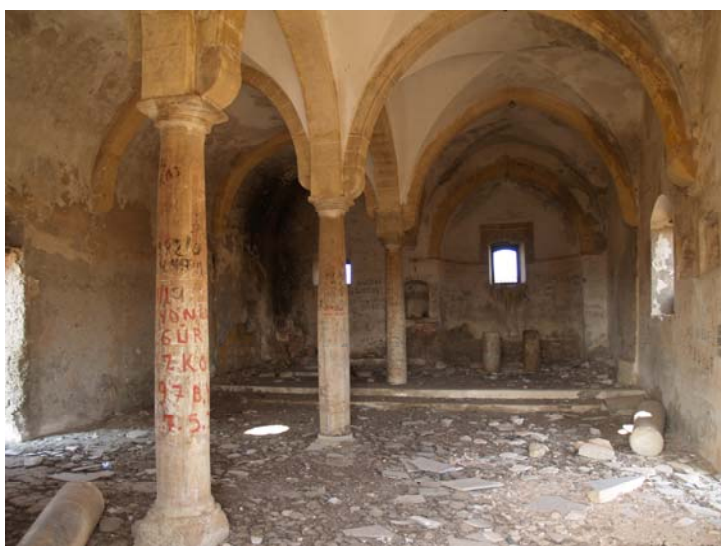
Εικ.39 Εσωτερική άποψη του ναού προς Δυσμάς. Τα δυο κλίτη χωρίζονται από μια Τοξοστοιχία που φέρεται στους τέσσερις μαρμαρίνους κίονες
