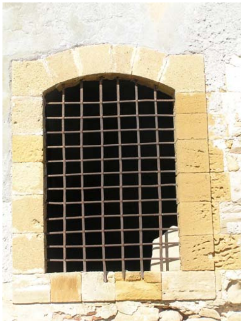
Εικ.60 Λεπτομέρεια κουφώματος Νότιου κλίτους . Οξείδωση μεταλλικής σιδεριάς.
