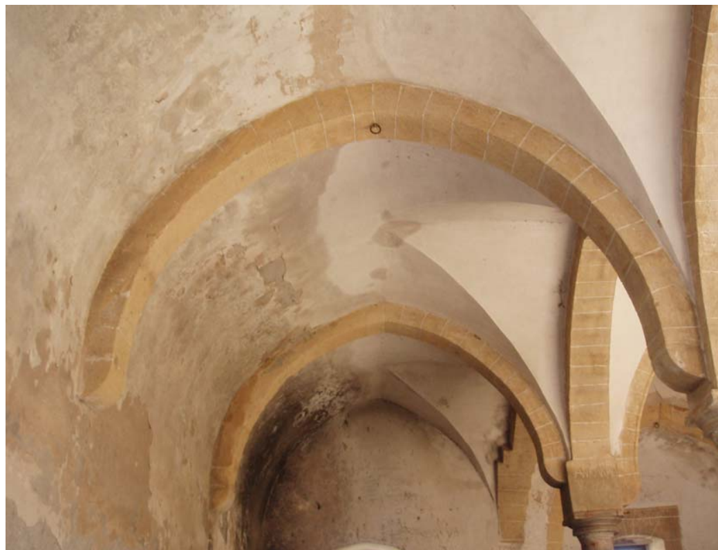
Εικ.53 Λεπτομέρεια αψίδας στο Βόρειο κλίτος (2 η τοξοστοιχία) καθώς και η γεφύρωση του κλίτους με ημισταυροθόλια .
