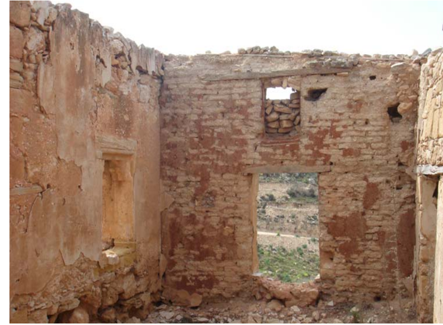
Εικ.18 Εσωτερική άποψη των κελιών (Βόρεια του κτίσματος) χώρος K03
