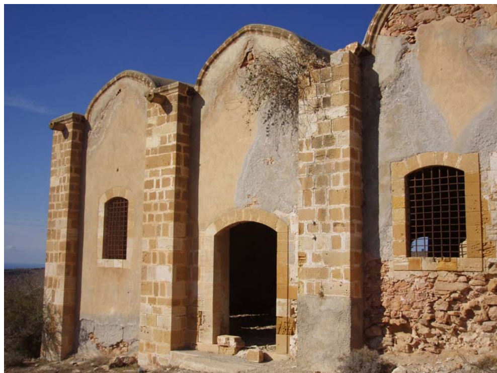
Εικ.57 Άποψη εσόδου του Νότιου κλίτους.
