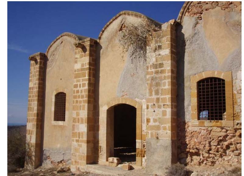
Εικ.57 Άποψη εσόδου του Νότιου κλίτους. Οι αντηρίδες είναι κατασκευασμένες από πωρόλιθο και η φέρουσα τοιχοποιία του καθολικού από ασβεστιογενή πετρώματα.
