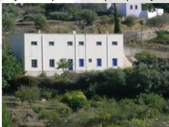
Εικόνα 69: Αποψη της δυτικής πλευράς της σχολής
