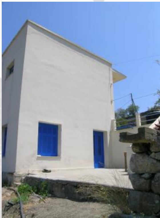
Εικόνα 70: Αποψη της νότιας πλευράς της σχολής
