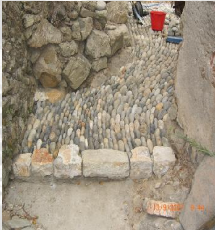
Εικόνα 94: Τοποθέτηση λαξευμένων ορθογώνιων λίθων για τη διαμόρφωση κλίμακας
