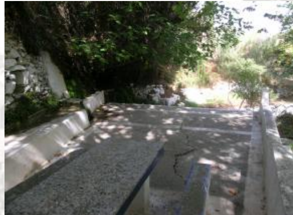
Εικόνα 84: Αποψη του χώρου της πηγής
