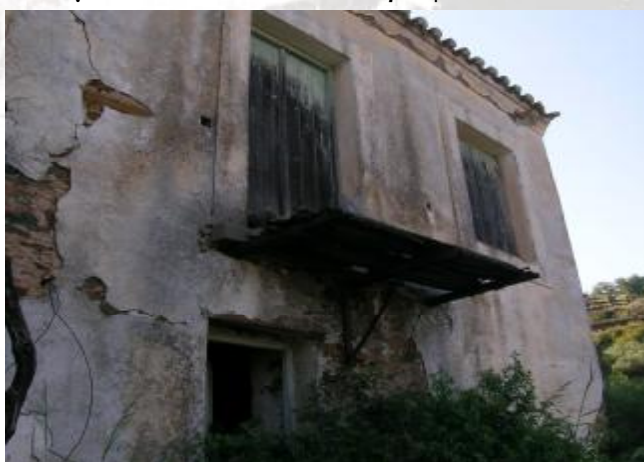
Εικόνα 38: Υπόλειμμα εξώστη με μεταλλικές βάσεις και ξύλινο δάπεδο.
