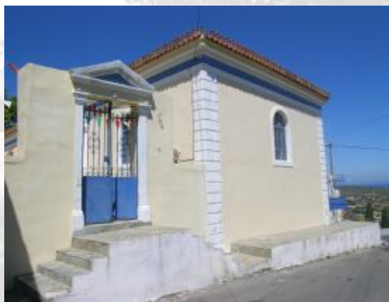
Εικόνα 47: Αποψη της ανατολικής πλευράς του σχολείου
