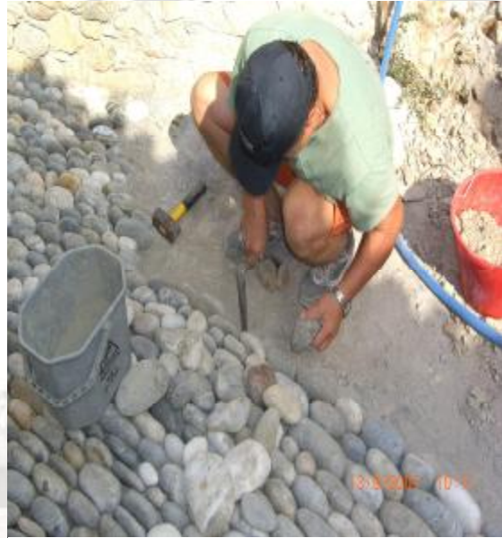
Εικόνα 93: Σφήνωμα λίθων για τη κατασκευή του λιθόστρωτου
