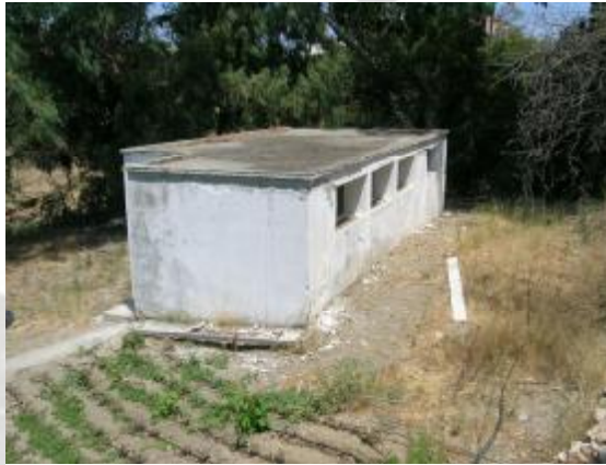
Εικόνα 77: Άλλη άποψη του κτίσματος των αποχωρητηρίων και της αποθήκης
