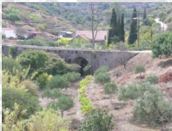
Εικόνα 27: Η Αγγλική γέφυρα του Λεπιδά
