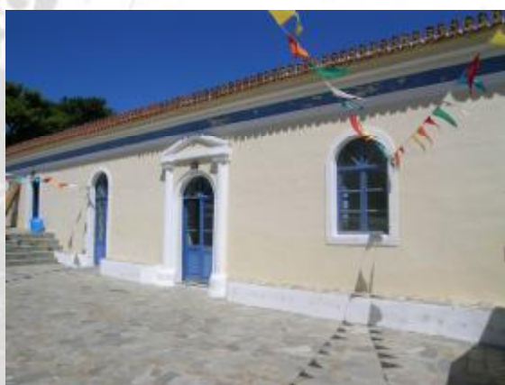
Εικόνα 48: Αποψη της νότιας πλευράς του σχολείου
