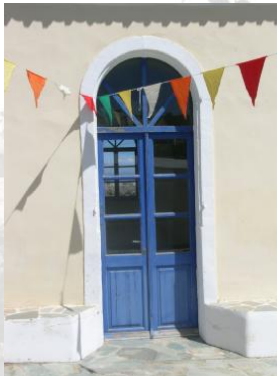
Εικόνα 50: Αποψη της δεύτερης εισόδου του σχολείου
