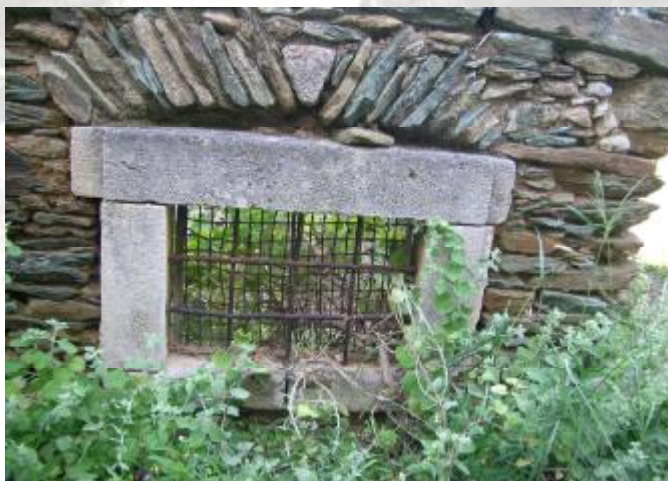
Εικόνα 30: Δείγμα χρήσης πωριού σε άνοιγμα
