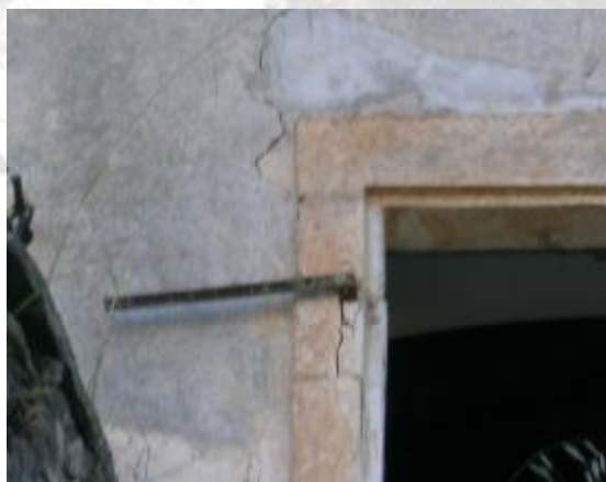
Εικόνα 32: Χρήση του σιδήρου για τα μάσκουλα των κουφωμάτων
