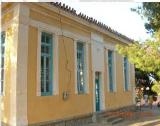
Εικόνα 54: Αποψη της νότιας πλευράς του Παρθεναγωγείου
