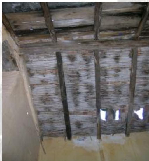
Εικόνα 31: Χρήση του ξύλου και του καλάμιού στη κατασκευή της στέγης
