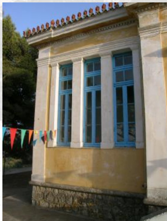
Εικόνα 47: Αποψη των ανοιγμάτων του Παρθεναγωγείου
