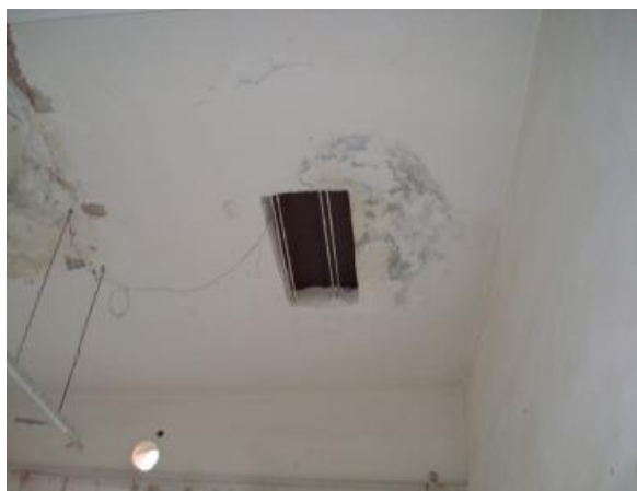
Εικ. 36 φεγγίτες στην στέγαση του ορόφου
