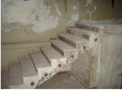
Εικ. 25 ίχνη μεταλλικού κιγκλιδώματος
