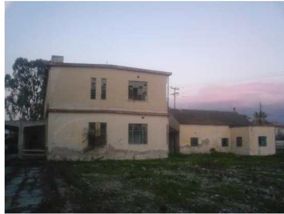
Εικ.11 δυτική όψη κτιρίου
