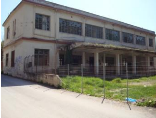
Εικ.10 πρόσψη κτιρίου Κρητικού
