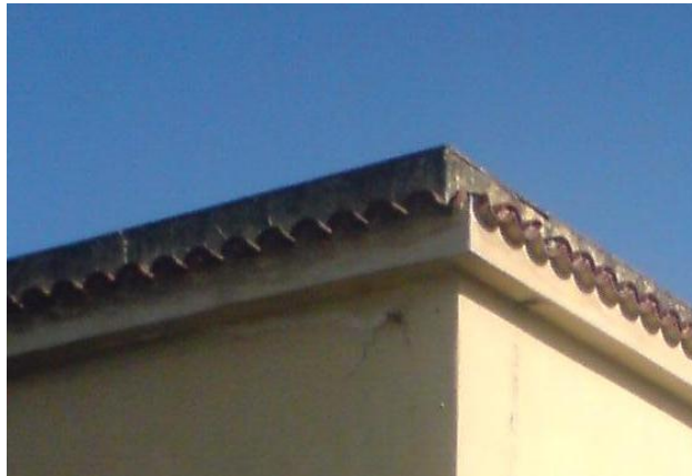
Εικ.42 περιμετρικό διάζωμα με επικάλυψη ενός κεραμιδιού
