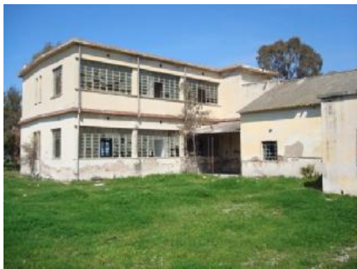
Εικ. 16 άποψη νότιας όψης
