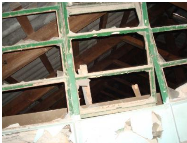
Εικ.29 πρόσβαση για την στέγη του μαγειρίου
