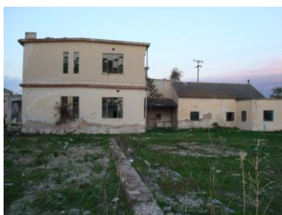
Εικ. 33 χώρος μαγειρείου στη νότια όψη
