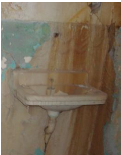
Εικ. 47 διάβρωση επιχρίσματος
