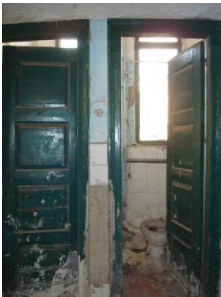
Εικ.23 ξύλινες ταμπλαδωτές πόρτες
