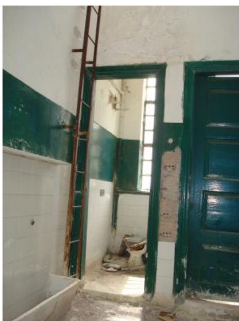
Εσωτερική άποψη των wc του ορόφου (βοηθητική κλίμακα)
