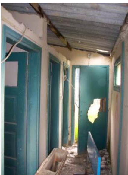
Εσωτερικά ο χώρος της προσθήκης
