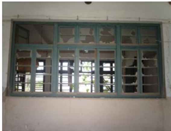
Εικ. 24 μεταλλικά εξωτερικά κουφώματα
