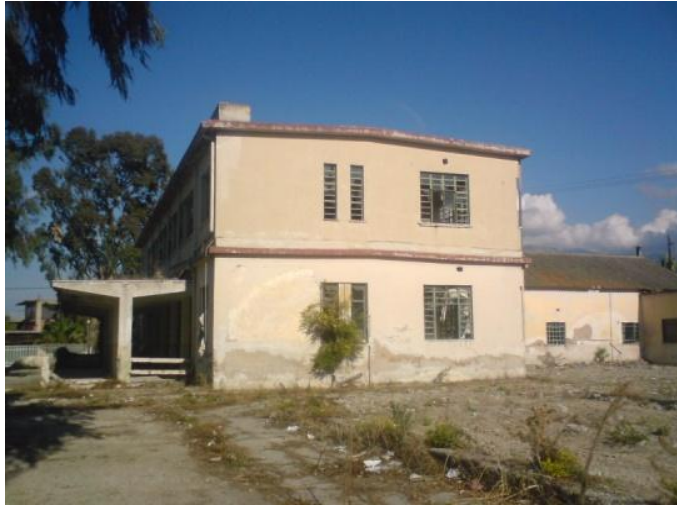
Εικ. 22 δυτική όψη κτιρίου
