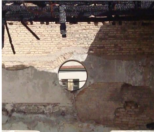
Εικ.39 κυκλικό άνοιγμα
