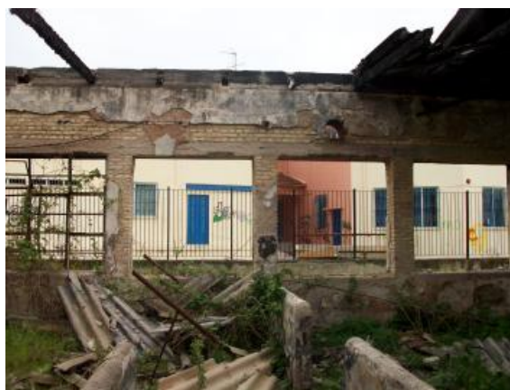
Εσωτερικά των ανοιγμάτων της νότιας όψης
