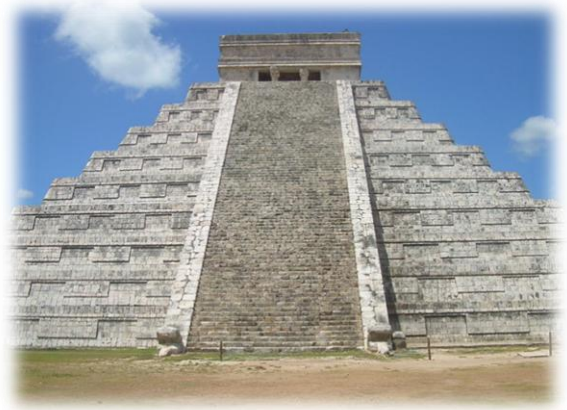
Εικόνα 9. El Castillo, Βόρεια πλευρά
