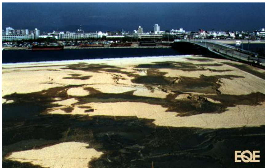
Εικόνα 1.3 Φαινόμενα Ρευστοποίησης (σεισμός Kobe - Ιαπωνία 1995)
