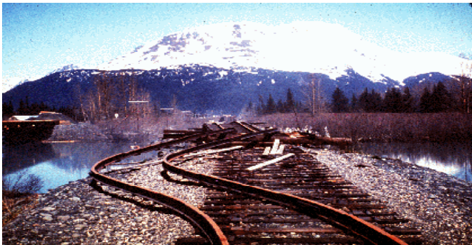
εικόνα 1.6 Βλάβη σε σιδηροδρομικό σταθμό (Αλάσκα 1964)
