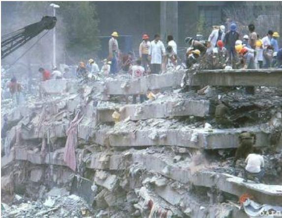
εικόνα 1.8 Νοσοκομείο κατέρρευσε κατά την διάρκεια σεισμού που έπληξε την πόλη του Μεξικού 1985
