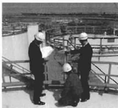
Επιθεώρηση σε υπό κατασκευή κτίριο
