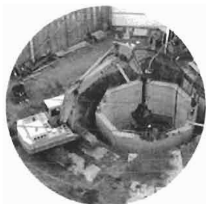
Κατασκευή δεξαμενής
