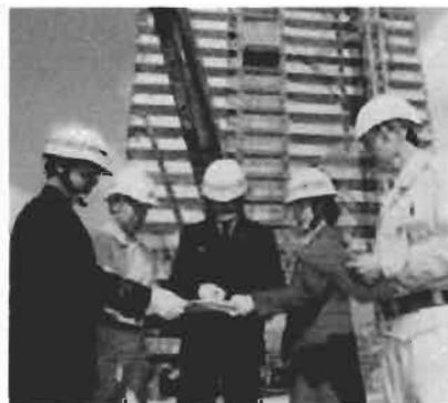
Επιθεώρηση εγκαταστάσεων επισφαλών υλικών
