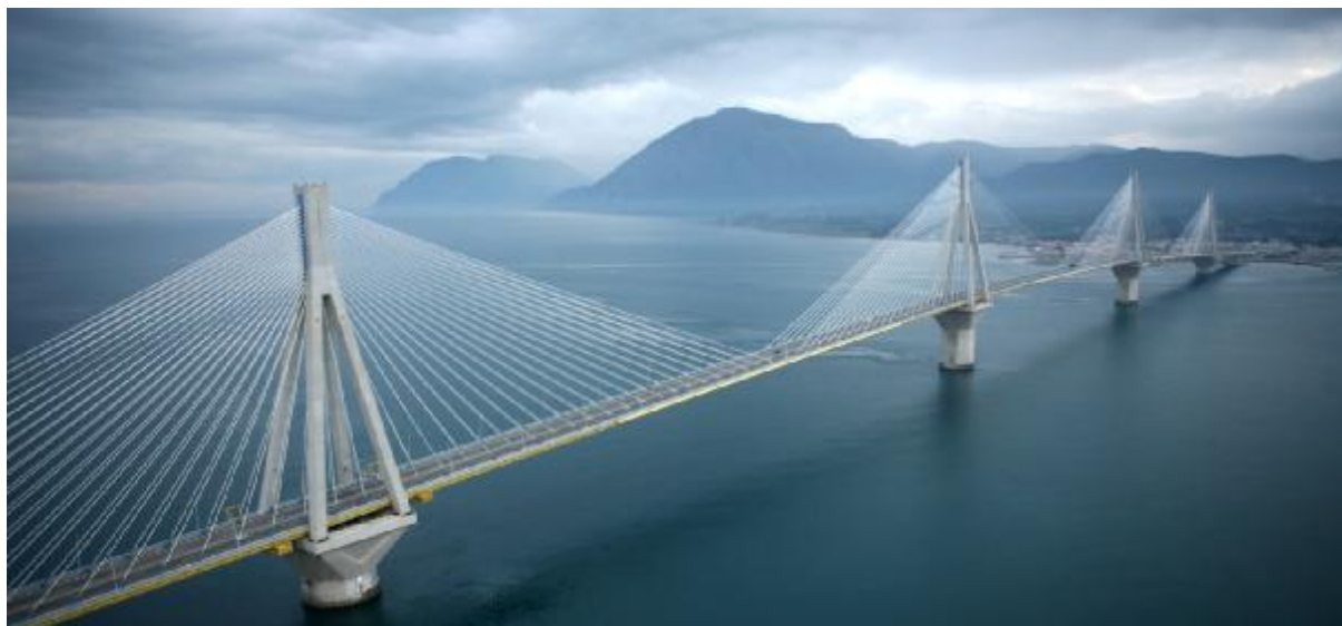
Εικόνα 3.3 Γέφυρα Ρίου - Αντιρρίου
