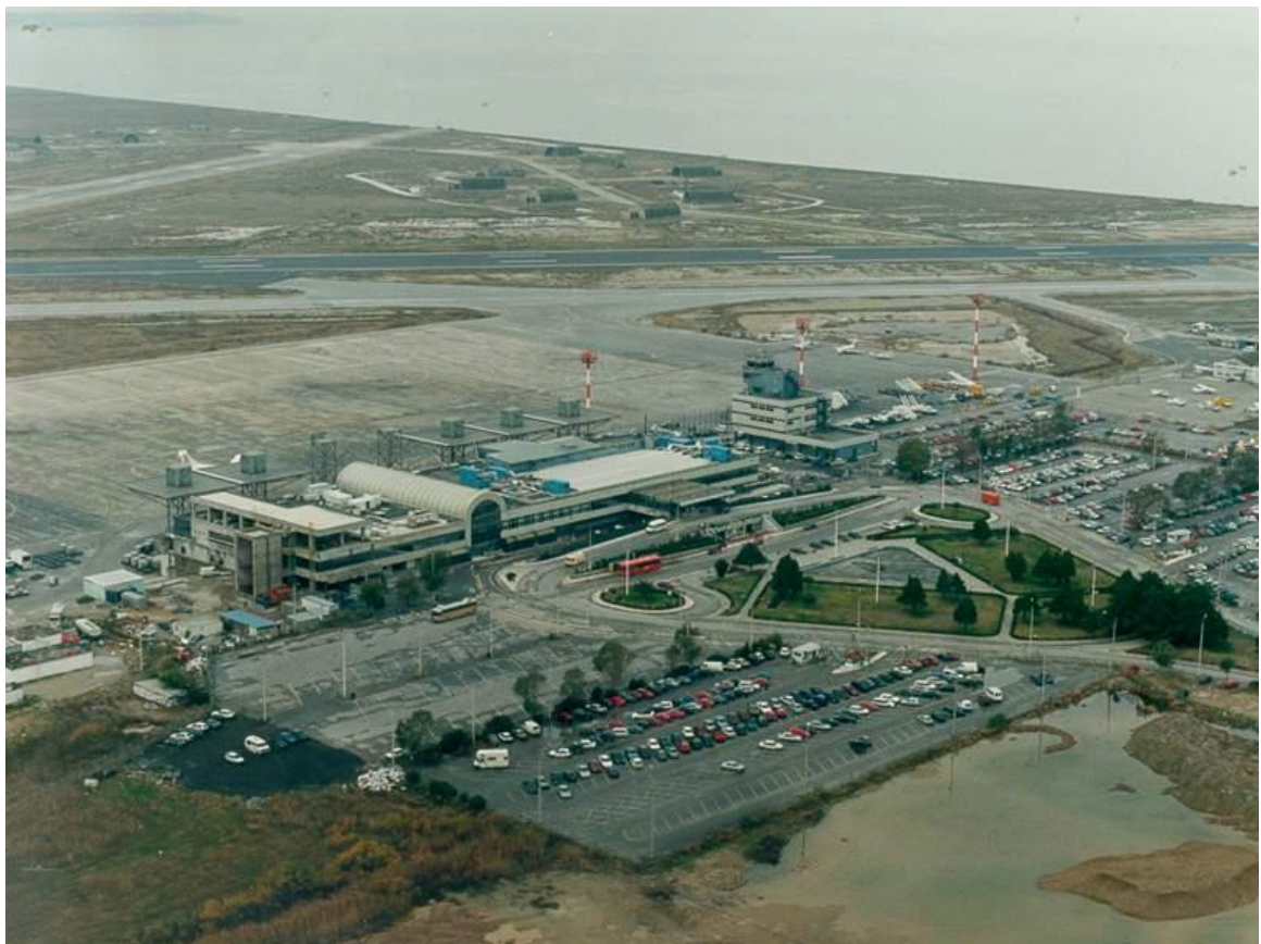
Φωτογραφία Αεροδρόμιο Θεσσαλονίκης «Μακεδονία»
