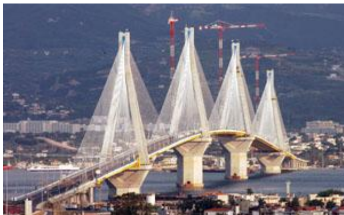
Εικ. 63. Γέφυρα Ρίου Αντιρρίου
