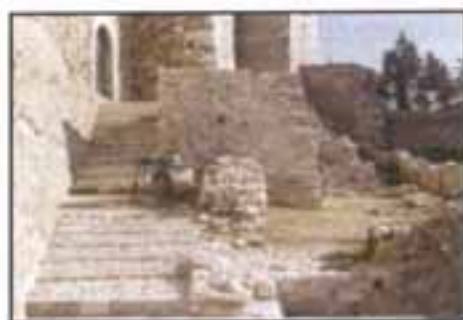
Κάστρο Πάτρας. Η είσοδος στον εσωτερικό περίβολο μετά τις εργασίες
