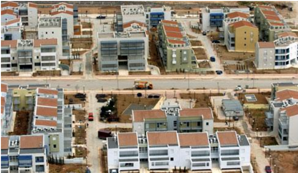
Εικόνα 4 Πανοραμική Άποψη του Ολυμπιακού Χωριού σε Περίοδο Έργων σε Εξέλιξη (Πηγή: www.athens2004.gr/en/ImageGalleries/multigallery?image )
