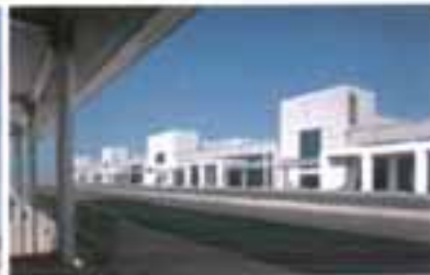
Κτίριο κεντρικού αεροσταθμού
