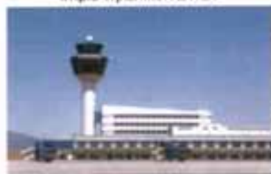
Πύργος Ελέγχου & κτίριο τηλεπικοινωνιών
