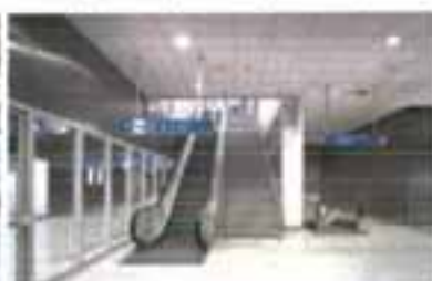
Κτίριο κεντρικού αεροσταθμού ανελκυστήρες
