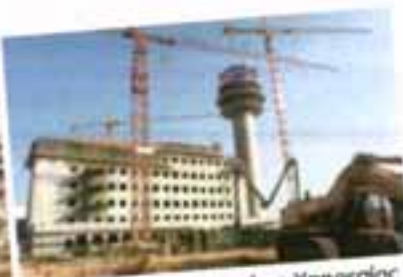
Πύργος ελέγχου & κτίριο Υπηρεσιών Πολιτικής Αεροπορίας (Αύγουστος '98)
