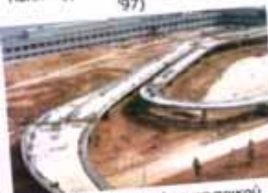
Σύνδεση από το κτίριο κεντρικού αεροσταθμού (Ιούλιος '00)
