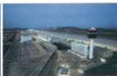
Κτίριο πύργου ελέγχου & κτίριο τηλεπικοινωνιών
