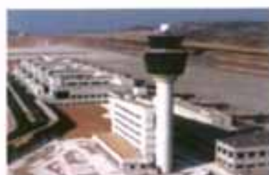
Πύργος Ελέγχου & κτίριο τηλεπικοινωνιών
