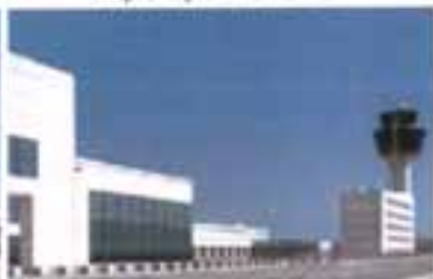
Κτίριο κεντρικού αεροσταθμού
