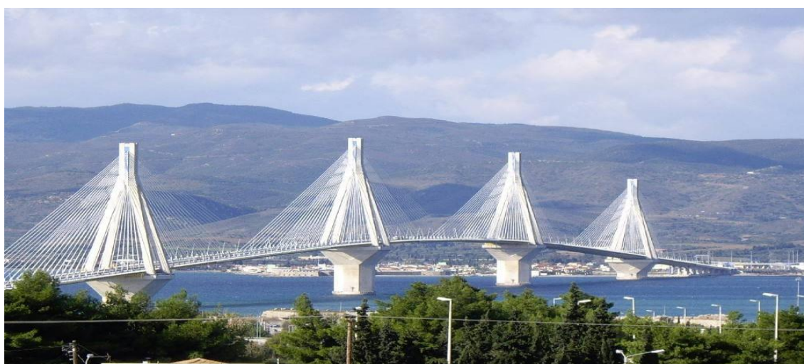
Εικόνα 3.2 Η γέφυρα Ρίου - Αντιρρίου
