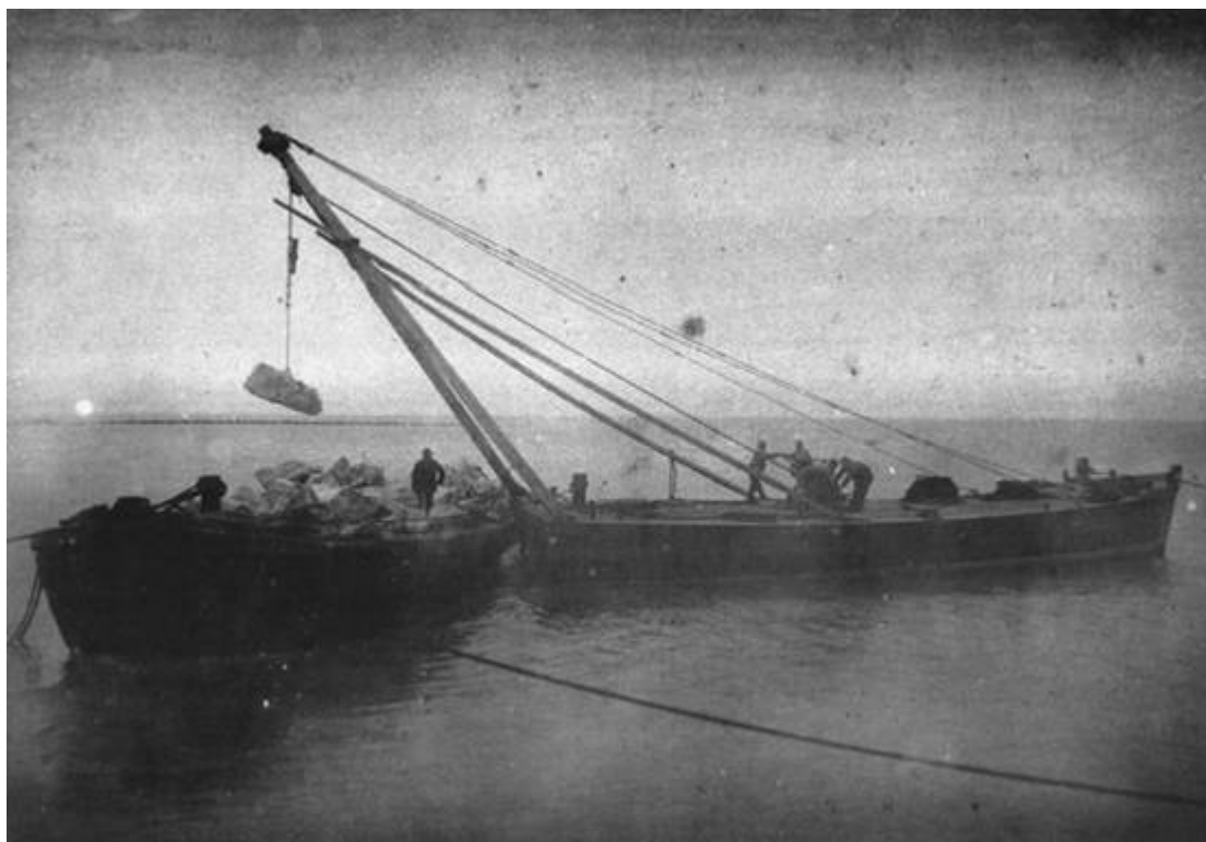
Εικόνα:4 Έργα κατασκευής κυματοθραύστη 19 ο αιώνα, Πηγή: http://www.e-patras.gr/
