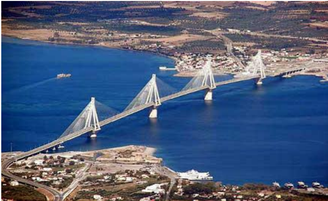
Εικόνα: 11 Γέφυρα Ρίου – Αντιρρίου, Πηγή: http://diolkos.blogspot.gr/
