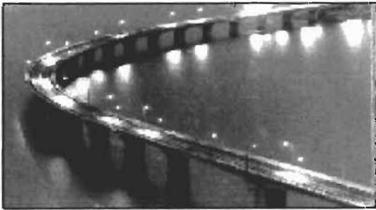
Εικόνα 3 Γέφυρα της Σουηδίας
