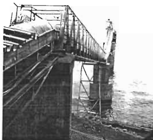
Αποψη της γέφυρας του κέντρου Διανομής Ηρακλείου
