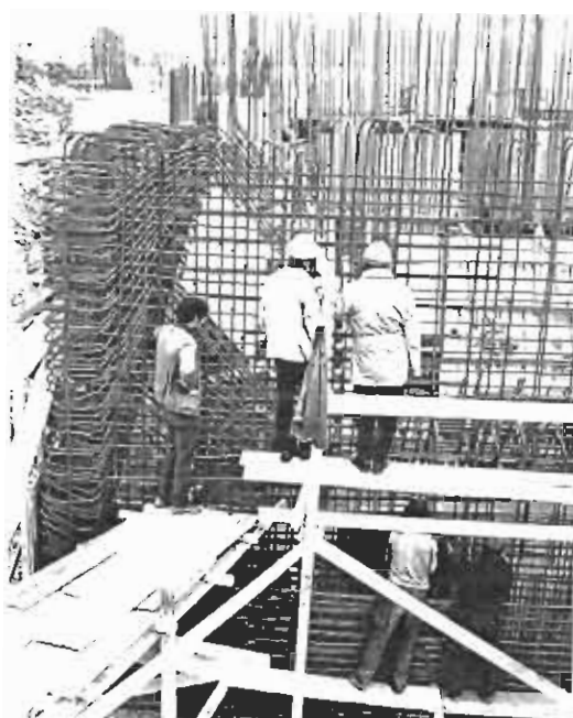
Στις «επαλξίες» την εποχή των κατασκευών
