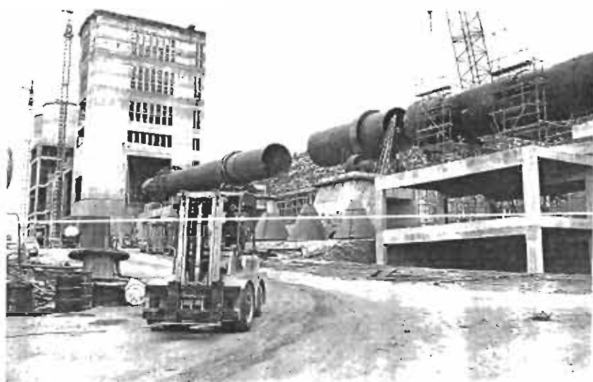
Νοεμβρίου 1994 Συναρμολογήση των τμημάτων του κλίβανου της πρώτης μονάδας
