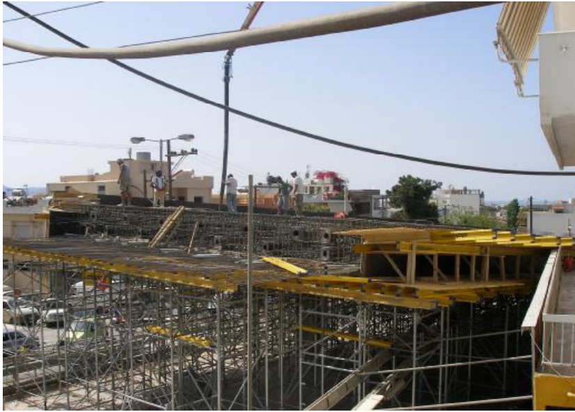
Εικόνα 12 Σκυροδέτηση ανωδομής 1 ης φάσης
