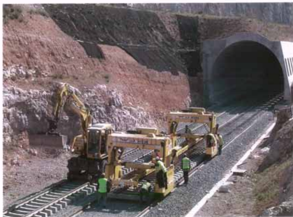
Εικόνα: Εργασίες για τη διάστρωση στρωτήρων
