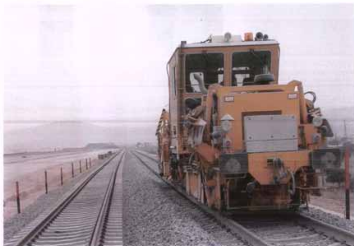
Εικόνα: Μηχάνημα διαμόρφωσης έρματος (ρεγκαλέζα)
