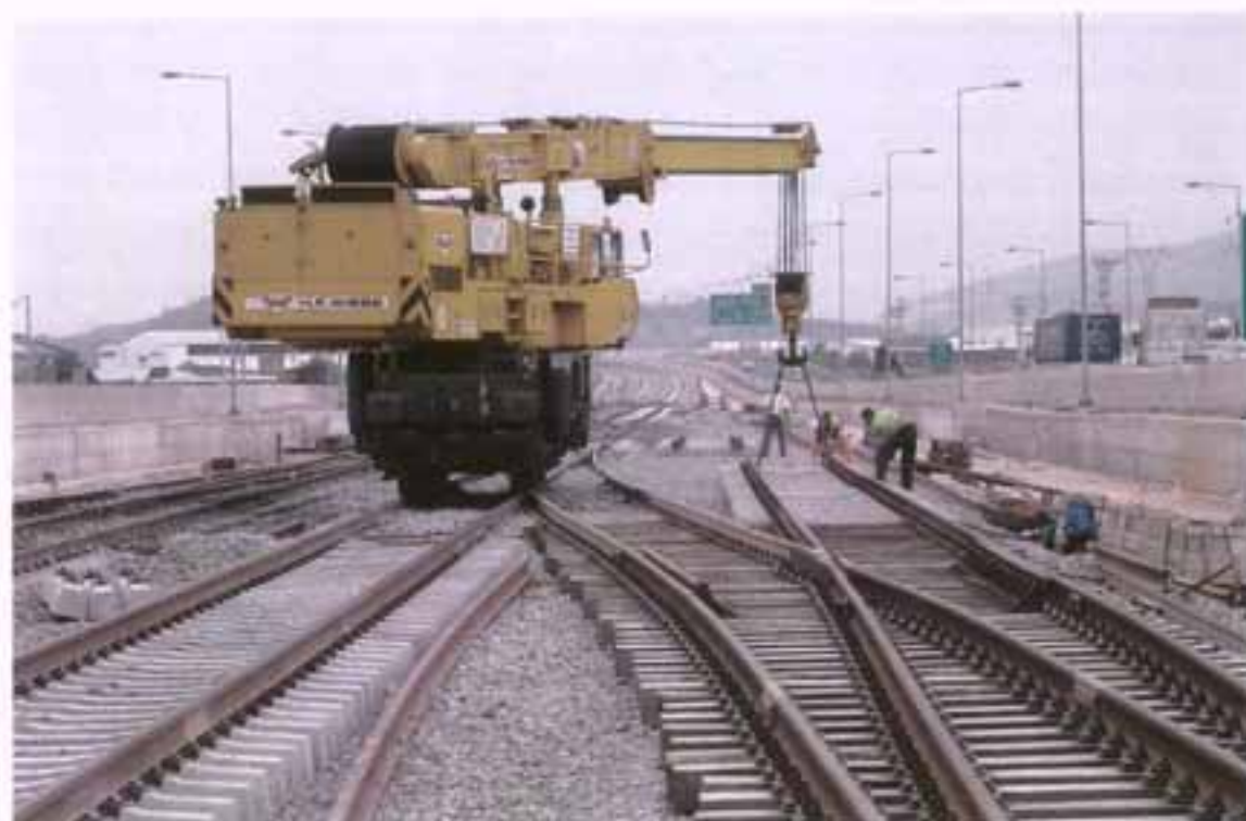
Εικόνα: Στρώση σιδηροδρομικής γραμμής
