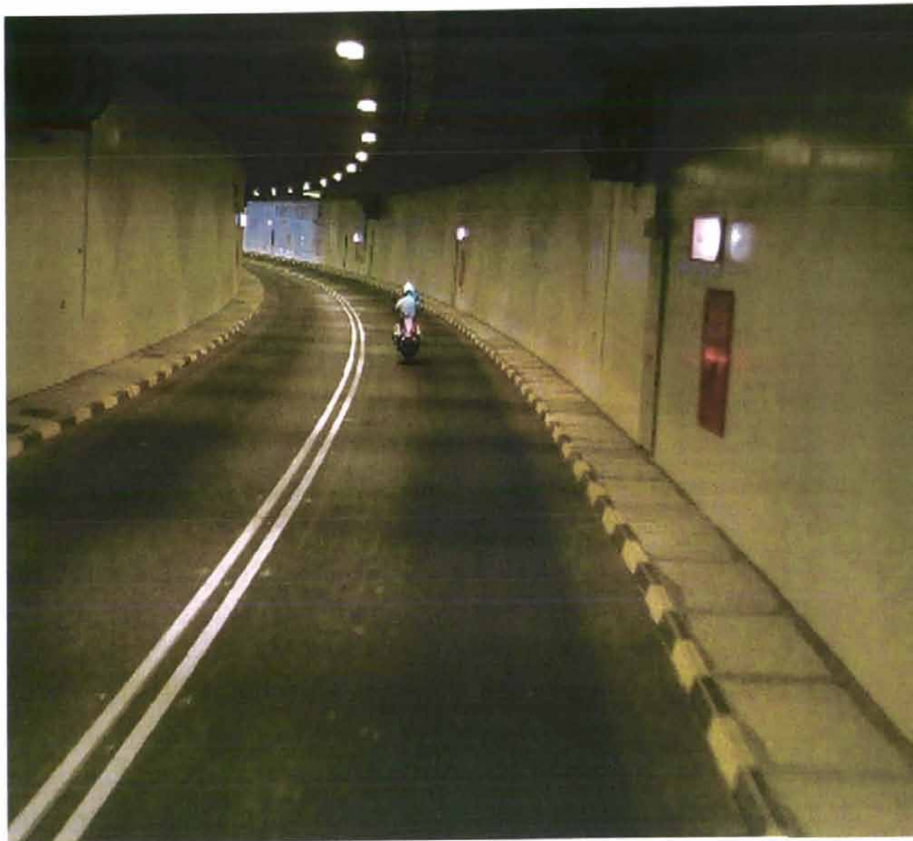
Το υποθαλάσσιο τμήμα της σήραγγας Ακτίου – Πρέβεζας.
