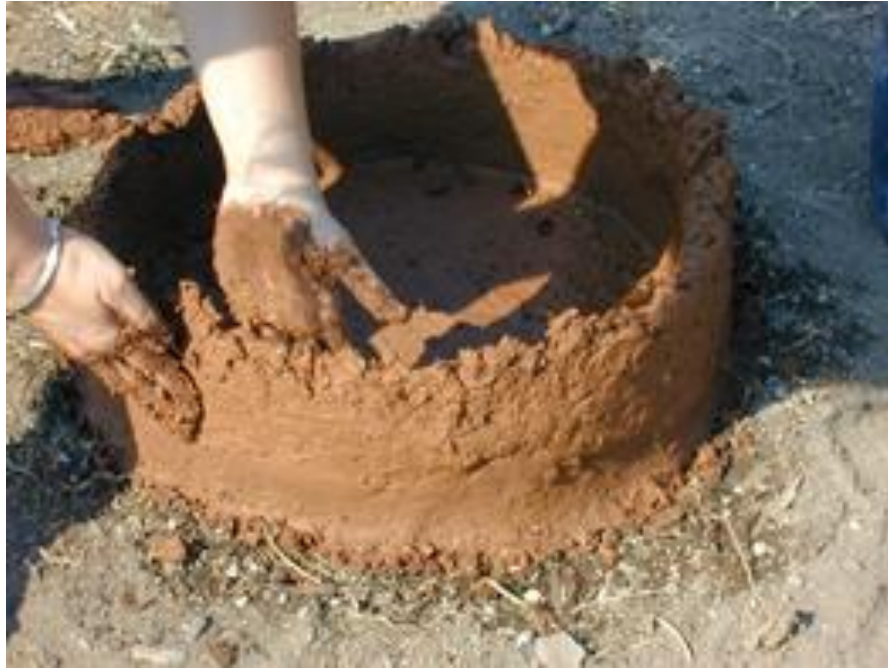
Εικόνα 7. Πειραματική κατασκευή ενός αποθηκευτικού δοχείου (σιρού): λείανση των κουλούρων από πηλό χτισίματος
