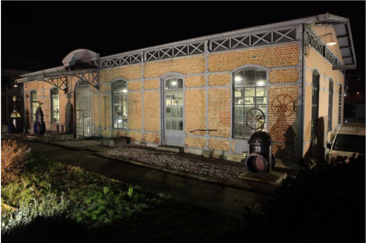
Εικόνα 30: Εξωτερική Άποψη Μουσείου Ύδρευσης Θεσσαλονίκης.
