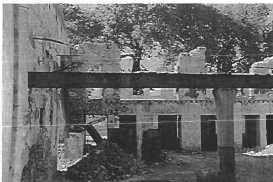
Πρώην αποθήκη σταφίδας Γρούνιζου στο λιμάνι Αιγίου
