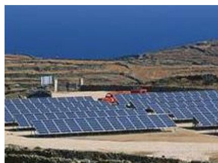
Εικόνα 4.3: φωτοβολταϊκά συστήματα ΒΙ.ΚΗ
