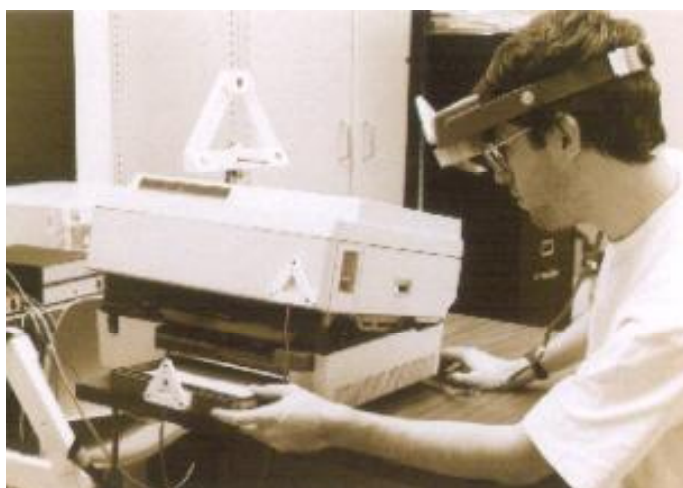
Εξωτερική όψη της εφαρμογής συντήρησης laser εκτυπωτών στο Columbia[7]
