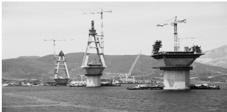
Εικόνα 18 Οι υπό κατασκευή πυλώνες
