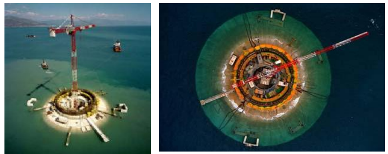
Εικόνα 8 Τα βάρη των πυλώνων της γέφυρας
