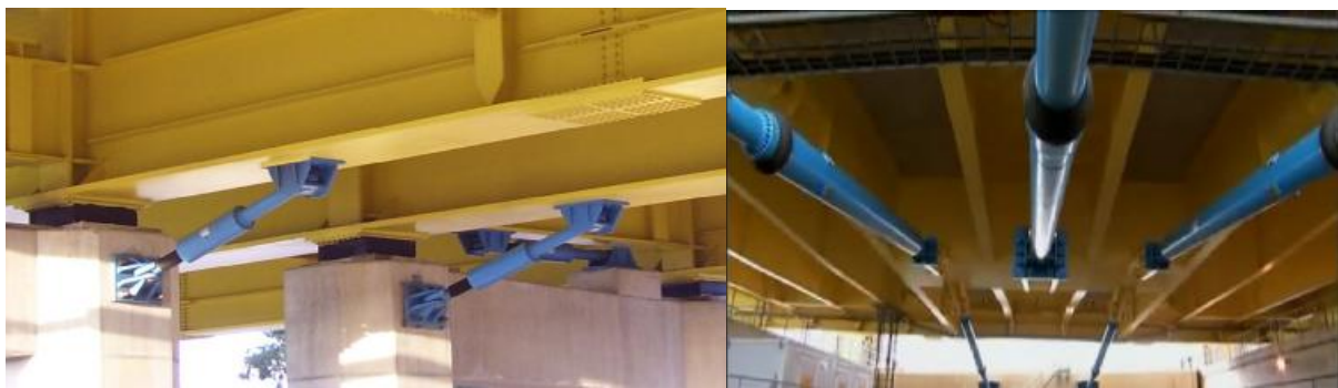
Εικόνα 19 Οι αποσβεστήρες που βρίσκονται μεταξύ οδοστρώματος και σκυροδέματος, κάτω από το κατάστρωμα της γέφυρας
