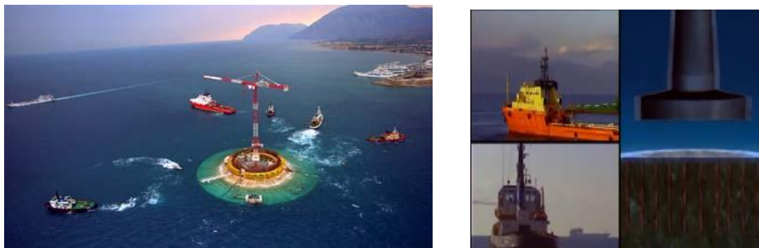
Εικόνα 9 Η διαδικασία πόντισης των βάθρων των πυλώνων
