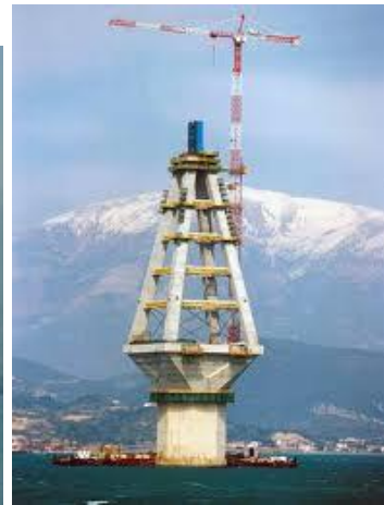
Εικόνα 17 Οι υπό στήριξη πυλώνες και οι τεράστιες σταυρωτοί δοκοί που τους αγκαλιάζουν
