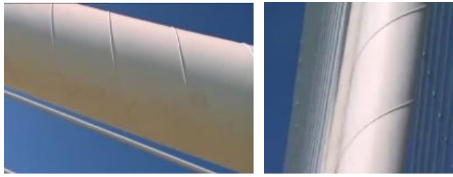
Εικόνα 22 Το σπειροειδές εξόγκωμα γύρω από τα καλώδια
