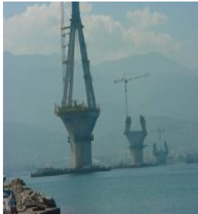
Εικόνα 17 Οι υπό στήριξη πυλώνες και οι τεράστιες σταυρωτοί δοκοί που τους αγκαλιάζουν
