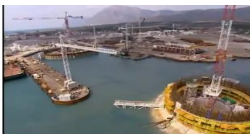
Εικόνα 16 Η κατασκευή του πρώτου πυλώνα
