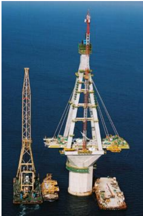
Εικόνα 17 Οι υπό στήριξη πυλώνες και οι τεράστιες σταυρωτοί δοκοί που τους αγκαλιάζουν
